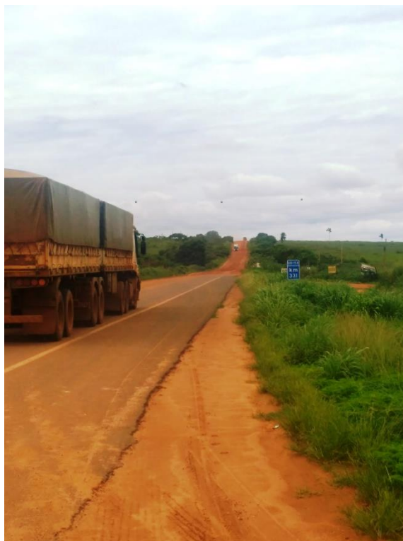
Figura 9– BR-158: fim do trecho pavimentado em Alô Brasil (Bom Jesus do Araguaia). Fonte: Lourenço (2018).
