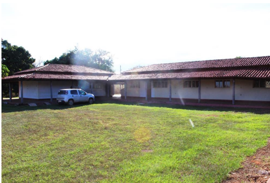
Figura 16- parte do casarão que servia de sede para a antiga fazenda Bordon S/A Agropecuária, atualmente PDS Bordolândia. Fonte: Lourenço (2018).
