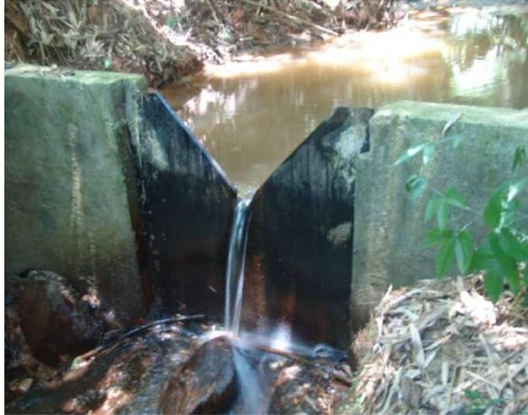
Figura 38 – Vertedor triangular de 90° instalado na estação Caximonan 01.
