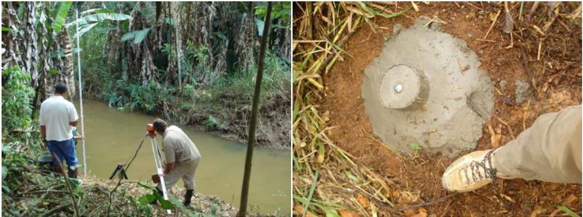
Figura 40 – Construção de seção de régua linimétrica. Esq.: nivelamento topográfico da seção de régua. Dir.: detalhe do RN (referência de nível).
