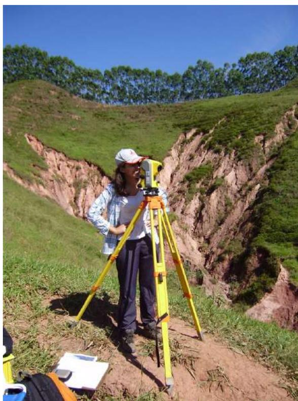
Figura 51 – Levantamento do contorno das voçorocas com a utilização de estação total com o apoio da rede de marcos permanentes e temporários. Na foto, observa-se o levantamento do contorno da Voçoroca 02 a partir do marco temporário #11.
