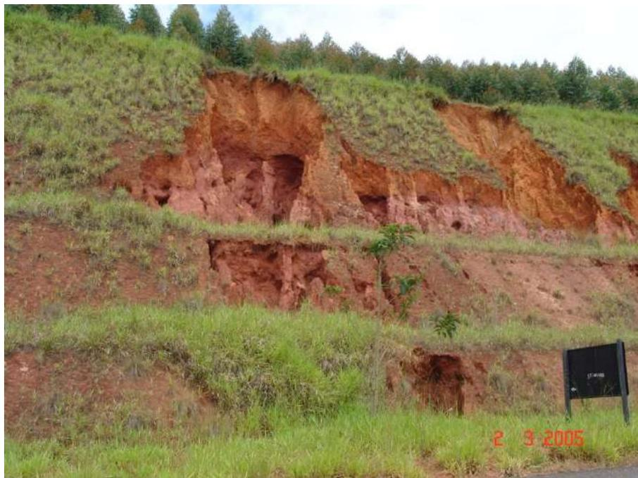
Figura 88 – Feições de erosão por água subsuperficial no corte da estrada Queluz-Areias/SP (SP-058).
