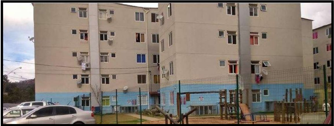
Figura 14 - Pátio dos condomínios visto da rua (Na foto, Terra Nova 6)
