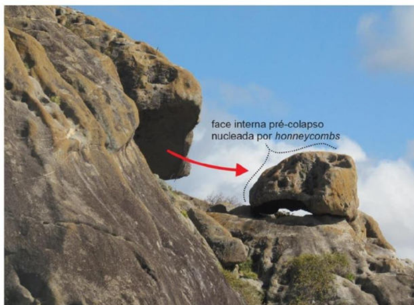
Figura 8. Cavidade de colapso em inselberg granítico. (Quixadá/CE, 2016)
