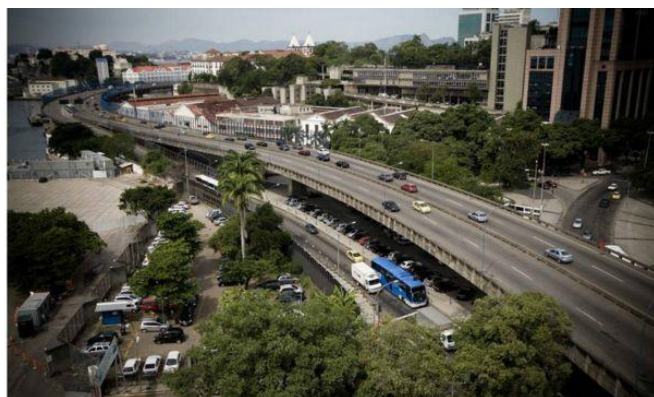
Figura 3 – Elevado da Perimetral antes da demolição
