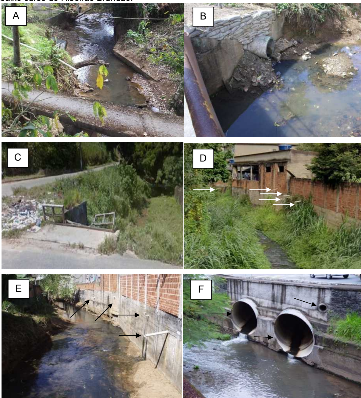
Figura 5.18: A e B – Imagens do Córrego Santa Luzia (setor Centro-Norte da cidade) com materiais tecnogênicos acumulados na sua calha; em A, estrutura de ponte adaptada e margens com elementos confinantes precários canalizando o córrego; em B, margem com estrutura de sacos de solo-cimento empilhados sobre manilha de médio porte; C – Acúmulo de lixo e entulhos adjacente à estrutura danificada sobre o Córrego do Peixe (bairro Santa Rita do Zarur); D – Margens confinadas por muros de residências, com destaque para os canos de descarte de resíduos domésticos no Córrego Bugio (bairro Belmonte – Setor Oeste); E – Margens também confinadas por muros de residências, com materiais acumulados pelo descarte de esgoto e águas pluviais no Córrego do Peixe; F – Manilhas no baixo curso do Ribeirão Brandão.
