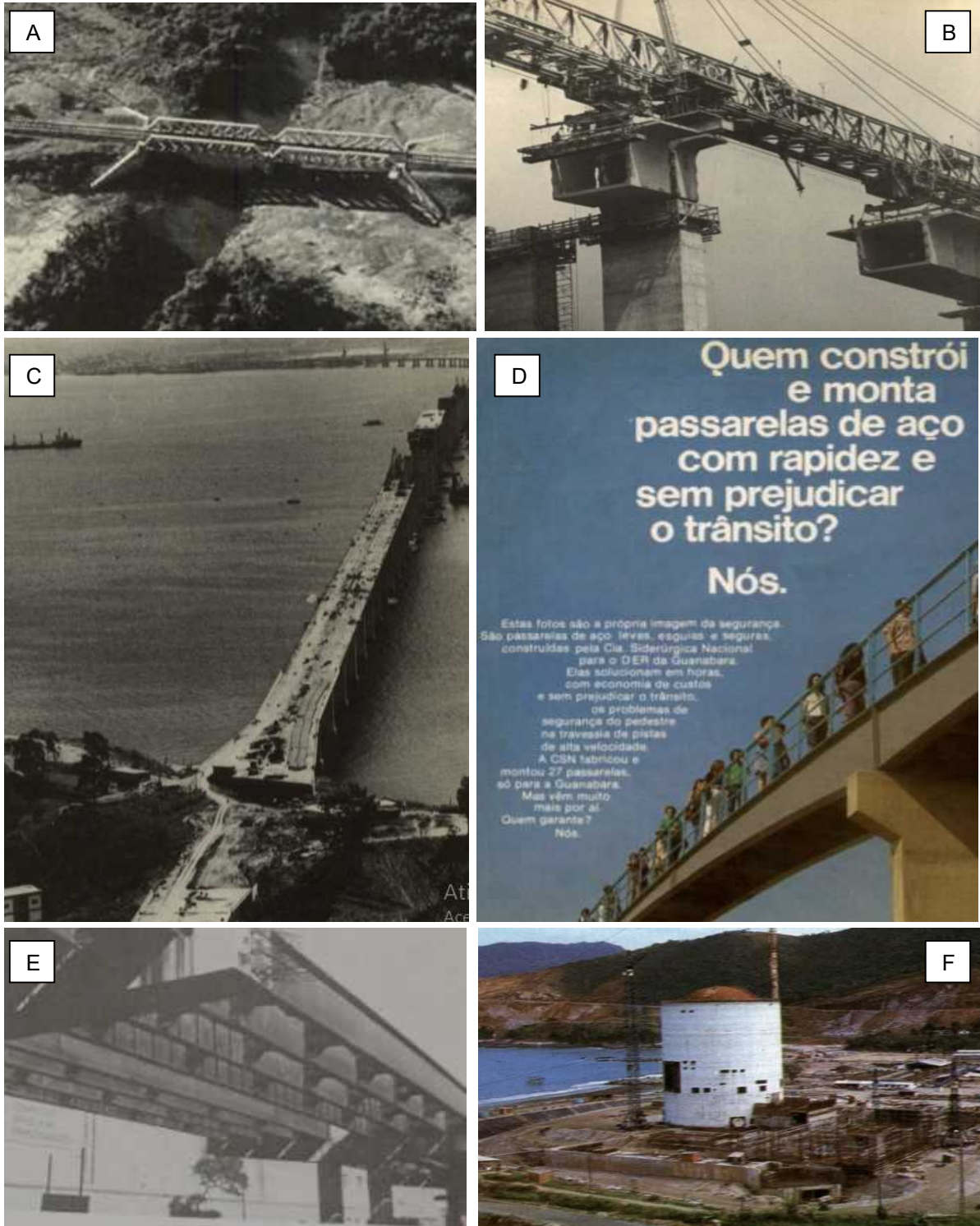
Figura 4.32 – Diferentes estruturas em aço desenvolvidas pela CSN nos anos 1970. Em A – Ponte ferroviária da Alcominas em 1971 (Poços de Caldas/MG); B – Detalhe da construção da Ponte Rio-Niterói; C – Ponte Rio-Niterói em fase de ser concluída em 1973; D – destaque para uma das passarelas em uso na Avenida Brasil, em 1972 (Rio de Janeiro/RJ); E – estruturas em aço do elevador da Perimetral (Rio de Janeiro/RJ) em 1978 e; F – construção da usina nuclear de Angra I (Angra dos Reis/RJ).
