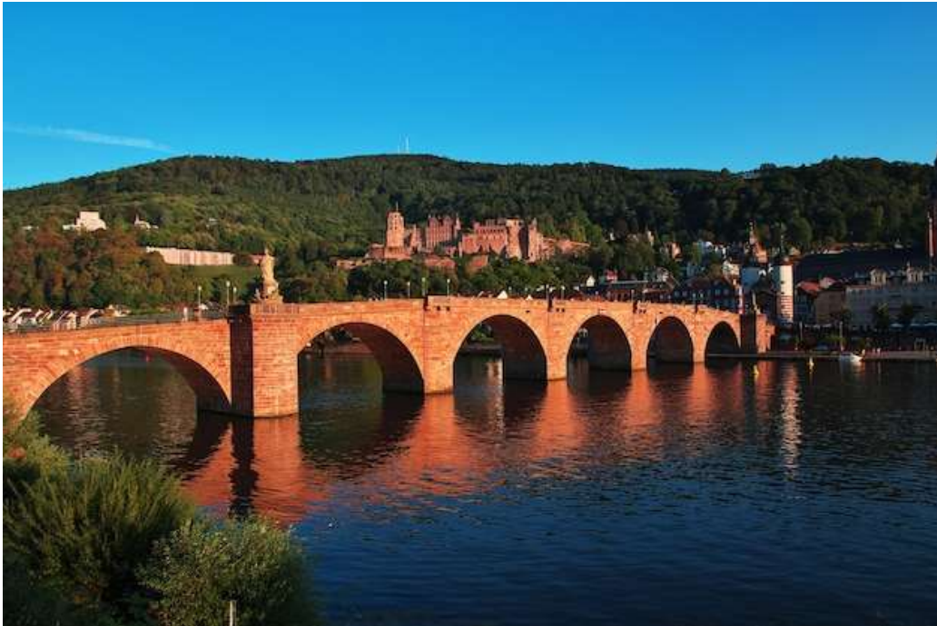
Figura 3: Ponte Karl Theodor, localizada na cidade de Heidelberg, Alemanha. Fonte: https://br.freepik.com/fotos-premium/a-velha-ponte-em-heidelberg-alemanha_16155605.htm . Acesso em: 20 Abr 2022
