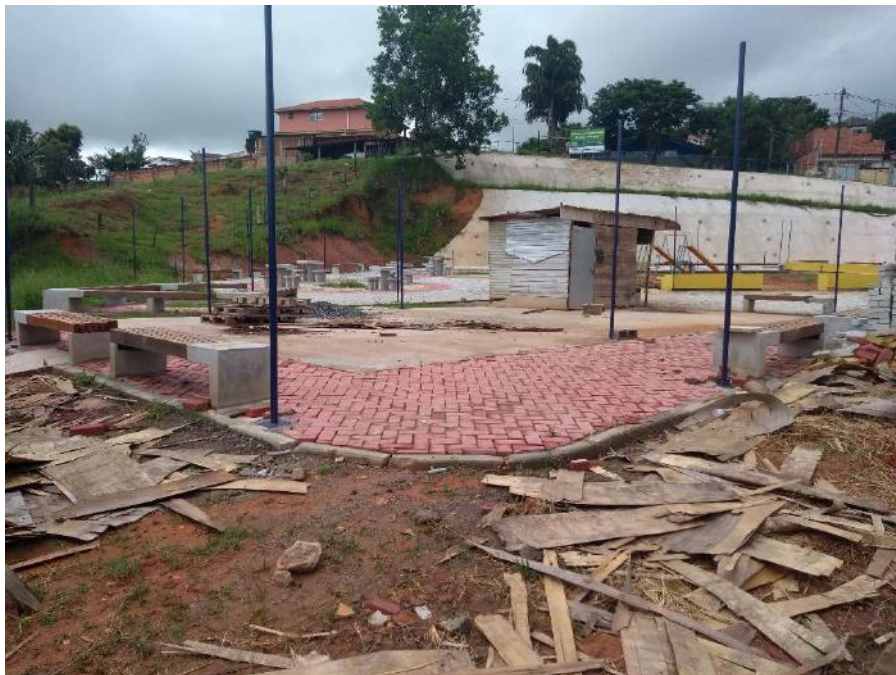
Fotografia 3 - Bairro Alto do Surubi, Resende/RJ– Reforma da antiga “Praça pública” do Bairro (2015) Fonte: trabalho de campo realizado em 13 e 14 de janeiro, de 2020. Organizado por: Monique Bastos, 2020.
