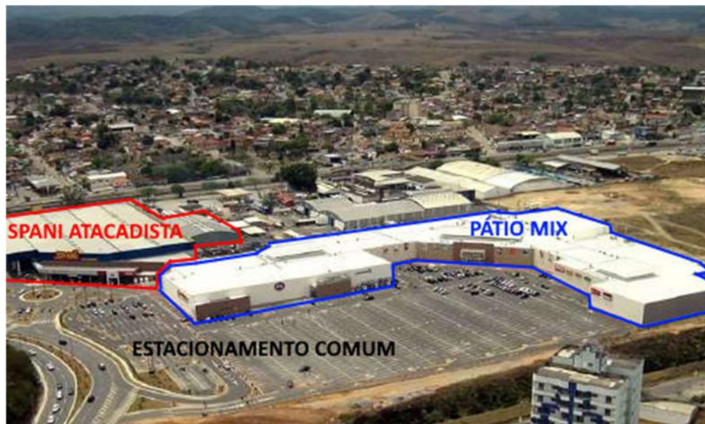
Fotografia 4: Resende/RJ - Vista aérea do complexo Supermercado Spani - Shopping Center Pátio Mix (2020)
