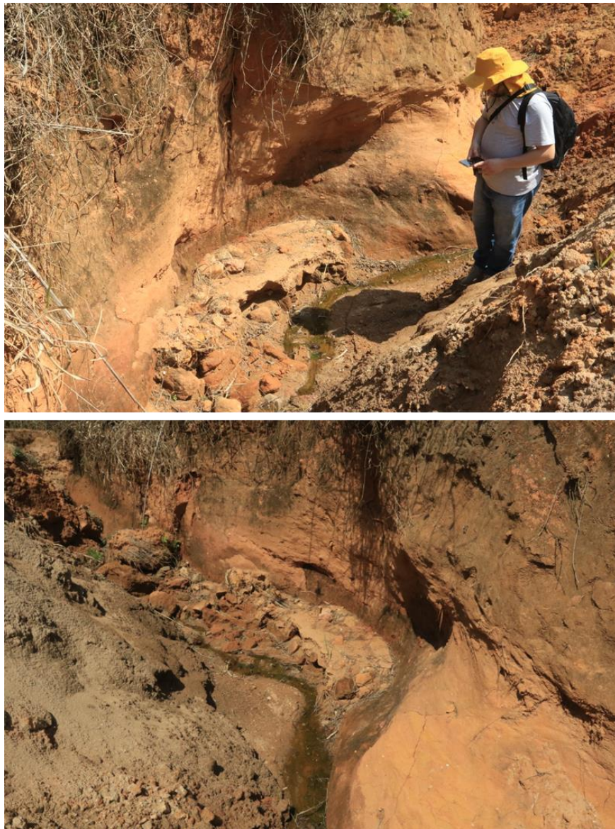
Figura 12: Aspectos do canal erosivo no interior da Voçoroca do Minério, com evidência de fluxo contínuo. (Silva, 2022)
