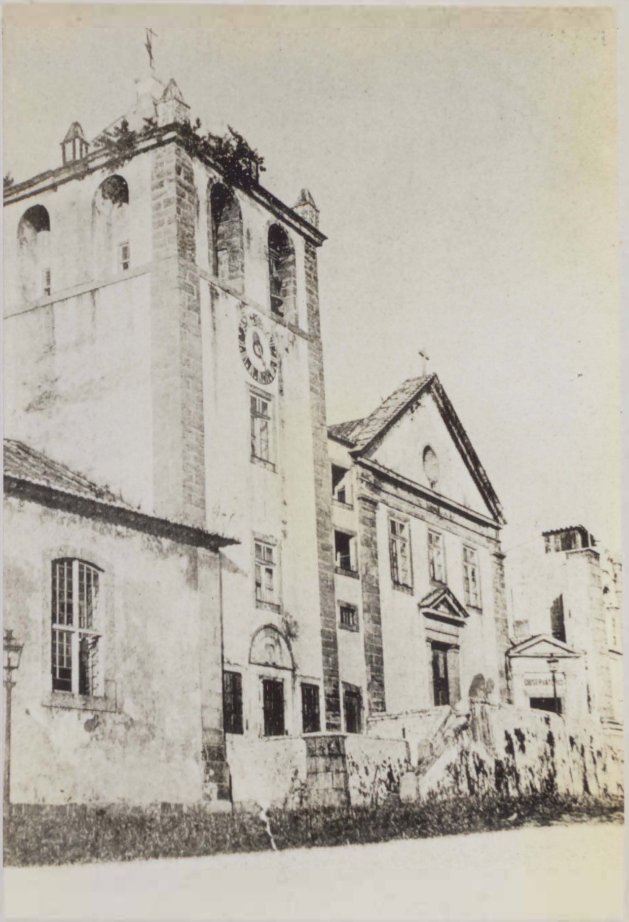
FIGURA N o 68: Antiga Igreja de S to Inácio (1905).
