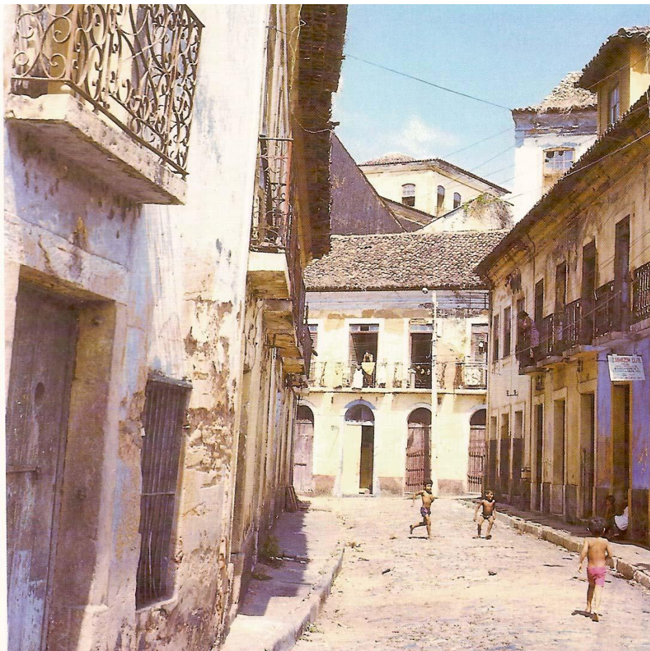
Figura 07 – Rua do Centro Histórico, antes da revitalização.
