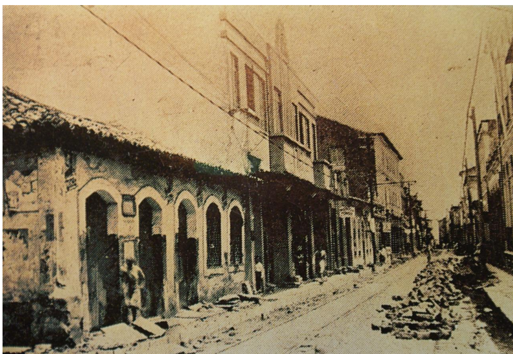
Figura 16 – Obra de pavimentação da Rua Grande. 1950
