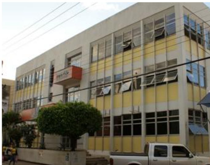
Figura 49 – Prédio da Secretaria de Estado da Educação, situado na quadra 09A, da pesquisa.
