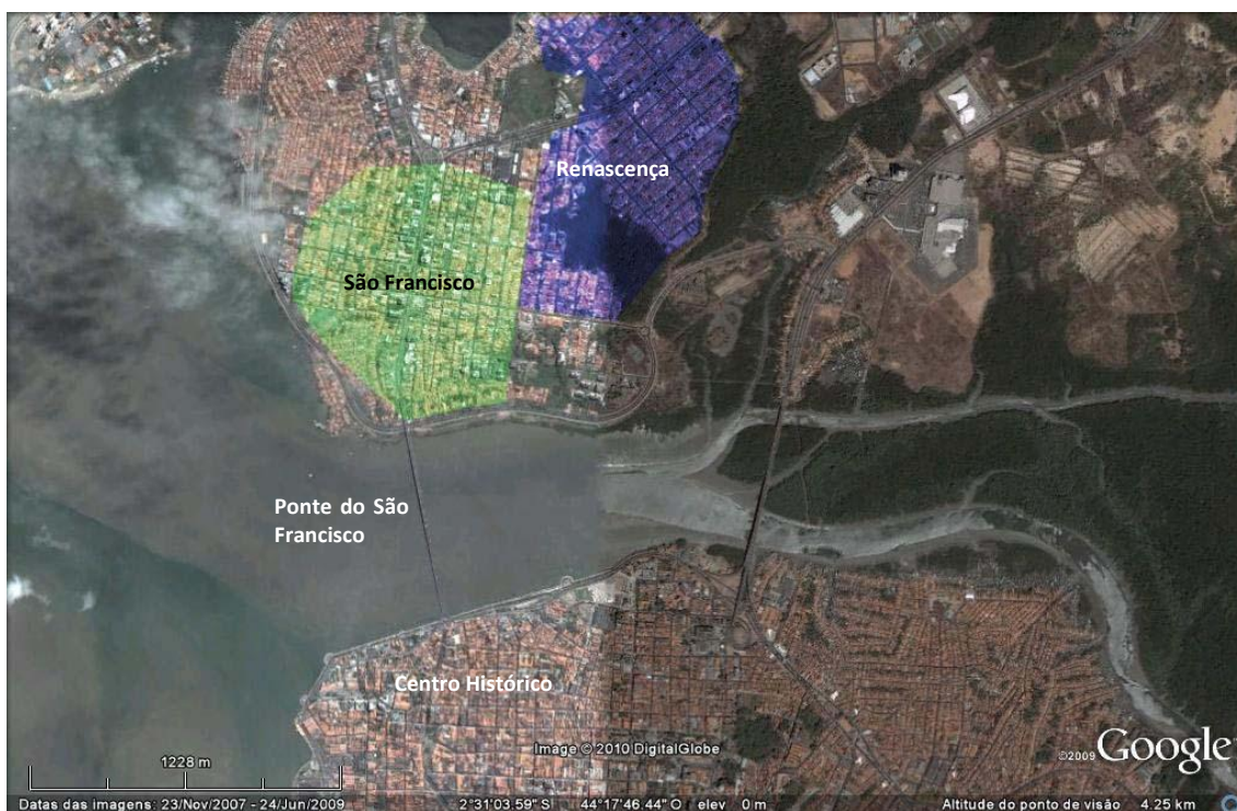
Figura 22 – Ponte do São Francisco
