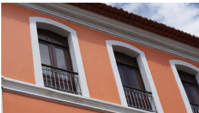
Figura 107 – Detalhe de janelas com balcão entalado. Imóvel 22, quadra 02.
