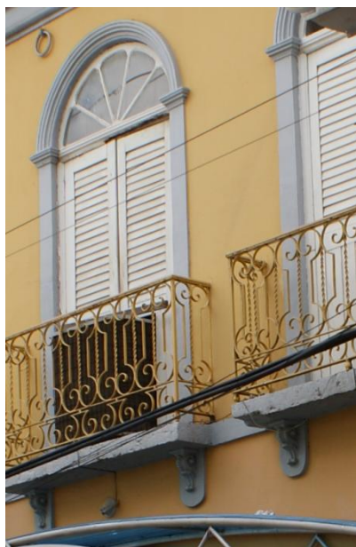
Figura 109 – Detalhe de janelas com balcão lançado. Imóvel 46. quadra 03A. Fonte: Acervo pessoal. Junho/2010.
