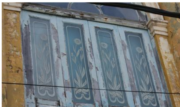
Figura 40 – Detalhe do vidro da janela da residência da quadra 06A, da pesquisa.
