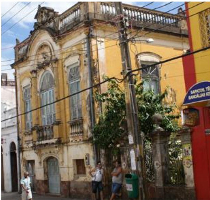
Figura 38 – Residência da quadra 06A, da pesquisa.
