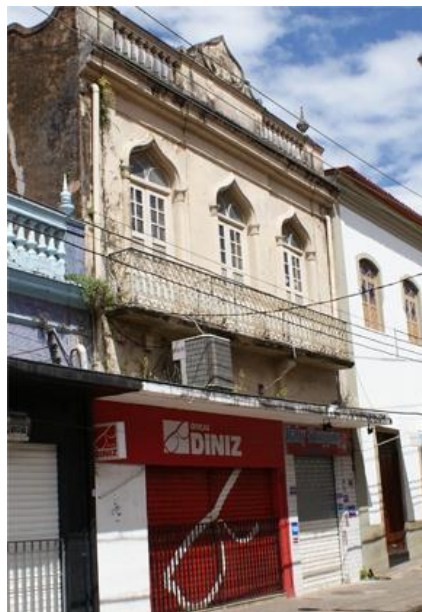
Figura 45 – Imóvel de fachada eclética com detalhes neo-góticos na quadra 04, da pesquisa.
