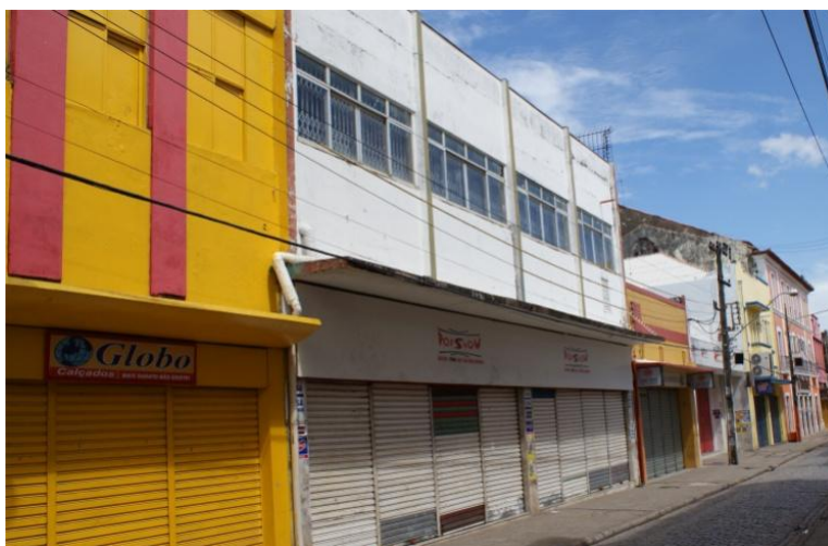
Figura 55 – Configuração atual de quadra na Rua Grande.
