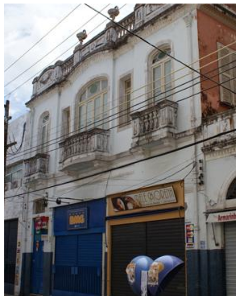
Figura 60 – Prédio da Farmácia Garrido, atualmente. Fonte: Acervo pessoal. Junho/2010
