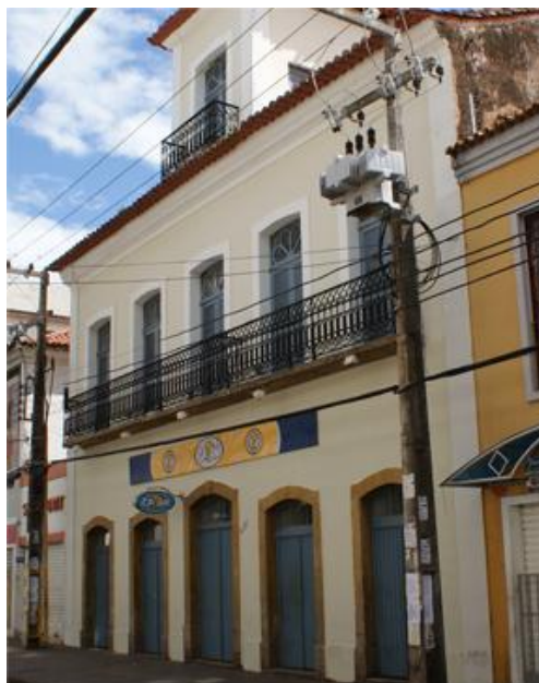
Figura 28 – Sobrado na Rua Grande, situado na quadra 05A, da pesquisa.
