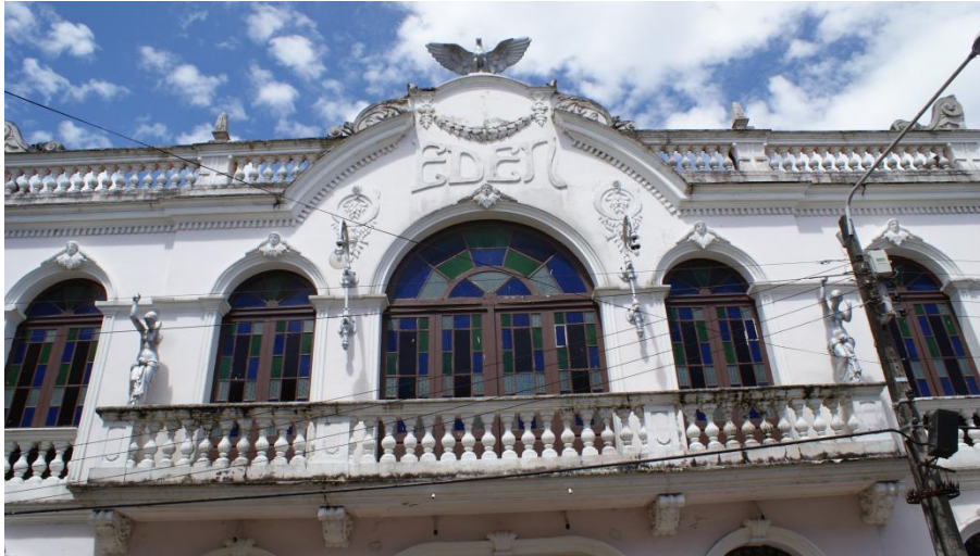
Figura 76 – Detalhe da fachada do Cine Eden.
