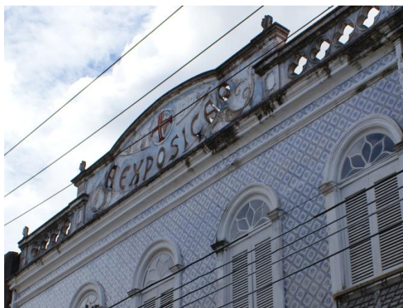
Figura 110 – Detalhe da platibanda do Imóvel 11, quadra 01A.
