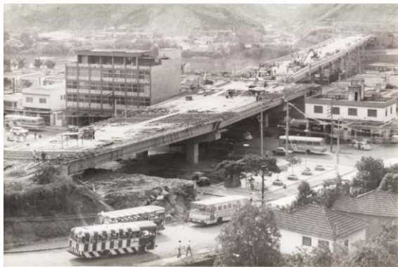
Fig. 58 - Construção do viaduto da Ponte alta – Dec. 1970. Acervo C. Penedo.
