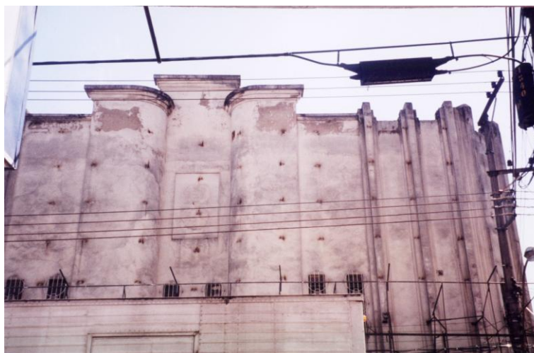
Fig. 94 - Retirada do painel metálico da Fachada do edifício do antigo Cinema Palácio para reforma, atual Casas Bahia – Foto: Andréa Auad - Maio de 2002
