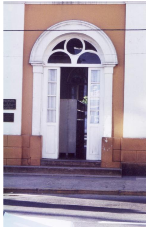
Fig. 113 - Portal da antiga Estação Ferroviária, atual Biblioteca Municipal. Foto: Andréa Auad – 2001
