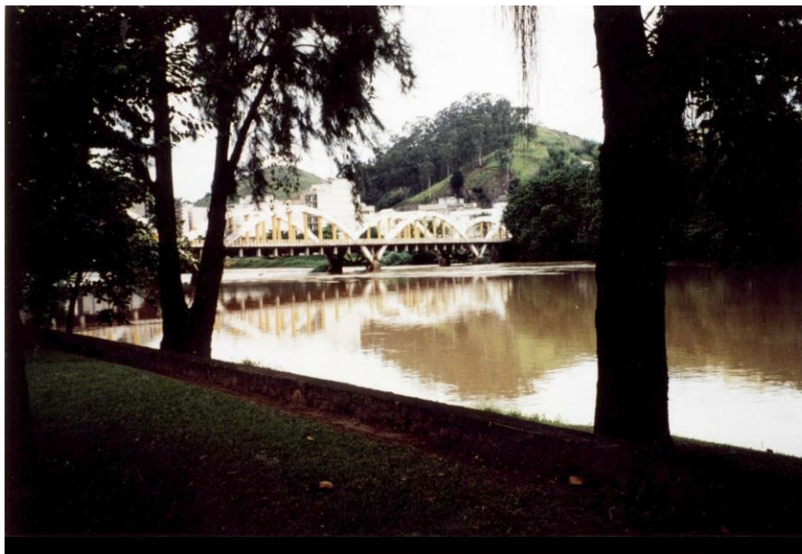
Fig. 131 - Ponte dos Arcos – Foto: Andréa Auad - 2001
