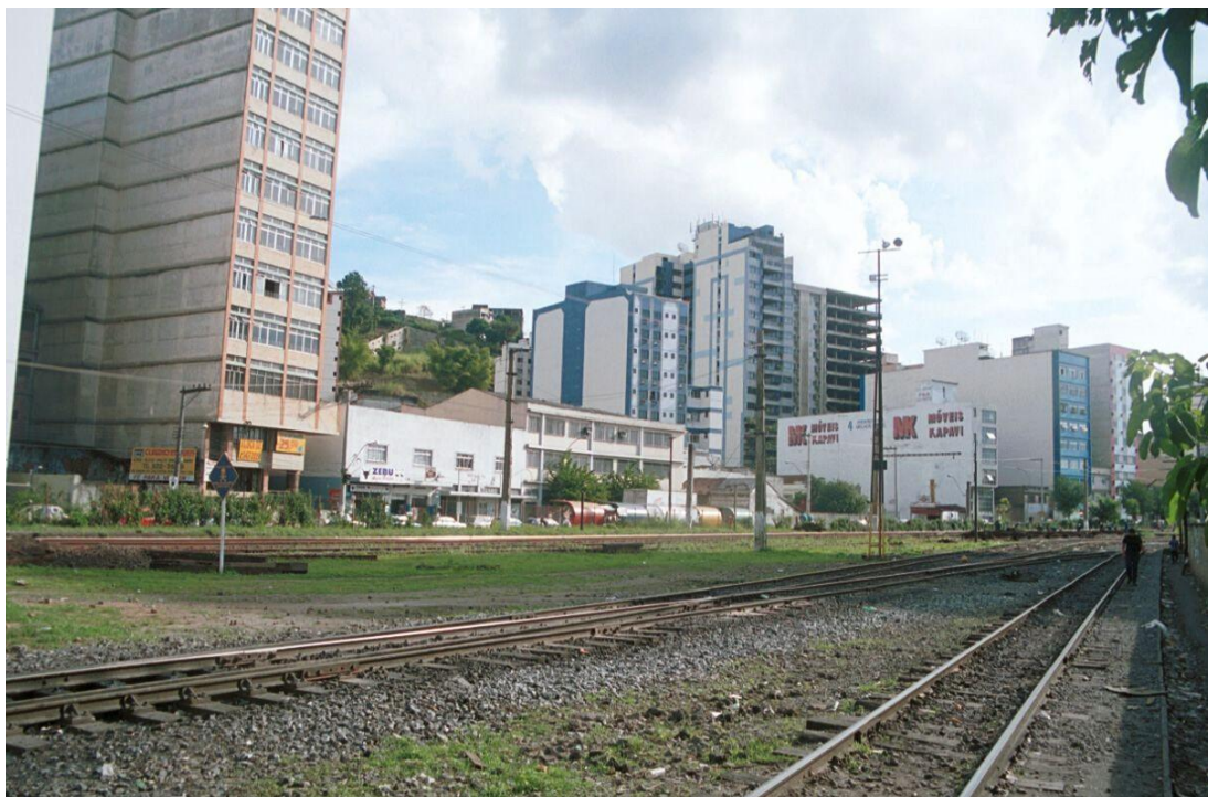
Fig. 140 - Pátio férreo junto à passagem de nível da antiga Estação Ferroviária Foto: Airton Soares - 2001.
