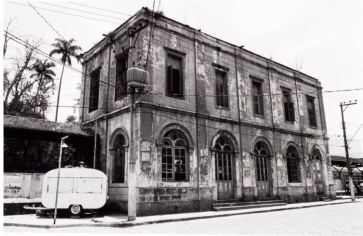
Fig. 86 - Estação Ferroviária após o incêndio de janeiro de 1988. Acervo Clécio Penedo.
