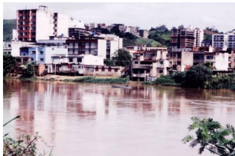
Fig. 81 - Margem direita do rio Paraíba do Sul, Área Central Foto: Andréa Auad, 2001
