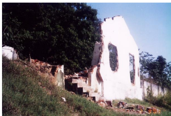
fig. 151 - Ruína da última unidade residencial da vila Bárbara. foto Ariadne Silva - 2001.
