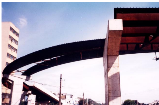
Fig. 114 - Construção do Viaduto dos Trabalhadores - 2001
