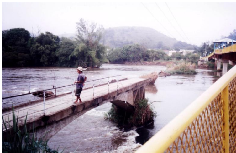
Fig. 157 - Nova passagem de pedestres sobre o rio Paraíba do Sul, junto aos destroços da antiga Ponte Mauá - Foto: Regina Célia - 2001
