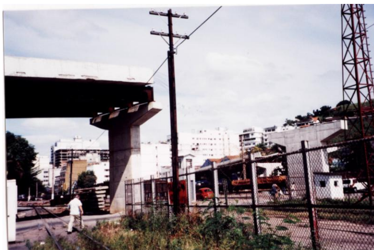
Fig. 93 - Construção do Viaduto dos Trabalhadores – Foto: Andréa Auad, 2000
