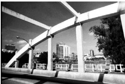
Fig. 112 - Ponte dos Arcos.. Foto: Jesse Chiesse 2001
