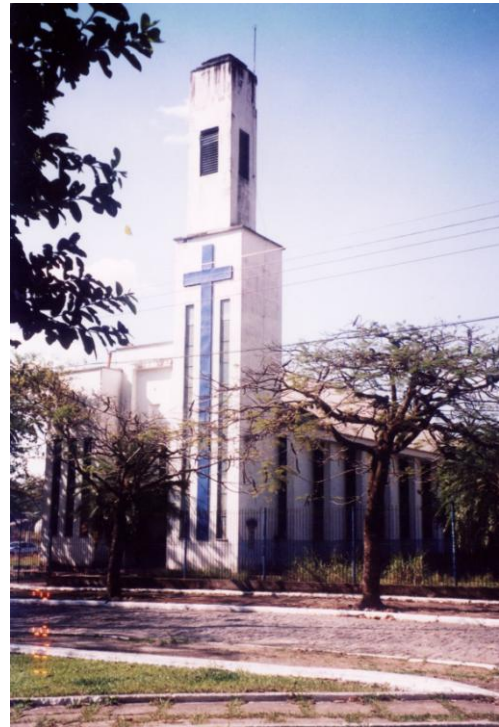
Fig. 148 - Igreja junto ao Colégio Estadual Baldomero Bárbara - Construção da década de 1960 - Foto: Ariadne Silva – 2001
