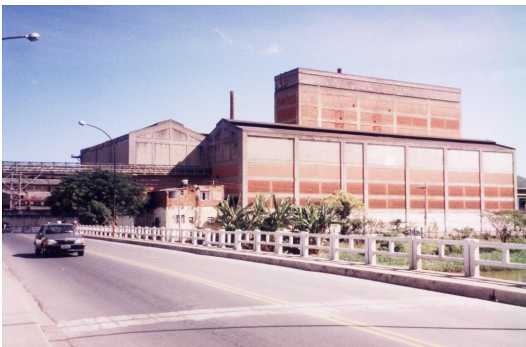
Fig. 145 - Siderúrgica Barra Mansa e a ponte ilustrada acima Foto: Andréa Auad - 2001
