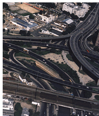
Fig. 148 - Vista aérea das ligações viárias.
