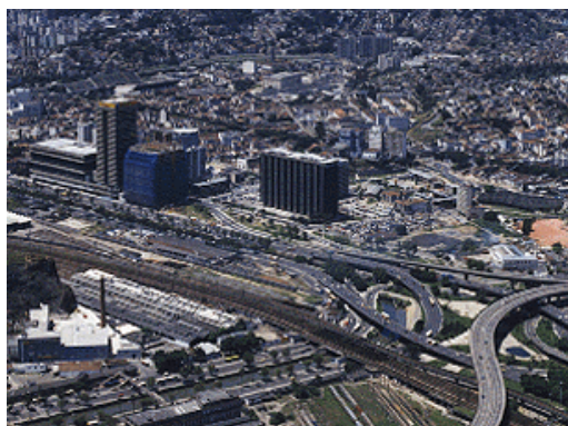
Fig.158 - Vista aérea Viaduto dos Pracinhos, obra em andamento.
