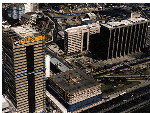
Fig.150 - Início da obra do prédio da Valia, a ser incorporado ao Teleporto.
