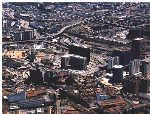
Fig.159 - Vista aérea fundo do terreno, obra em andamento.
