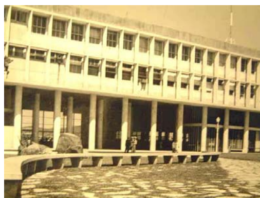
Fig. 121 - Estação de Passageiros. Área de acesso.
