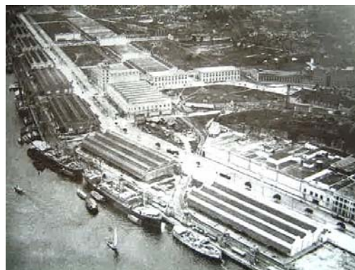
Fig. 35 - Vista aérea do porto, 1916.
