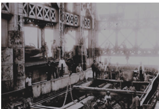
Fig. 21 - Estrutura interna da ensecadeira na concretagem do caixão.
