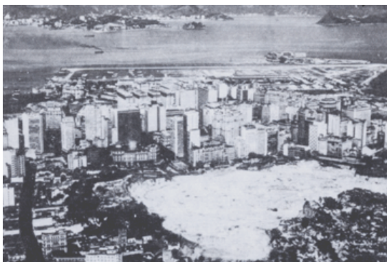
Fig.133 - Desmonte do Morro de Santo Antônio, s/d.
