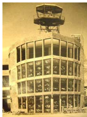
Fig. 113 - Construção da Torre de Controle.
