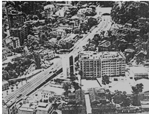
Fig. 139 - Viaduto de acesso ao Túnel Santa Barbara ( Catumbi - Laranjeiras), Laranjeiras, s/d.
