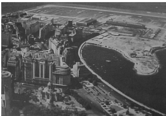
Fig. 116 - Vista aérea do aterro, após a obra.
