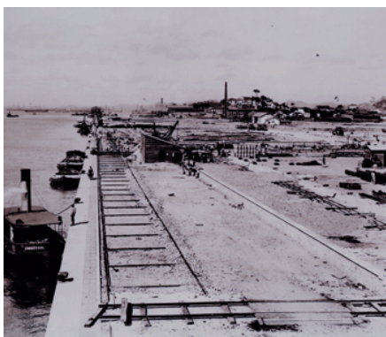
Fig. 28 - Aterro em conclusão, s/d.
