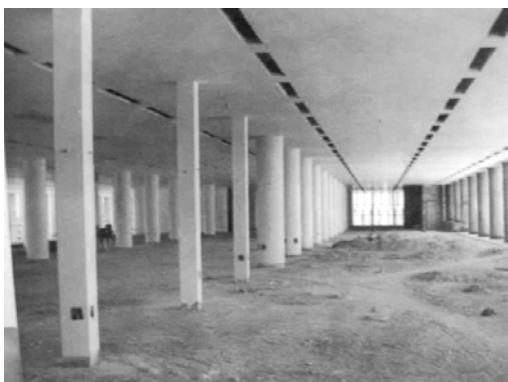
Fig. 112 - Vista interna do aeroporto da construção da Estação de Passageiros.
