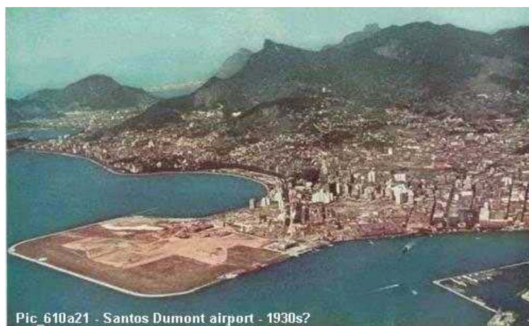
Fig.104 - Ponta do Calabouço - Aterro que formou o terreno para construção do aeroporto, já era usado para pousos. 1930's.
