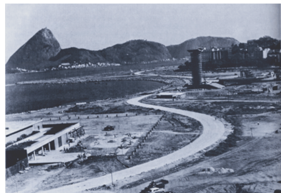
Fig.134 - Aterro do Flamengo em construção, 1958. Construção do bloco-escola do MAM e do Monumento dos Pracinhas.
