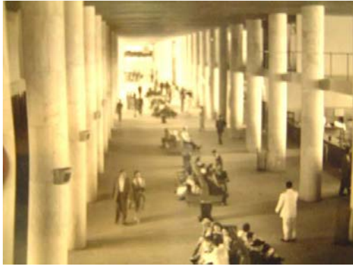
Fig. 122 - Hall interno da Estação de Passageiros.
