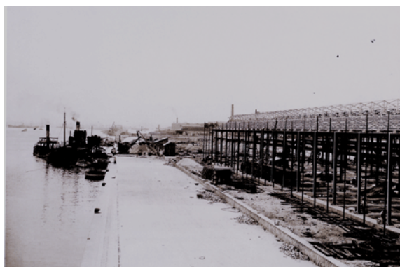
Fig. 29 - Aterro concluído, início construção dos armazéns, s/d.
