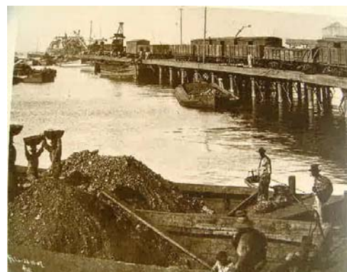
Fig.27 - Terminal marítimo da Estrada de Ferro, descarga de carvão. Ao fundo, a construção, 1907.
