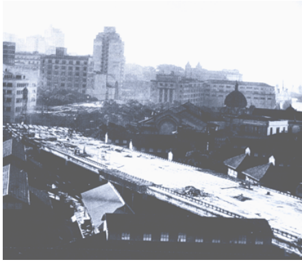
Fig. 136 - Construção da Av. Perimetral, meados de 1960's.
