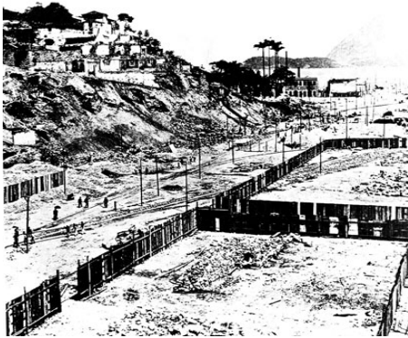
Fig.44 - Canteiro de obras da Av. Central, 1904.
