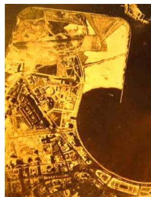
Fig.102 - Levantamento fotográfico do terreno para construção do aeroporto, 1937.
