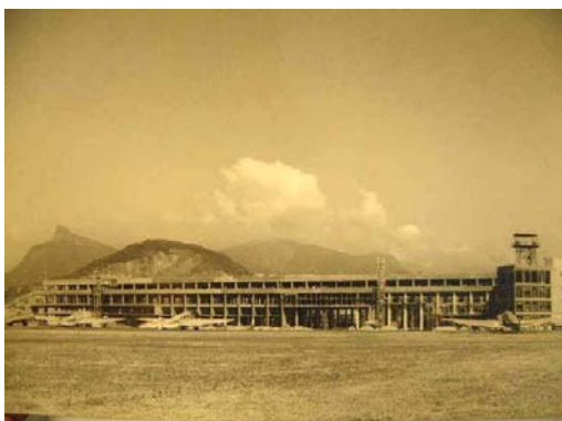
Fig. 114 - Vista geral da construção da Estação de Passageiros.
