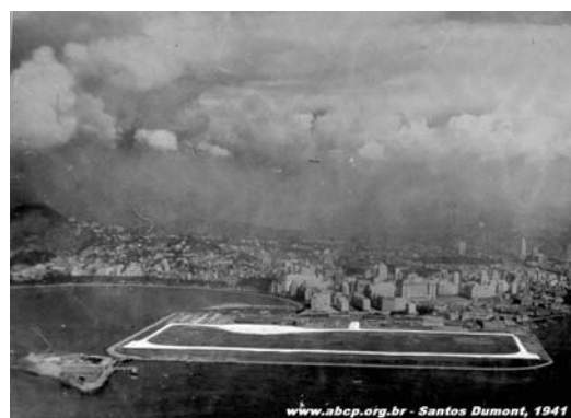
Fig.111 - Vista geral do aterro pronto com pistas, 1941.
