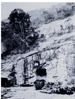
Fig.129 - Abertura túnel Catumbi - Laranjeiras - Sta. Bárbara, 1949.
