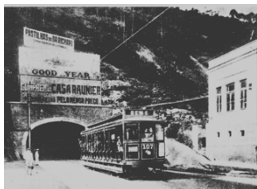
Fig. 15 - Túnel para o Leme, s/d
