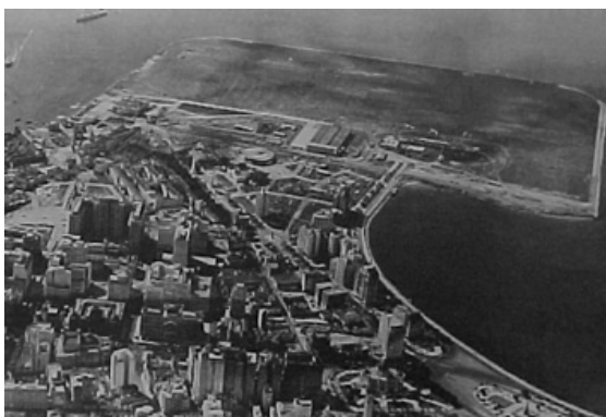
Fig.101 - Segunda etapa do aterro da Ponta do Calabouço concluída. Já é usado para pouso de pequenas aeronaves. s/d (1935)
