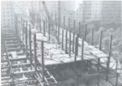
Fig. 08 - Edifício Av. Central em construção
