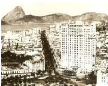
Fig. 04 - Panorama do Edifício A Noite, 1930
