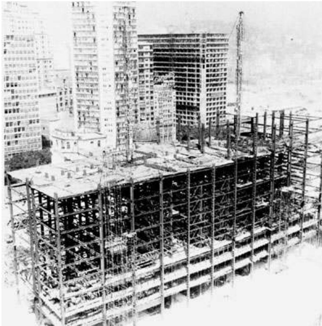
Fig. 27 - Av. Central em construção.
