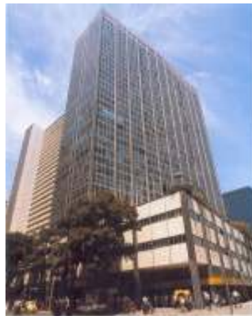
Fig. 09 – Edifício Av. Central já pronto
