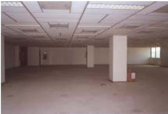
Fig. 39 - Pav. Tipo - Uso de materiais industriais modulados. Fonte: http://www.previ.com.br acesso: 05-03-06
