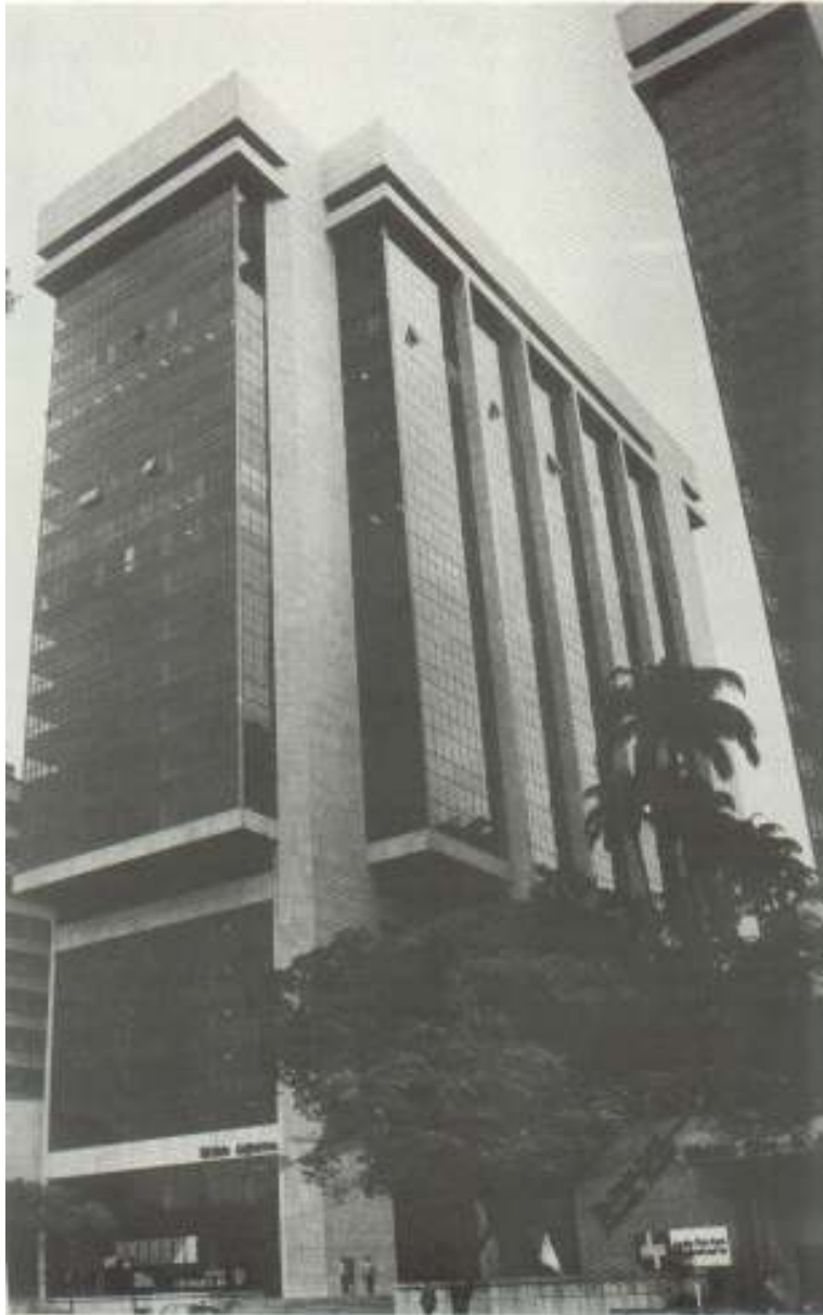
Fig. 32 - Varandas do edifício fechadas com vidro. Fonte: Revista Projeto nº 71 janeiro 85: 73-76
