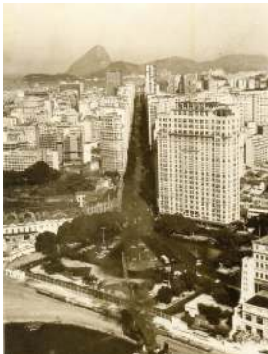
Fig. 03 - Praça Mauá e Avenida Rio Branco 1967.
