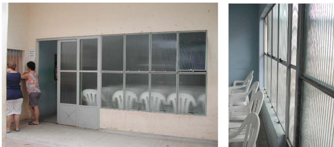
Figura 4.46 – Vista externa e interna da atual situação das aberturas na fachada de acesso à unidade.
