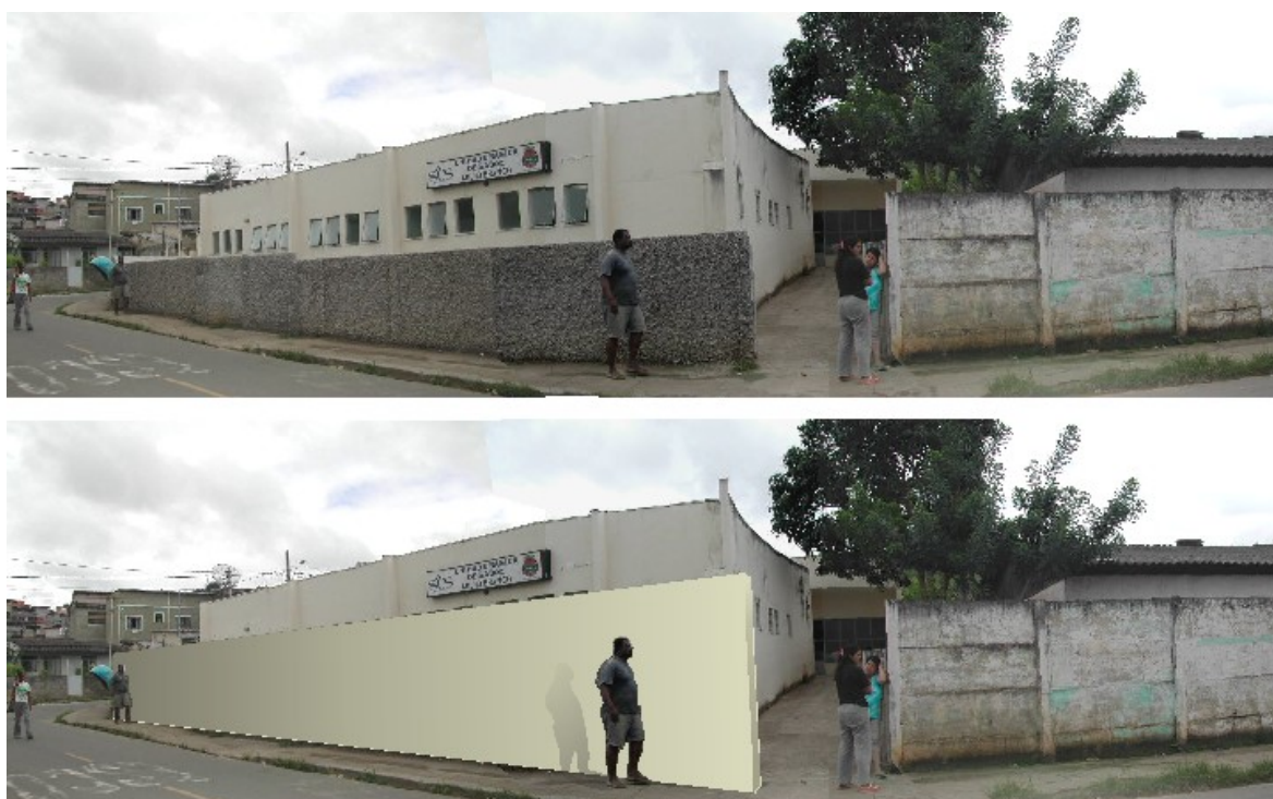
Figura 4.72: Proposta de inserção de barreira acústica para a UBS Milho Branco.
