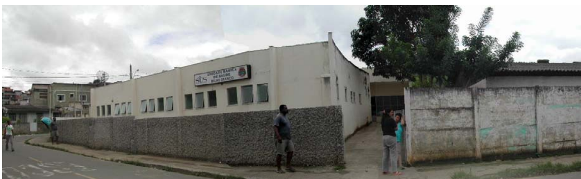
Figura 4.41 – Vista da fachada frontal da UBS Milho Branco.
