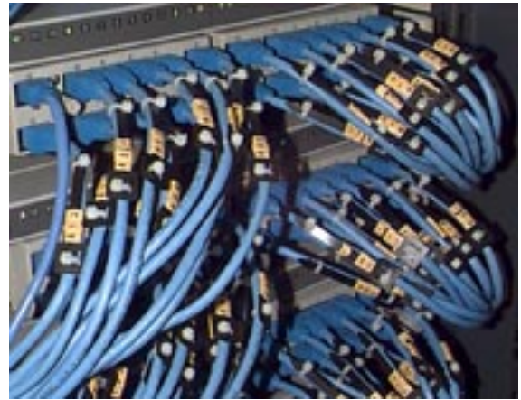
Ilustração 34 – Cabeamento ligado a um rack de distribuição e conexão
