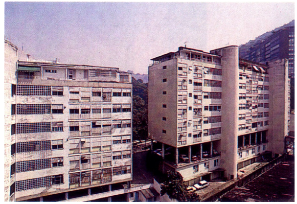
Fig. 274– Alterações na cobertura dos edifícios
