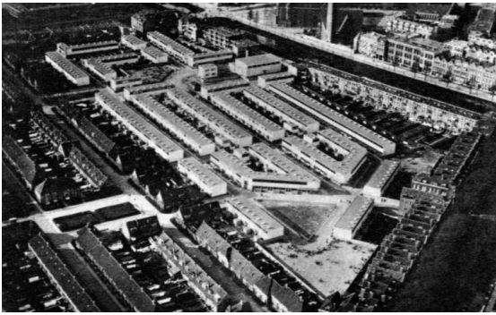
Fig. 16 – Vista aérea do conjunto Kiefhoek
