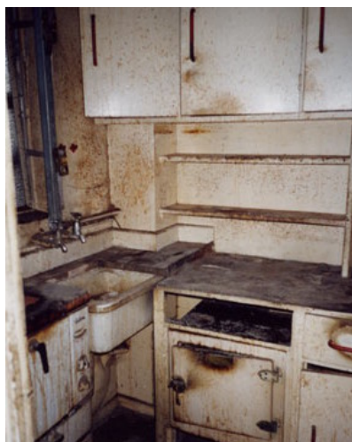
Fig. 172 – Cozinha de uma das unidades antes da restauração
