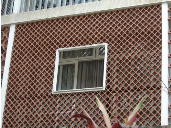
Fig.244 – Elementos cerâmicos da fachada oeste do edifício Caledônia
