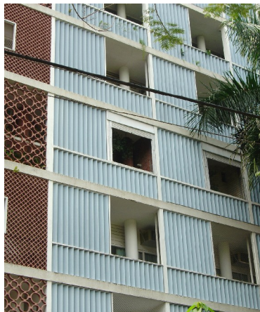
Fig. 287– Revestimento e incorporação dos pilares às paredes laterais
