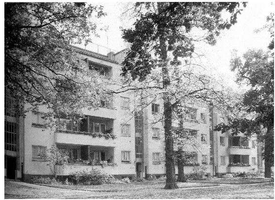
Fig. 51 – Vista de um dos blocos do bairro Siemens
