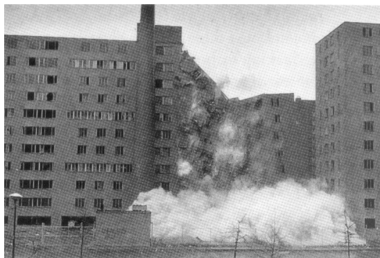
Fig. 83 – Implosão do conjunto Pruitt-Igoe
