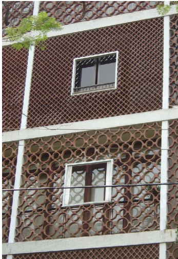
Fig.289 – Modificações nas esquadrias do edifício Bristol
