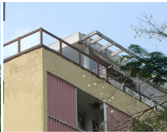
Fig. 279 – Substituição do guarda corpo original da cobertura do edifício Caledônia
