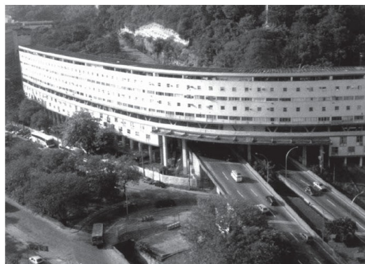
Fig. 197 – Conjunto Residencial Marquês de São Vicente após a construção do túnel
