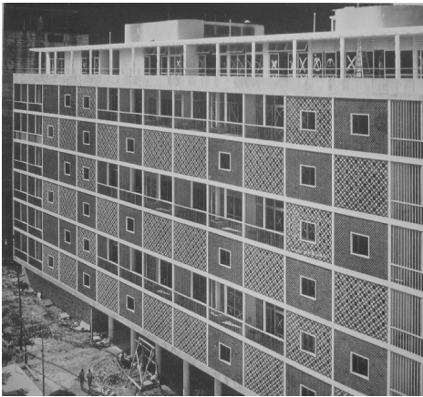
Fig. 227 – Vista do edifício Bristol com destaque para os volumes na cobertura
