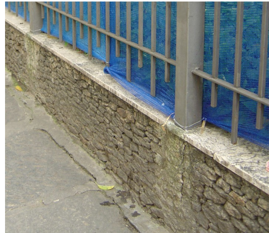
Fig. 268 – Intervenções na mureta original para colocação da grade
