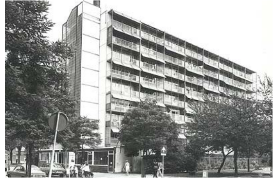
Fig. 22 – Fachada oeste do edifício Bergpolder
