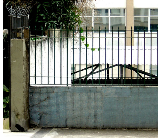
Fig. 284– Degradação do revestimento em pastilha do muro
