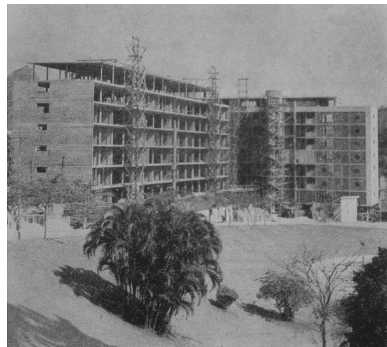
Fig.221 – Vista dos edifícios em construção
