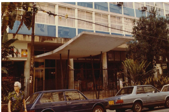
Fig. 218– Marquise de acesso ao edifício Nova Cintra (rua Gago Coutinho)
