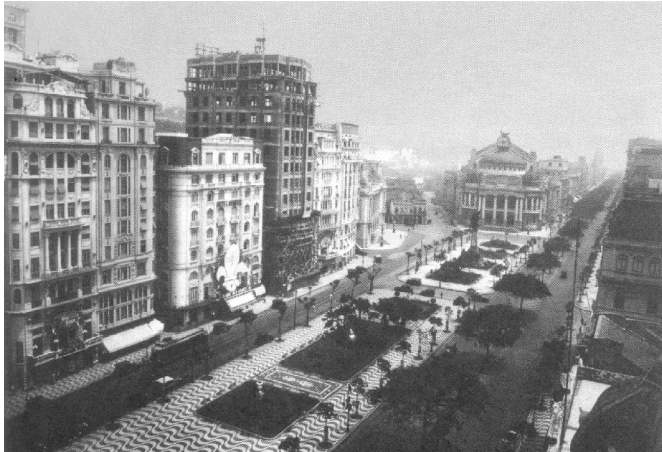
Fig.90 – Vista de trecho da Cinelândia em 1927, com alguns dos edifícios ainda em construção. Da esquerda para a direita: Cinema Império, Edifício Heindereich, Cinema Glória, Cine Pathé-Palacio, Cine Capitólio e edifício Fontes
