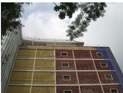
Fig. 242 – Fachada norte do edifício Nova Cintra – painéis de cobogó e brises de fibrocimento
