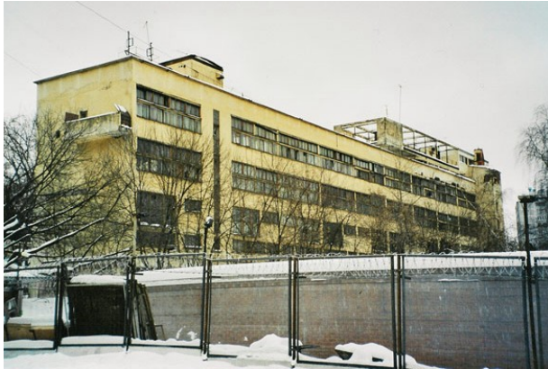
Fig. 187 – Fachada do edifício Narkomfin
