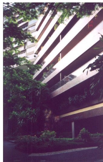
Fig. 259 - Edifício residencial construído ao lado do edifício Caledônia
