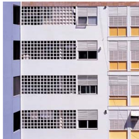
Fig. 246 – Fachada leste do edifício Bristol
