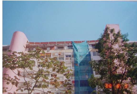
Fig. 277 – Fachada leste durante a obra de restauração
