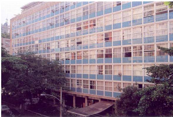
Fig. 215 – Vista da fachada sul do edifício Nova Cintra
