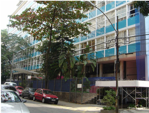
Fig. 267 – Vista geral da grade instalada no edifício Nova Cintra
