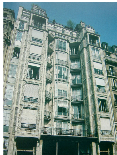
Fig. 26 - Fachada do edifício à Rue Franklin
