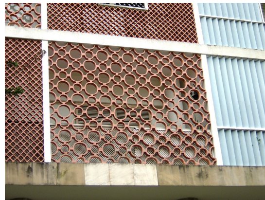
Fig. 286– Substituição do revestimento original no edifício Bristol
