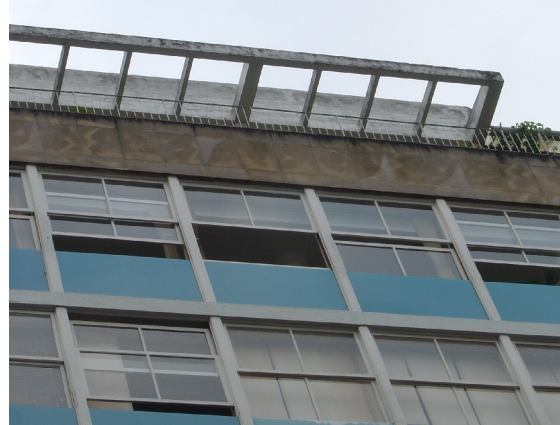
Fig. 240 – Vista da fachada sul do edifício Nova Cintra
