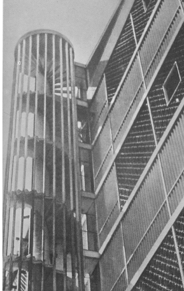
Fig. 249– Vista da estrutura da escada em construção
