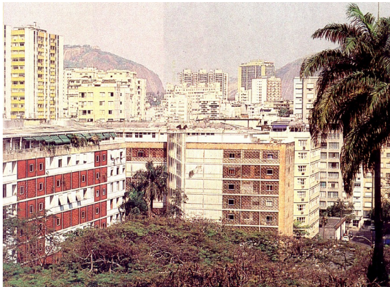
Fig. 273– Alterações na cobertura dos edifícios
