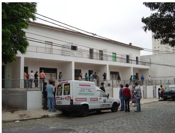
Fig. 198– Fachada principal da Vila Dona Bertadurante a execução da obra
