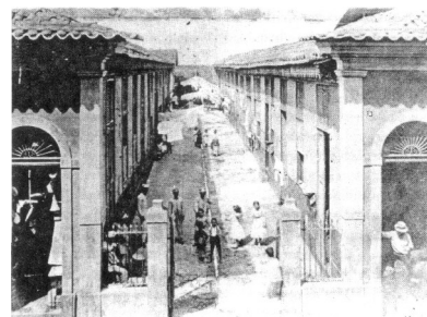
Fig.87 - Avenida na Rua Camerino
