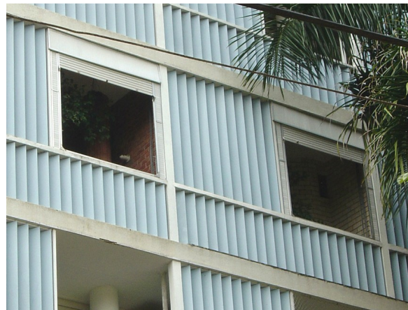
Fig. 288 – Detalhe do revestimento e incorporação dos pilares às paredes laterais
