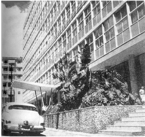
Fig. 263 – Fachada sul do edifício Nova Cintra na década de 1950
