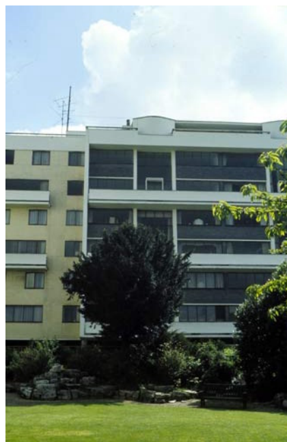
Fig. 66 – Vista do edifício Highpoint II
