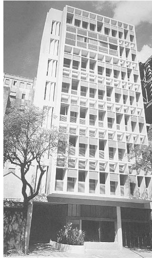
Fig. 119 – Fachada principal do edifício MMM Roberto
