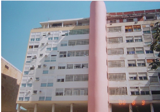
Fig. 276 – Trecho da fachada leste restaurado (à esquerda) e não restaurado (à direita)
