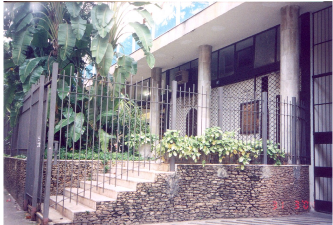
Fig. 264 - Grade instalada na fachada sul do edifício Nova Cintra
