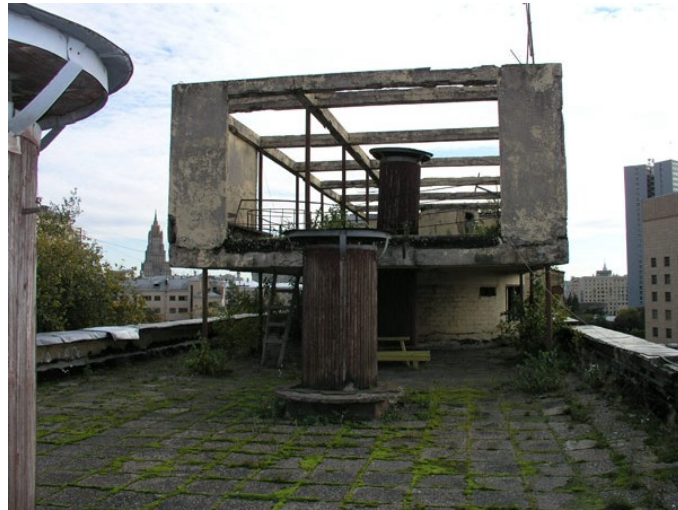
Fig. 186 – Vista do terraço do edifício Narcomfin
