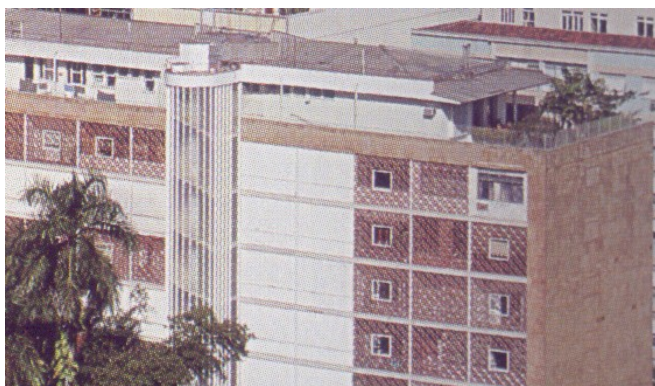
Fig. 281 – modificações no 7º pavimento do edifício Nova Cintra
