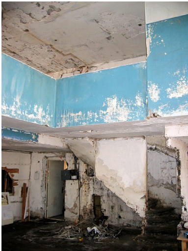
Fig. 185 – Vista interna do edifício Narkomfin
