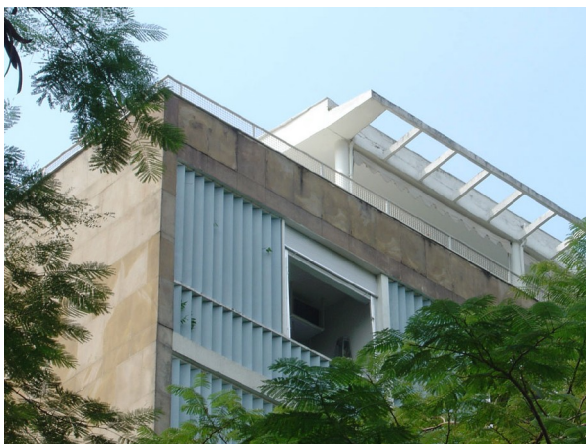
Fig. 278– Detalhe original do guarda corpo da cobertura do edifício Bristol
