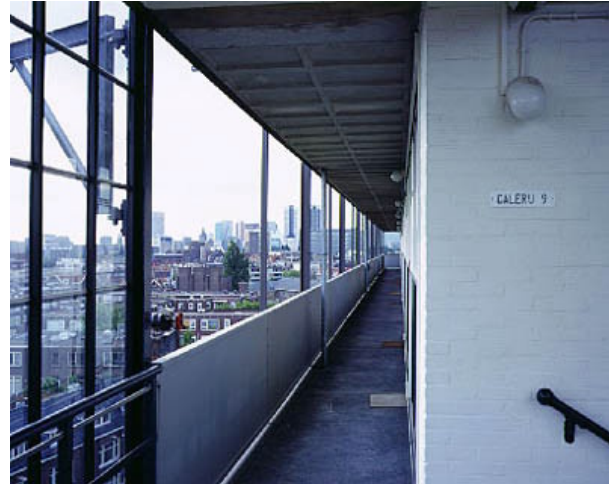
Fig.157 – Vista da galeria externa do edifício após a restauração
