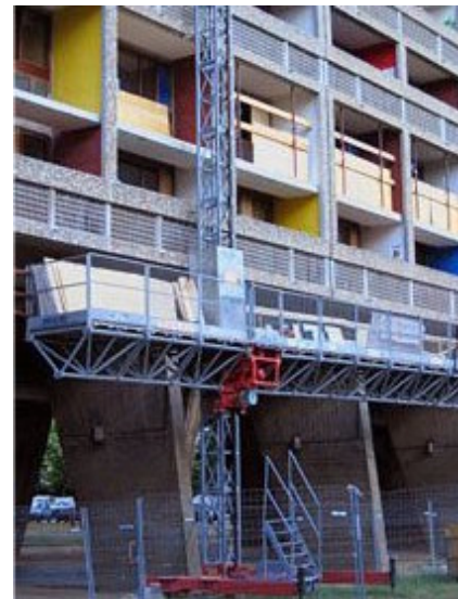
Fig. 158 – Restauração da fachada da Unidade de Habitação de Marselha
