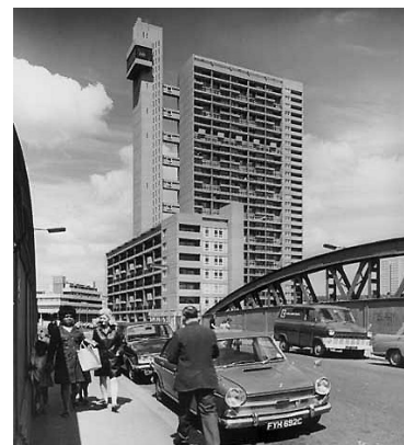
Fig. 71- Vista da Trellick Tower
