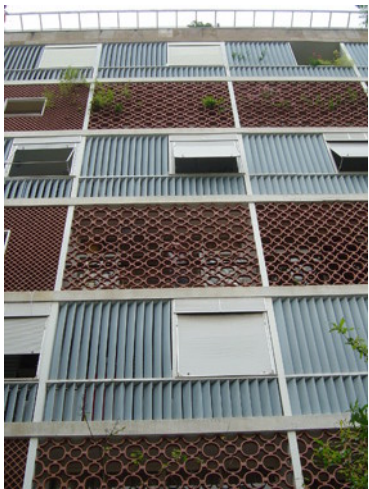
Fig. 298 – Persianas instaladas na fachada do edifício Bristol
