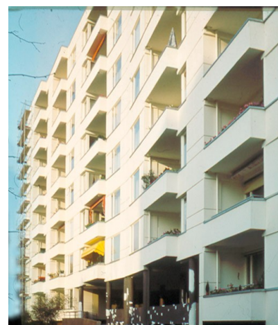
Fig. 81- Varandas do edifício Hansaviertel
