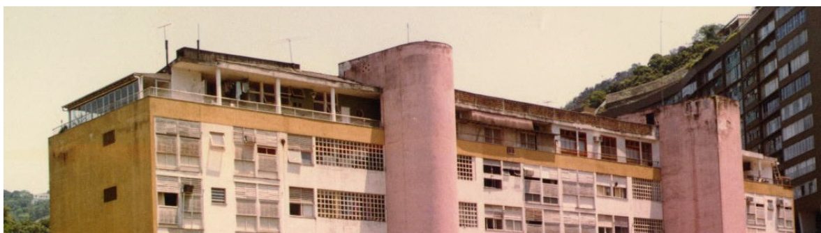
Fig. 272 - Alterações na cobertura do edifício Caledônia
