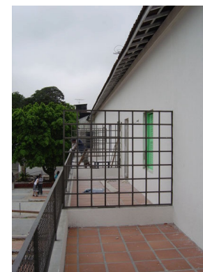
Fig. 202 – Vista das varandas restauradas
