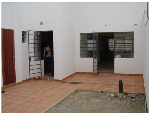
Fig. 200 – Pátio dos fundos após restauração
