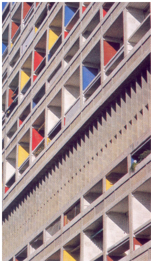
Fig. 159 – Vista da fachada da Unidade de Habitação restaurada
