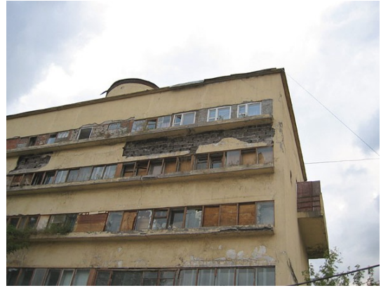
Fig. 188 – Detalhe das esquadrias modificadas
