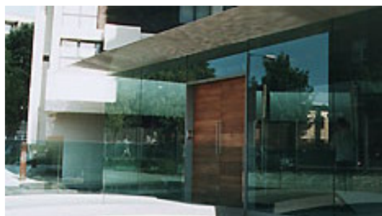
Fig. 164 – Acesso do edifício renovado
