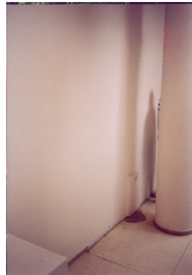
Fig.292 – Soleira remanescente do vão de umas das lojas do edifício Nova Cintra fechado com alvenaria
