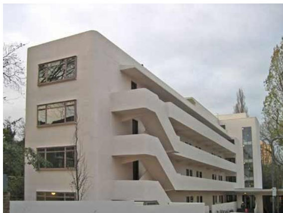
Fig. 171 – Fachada do edifício Lawn Roads após restauração
