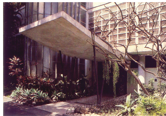
Fig. 219– Marquise de acesso ao edifício Nova Cintra (Parque)
