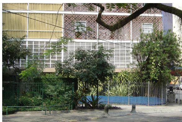
Fig. 243 – Fachada norte do edifício Nova Cintra – treliças e venezianas de madeira
