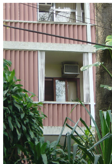
Fig. 297 – Modificações nas esquadrias do edifício Caledônia
