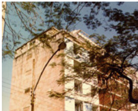
Fig. 275 – Vista de um dos acréscimos construídos na cobertura posteriormente demolido
