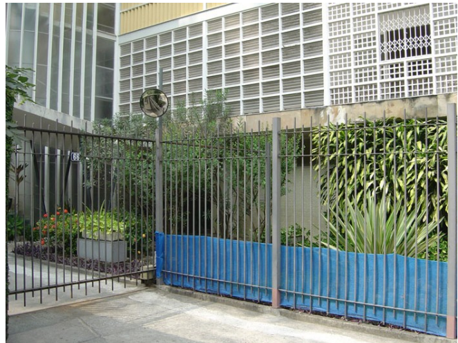
Fig. 266 - Grade instalada ao redor do edifício Nova Cintra
