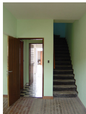
Fig. 201– Interior de uma das casas restauradas
