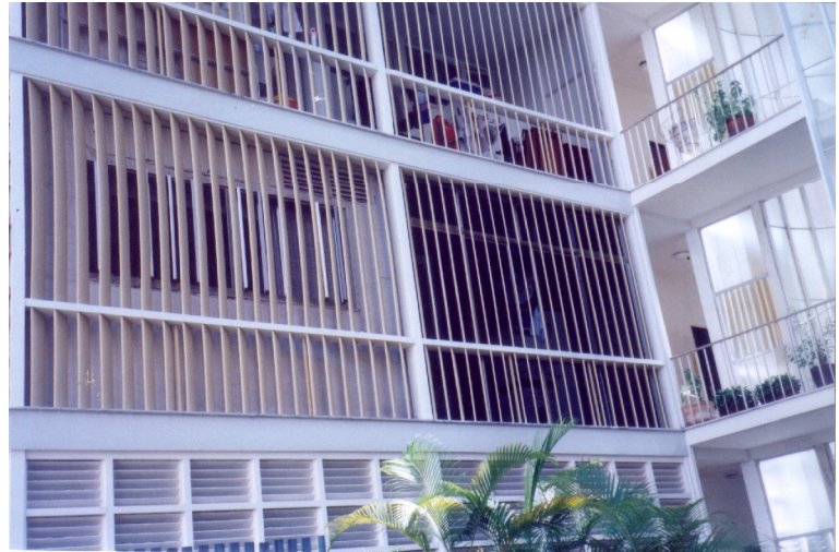
Fig. 290 – Modificações nas esquadrias do edifício Nova Cintra
