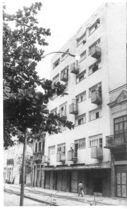
Fig. 101 - Edifício Morro de Santo Antonio
