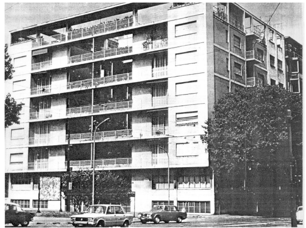
Fig. 192 – Vista da Casa Rustici
