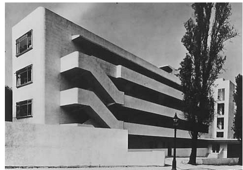
Fig. 61 – Vista do edifício Lawn Road
