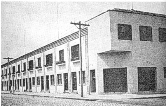
Fig.98 – Conjunto de casas na Móoca
