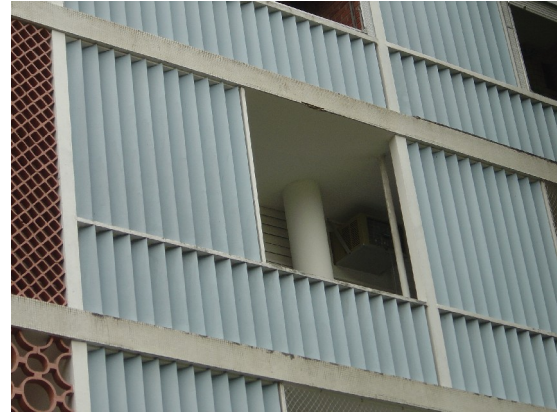
Fig.245 – Brises verticais da fachada oeste do edifício Bristol
