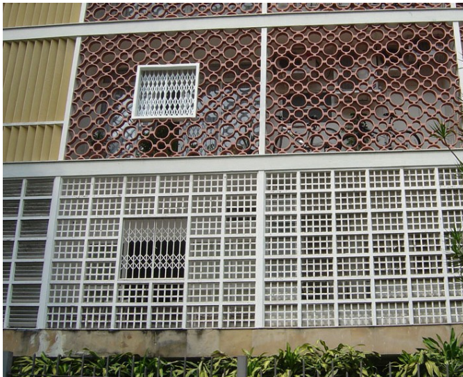
Fig. 291 – Fechamento dos vãos com grade pantográfica
