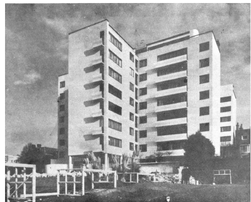
Fig. 64 – Vista do edifício Highpoint I
