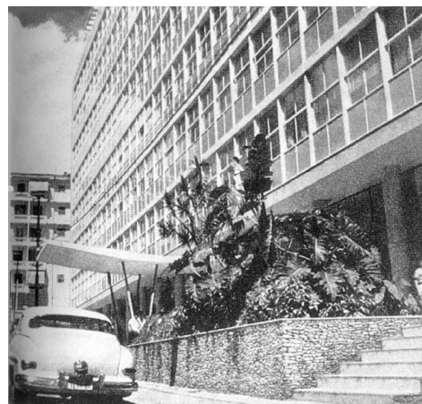
Fig. 212– Fachada sul do edifício Nova Cintra na década de 1950
