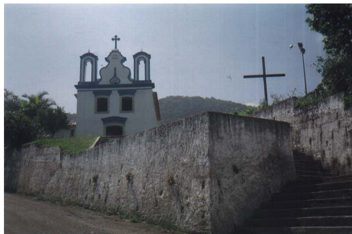
Figura 24 Escadaria de acesso
