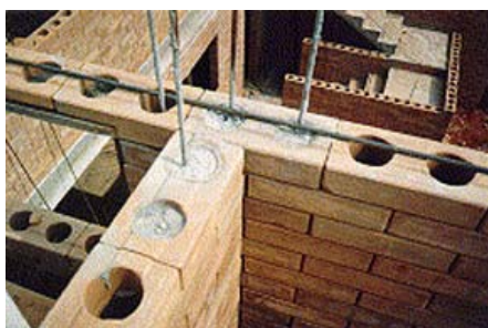
Figura 390 -Fase da construção com solo cimento. Fonte: https://webp.caixa.gov.br/liminacão/popup/pop_fotos.asp?item=sc&limin=16 . Acesso em: 05 out.2005.
