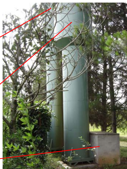
Figura 336 - Detalhe dos castelos e da bomba. Fonte: RAINHO, 2005.
