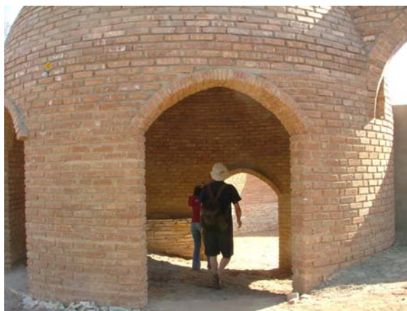
Figura 45- Anfiteatro em construção (tijolos de adobe). Fonte: ZUNINO, 2005.
