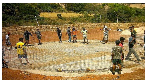
Figura 176 - Colocação da estrutura em ferro. Fonte: http://www.ecocentro.org/galeria/ferrocimento/index.htm . Acesso em: 15 jan.2005.
