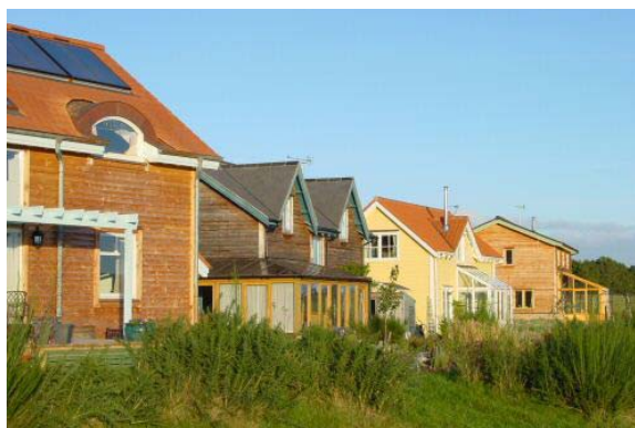
Figura 10 - Residências ecológicas construídas com madeira. Fonte: FINDHORN, 2005.
