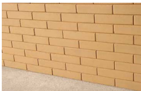
Figura 391 -Superfície lisa e plana: sem reboco e emboço. Fonte: http://www.man.com.br/liminacão_de_casa_economica/liminacão_reboco.htm . Acesso em 02 out.2005.
