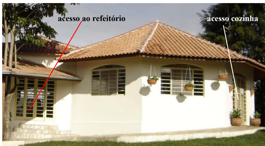
Figura 258 - Cozinha dos moradores. Fonte: RAINHO, 2005.
