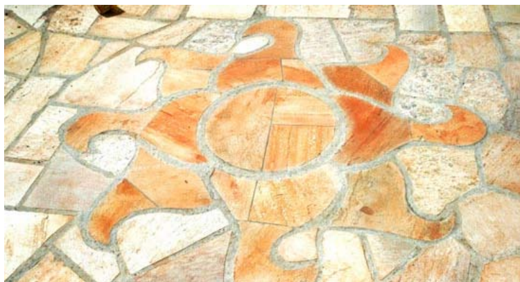
Figura 60- Piso em pedras. Fonte: IPEC, 2005.
