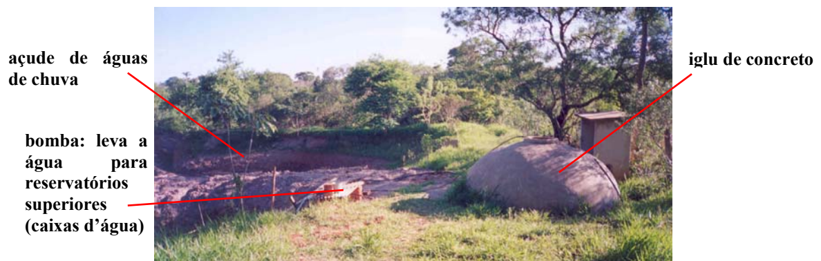
Figura 318 - Detalhe do iglu de concreto e a bomba. Fonte: RAINHO, 2005.
