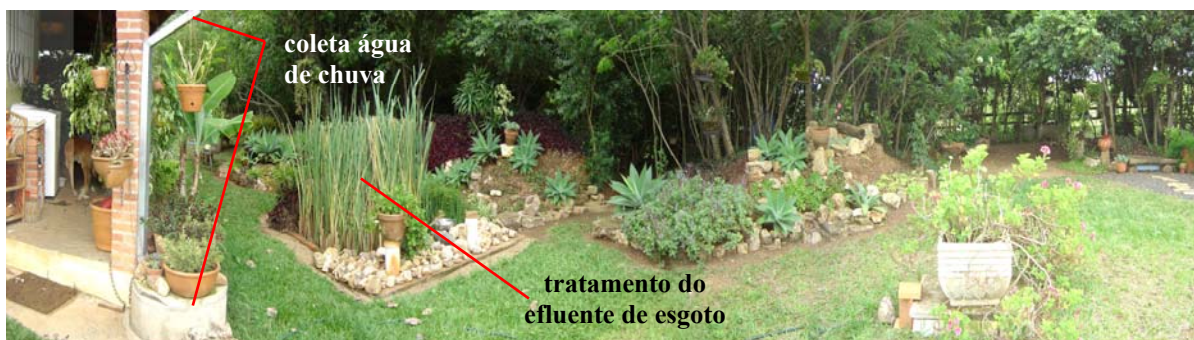
Figura 332 - Tratamento da água de chuva e tratamento do efluente de esgoto. Fonte: RAINHO, 2005.
