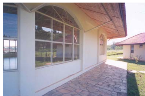
Figura 244 - Detalhe do beiral. Fonte: RAINHO, 2004.
