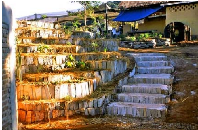
Figura 58- Jardim e escada em pedras. Fonte: IPEC, 2005.
