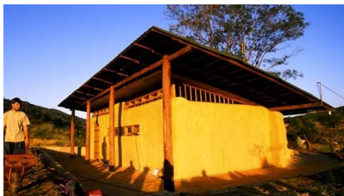
Figura 55- Construção em fardo de palha. Fonte: IPEC, 2005.
