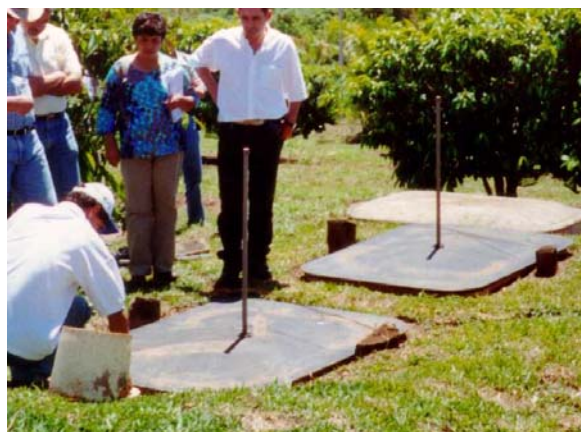
Figura 160 - Sistema da fossa biodigestora tampado.
