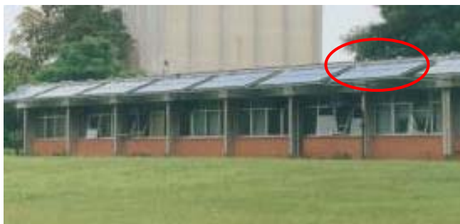
Figura 137 - Painéis na cobertura do IEE/ USP 63 , São Paulo, Brasil. Fonte: ZILLES, 2006, p.3.
