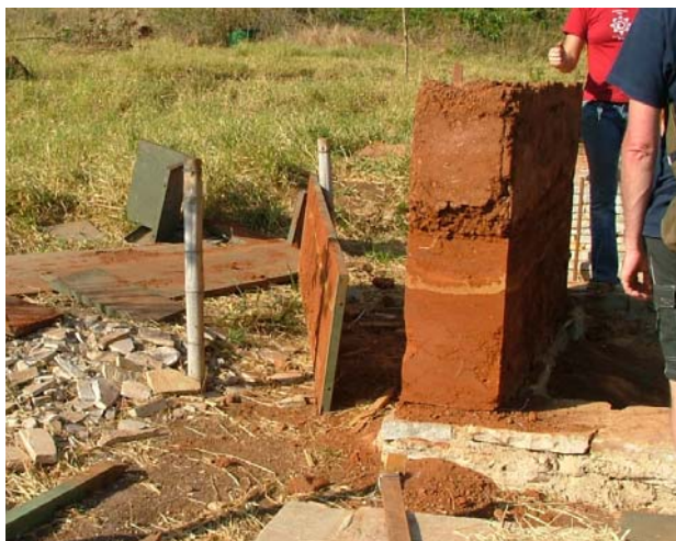
Figura 51 - Módulos de construção em taipa de pilão. Fonte: ZUNINO, 2005.
