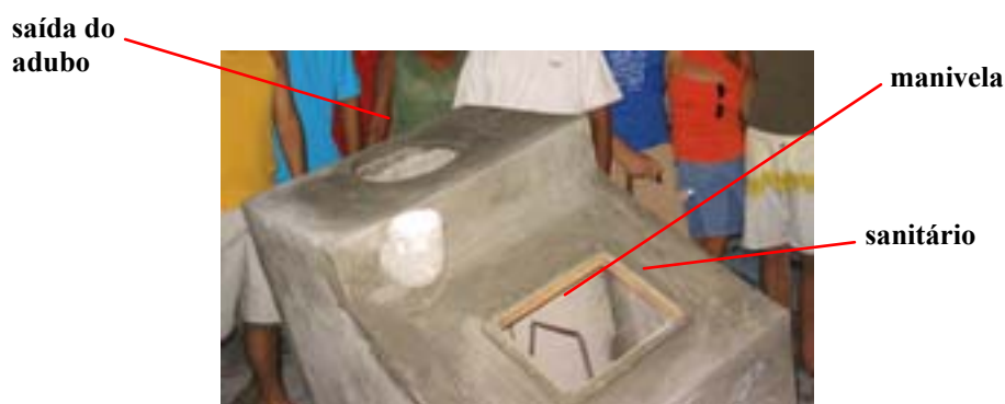
Figura 169 - Sanitário seco compostável fabricado por Lengen. Fonte: TIBÁ, 2004.
