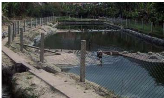
Figura 163 - Tanque de sedimentação. Fonte: OIA, 2004.
