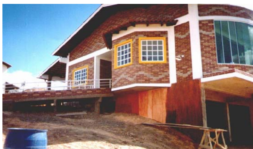
Figura 108 -Habitação em solo cimento no Brasil. Fonte: http://www.vimaqpressas.com.br/fotos_construcoes/foto2.htm . Acesso em: 22 set.2005.
