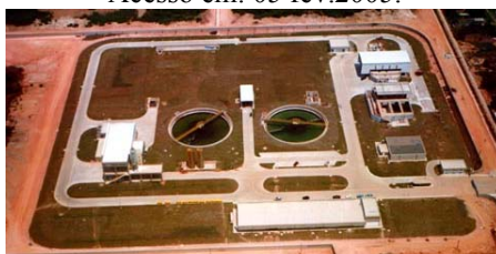
Figura 155 - Estaco de Tratamento de Esgoto Sarapuí - Nova Iguaçu, Rio de Janeiro, Brasil Fonte: < http://www.cibg.rj.gov.br/galeria_design.asp?img=27 >. Acesso em: 05 fev.2005.
