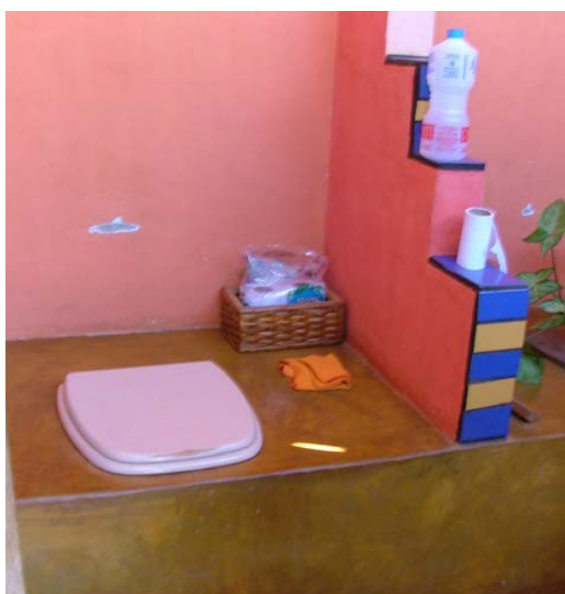
Figura 66- Interior do sanitário seco. Fonte: ZUNINO, 2005.
