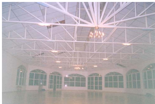
Figura 245 - Interior do “salão grande”. Fonte: RAINHO, 2004.
