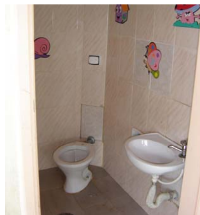
Figura 241 - Banheiro da creche. Fonte: RAINHO, 2005.
