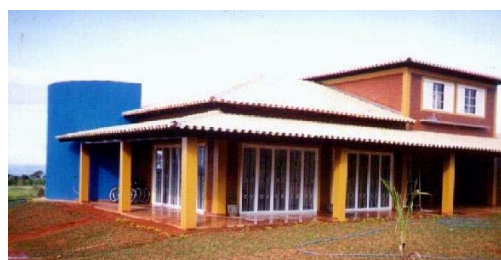
Figura 107 -Habitação em solo cimento no Brasil. Fonte: http://www.vimaqpressas.com.br/fotos_construcoes/foto5.htm . Acesso em: 22 set.2005.
