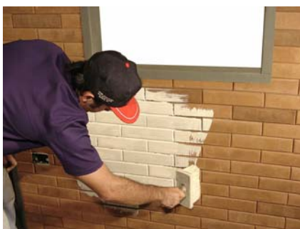
Figura 396 -Pintura das paredes de tijolo de solo-cimento. Fonte: http://www.man.com.br/construcao_de_casa_economica/Pintura_direto.htm . Acesso em 02 out.2005.
