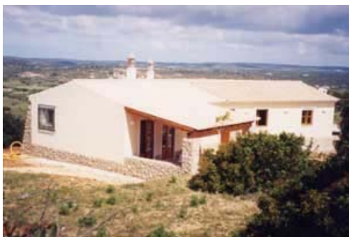
Figura 89 -Residência no Algarve, Portugal. Fonte: http://www.construdobe.com/pt . Acesso em 20 jan.2006.
