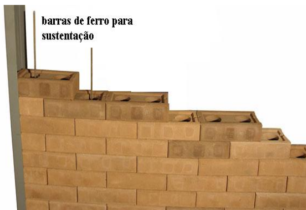
Figura 9611 -Assentamento dos tijolos de solo-cimento. Fonte: http://www.man.com.br/liminacão_de_casa_economica/liminacão_argamassa.htm . Acesso em 02 out.2005.
