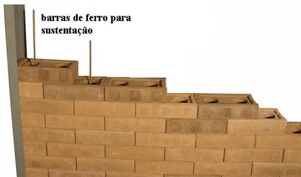
Figura 389 -Assentamento dos tijolos de solo-cimento. Fonte: http://www.man.com.br/liminacão_de_casa_economica/liminacão_argamassa.htm . Acesso em 02 out.2005.
