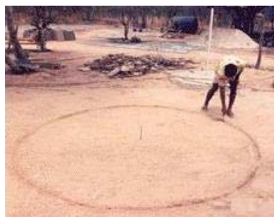
Figura 175 - Locação e marcação do diâmetro da cisterna para futura fabricação. Fonte: < http://www.febraban.org.br/arquivo/destaques/destaque-fomezero.asp >. Acesso em: 15 jan.2005.
