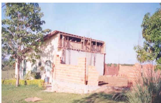
Figura 22 - Cozinha nova em construção: tijolo de barro e estrutura em concreto (2004). Fonte: RAINHO, 2005.
