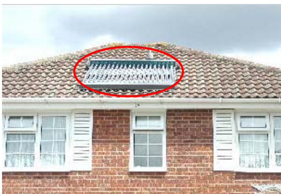
Figura 123 - Residência no Reino Unido. Fonte: http://www.solheat.co.uk . Acesso em 27 jan.2006.
