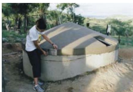
Figura 180 - Cisterna de água de chuva no sertão nordestino. Fonte: http://www.amigosdobem.org/img/projeto/3-8.jpg . Acesso em: 15 jan.2005.
