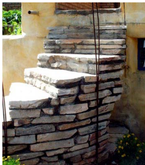
Figura 59- Escada em pedras. Fonte: IPEC, 2005.
