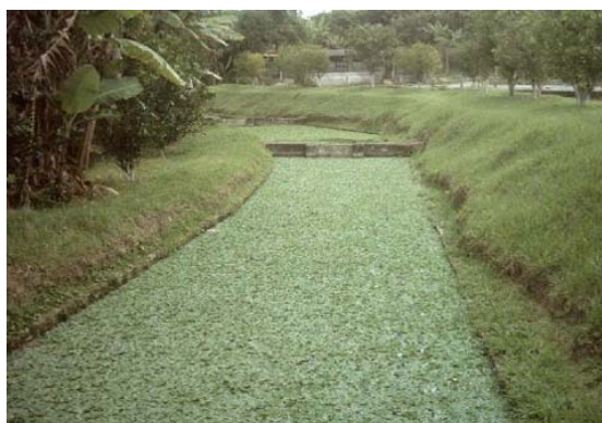
Figura 165 - Tanque de macrófitas. Fonte: OIA, 2004.
