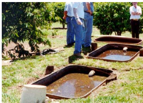
Figura 159 - Sistema da fossa biodigestora (sem as tampas).
