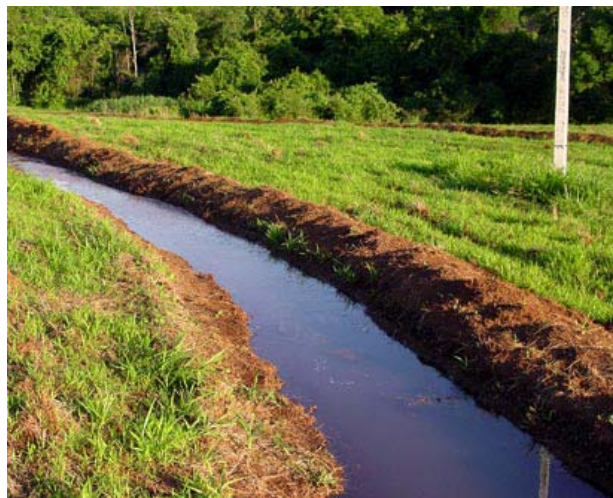
Figura 71- Canal de infiltração com água de chuva. Fonte: IPEC, 2005.
