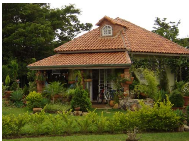
Figura 330 - Residência Lila. Fonte: RAINHO, 2005.
