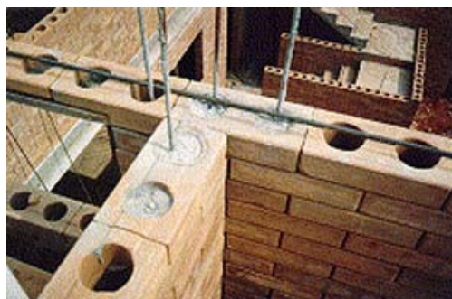
Figura 97 -Fase da construção com solo cimento. Fonte: https://webp.caixa.gov.br/liminacão/popup/pop_fotos.asp?item=sc&limin=16 . Acesso em: 05 out.2005.
