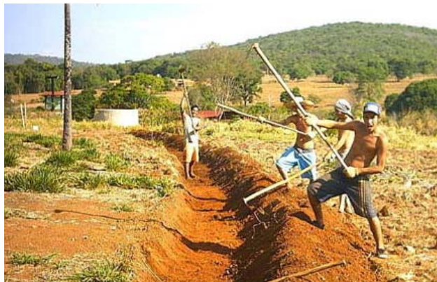
Figura 70- Abertura de um canal de infiltração. Fonte: IPEC, 2005.
