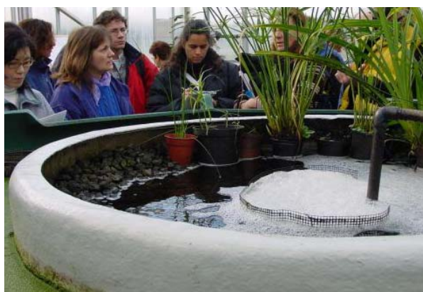
Figura 14 - Tanque aeróbico aberto da Máquina Viva. Fonte: FINDHORN, 2005.
