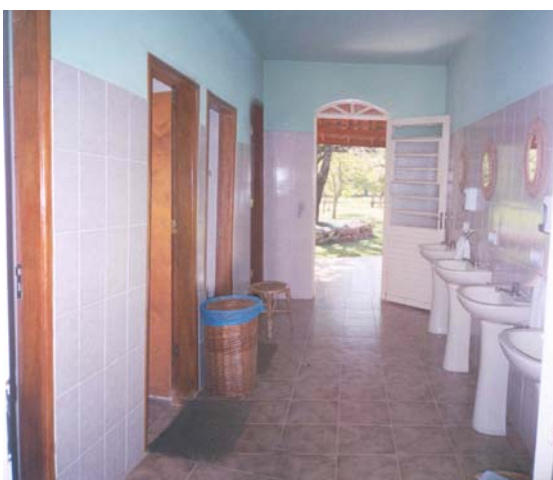
Figura 214 - Banheiro coletivo (Borboleta). Fonte: RAINHO, 2005.
