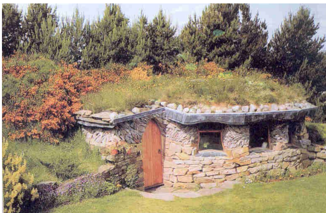
Figura 17 - Santuário da Natureza construído com pedras locais, além do telhado verde integrado à paisagem. Fonte: BRAUN, 2001.
