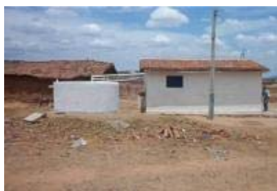
Figura 18112 - Cisterna de água de chuva de uma habitação no nordeste. Fonte: http://www.smi.org.br/cultura/sertao_arquivos/image013.jpg . Acesso em: 15 jan.2005
