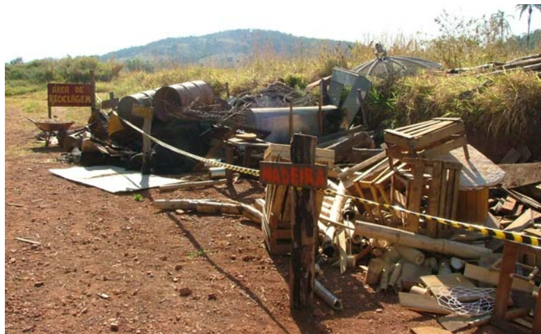
Figura 79- Área para armazenagem de materiais recicláveis. Fonte: ZUNINO, 2005.
