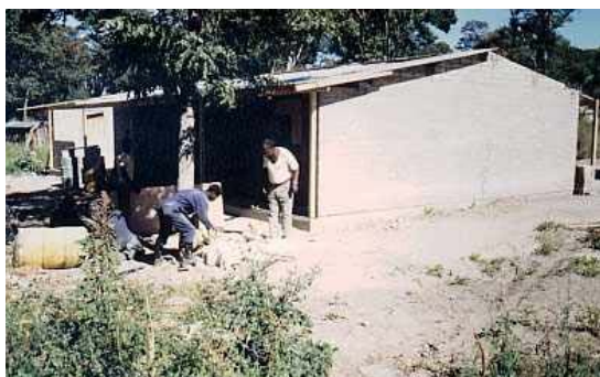
Figura 110 - Habitação em solo cimento, Zâmbia. Fonte: http://www.abako.se/index.php?page_id=0&img_id=475&current_page_id=140&view=single . Acesso em: 10 ago.2005.
