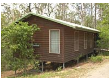
Figura 34 - Acomodação para visitantes em madeira. Fonte: CRISTAL WATERS, 2005.
