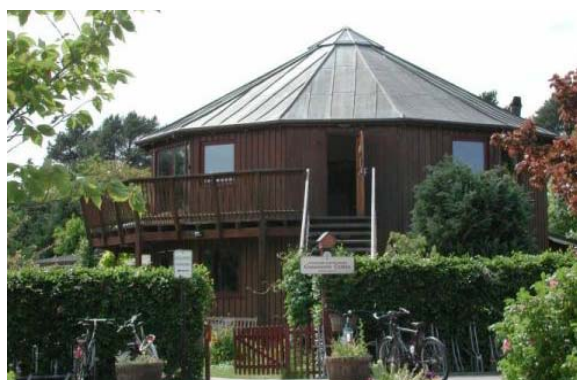
Figura 12 - Centro Comunitário em madeira. Fonte: FINDHORN, 2005.
