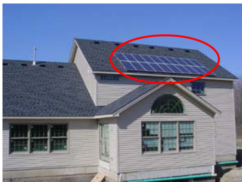
Figura 125 - Residência no Reino Unido. Fonte: http://www.toolbase.org/docs/images/EssexHomes014Big.jpg . Acesso em 27 jan.2006.
