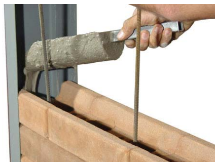
Figura 394 -Batentes de portas e janelas com chumbamento. Fonte: http://www.man.com.br/construcao_de_casa_economica/embolsamento.htm . Acesso em 02 out.2005.
