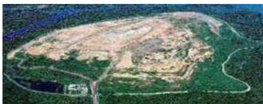
Figura 144 - Exemplo de aterro. Fonte: < http://www2.rio.rj.gov.br/comlurb/imagens/aterro.jpg >. Acesso em: 14 fev.2006.
