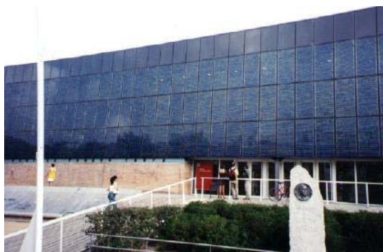
Figura 135 - Painéis fotovoltaicos na fachada da Biblioteca de Mataró, Barcelona, Espanha. Fonte: ZILLES, 2006, p.4.
