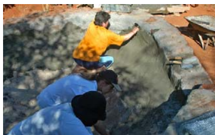
Figura 178 - Emboço das cisternas. Fonte: http://www.ecocentro.org/galeria/ferrocimento/index.htm . Acesso em: 15 jan.2005.
