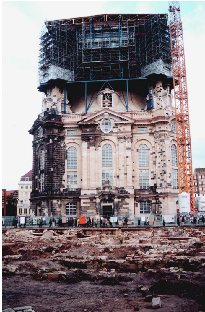
Fig. 03 - Obras de reconstrução da Frauenkirche em Dresden, 2002 .
