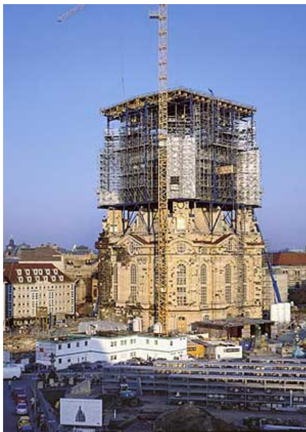
Fig. 64 - Frauenkirche. A movimentação vertical do Wetterschutzdach durante as obras de reconstrução.
