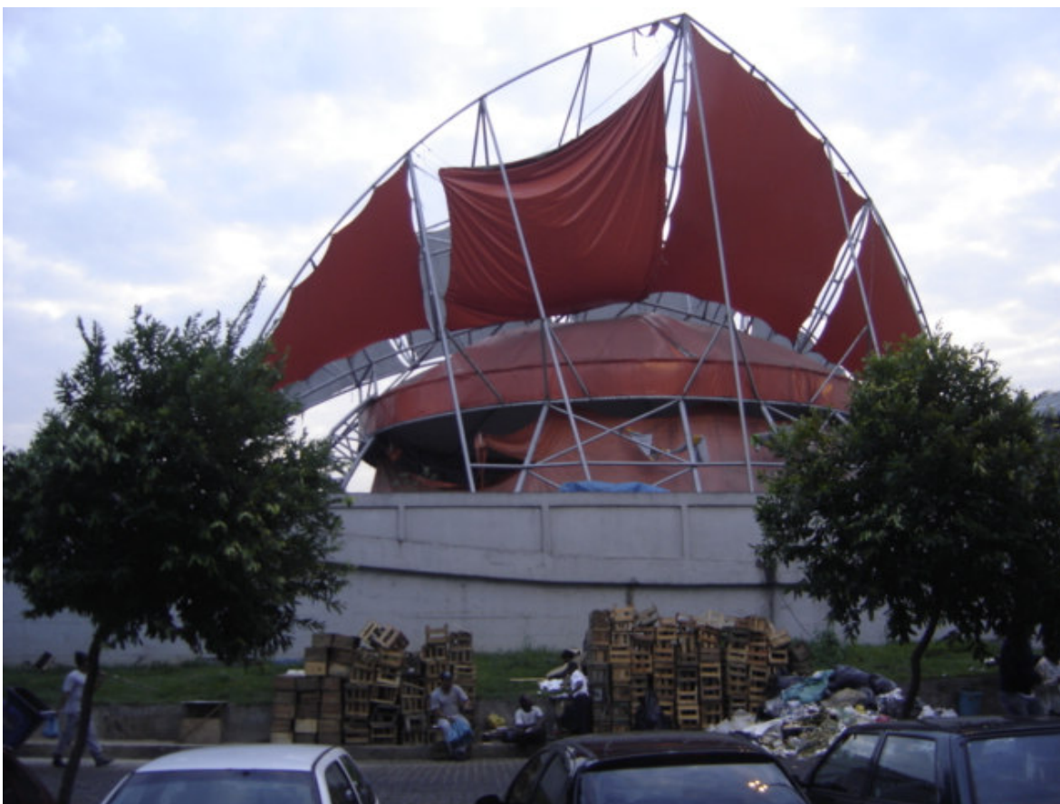
Figura 84: as lonas tensionadas, sujas e rasgadas precisando da manutenção, relembram as antigas lonas da Feira. (Foto: André Carvalho. Dia 21/05/06).
