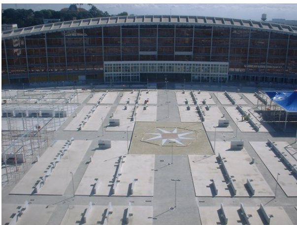
Figura 43: O Centro do CLGTN, ainda em obras – Archi 5. (fornecida pelo arq. Bruno )
