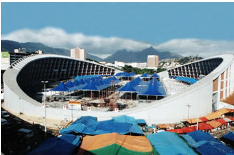
Figura 27: A Feira dos Nordestinos ainda do lado de fora e o Pavilhão em obras. ( http://www.rio.rj.gov.br/sedect/projetos_luiz_gonzaga.htm - 02/04/2004)
