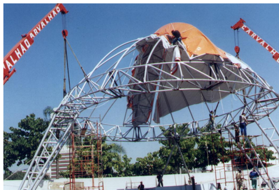
Figura 56: Um dos palcos principais tendo sua Lona tensionada instalada no dia da inauguração. (Foto: André Carvalho. Dia 20/09/03).
