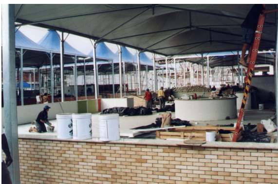
Figura 46: Restaurante Baião de Dois - operários trabalhando, na construção de restaurante, Teste do cores na parede para escolha de tintas. (Foto: André Carvalho. Dia 13/09/03).
