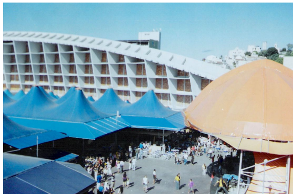
Figura 83: As antigas lonas são substituídas por marquises em lonas tensionadas, pagas pelos próprios comerciantes. (Foto: André Carvalho. Dia 08/06/04).
