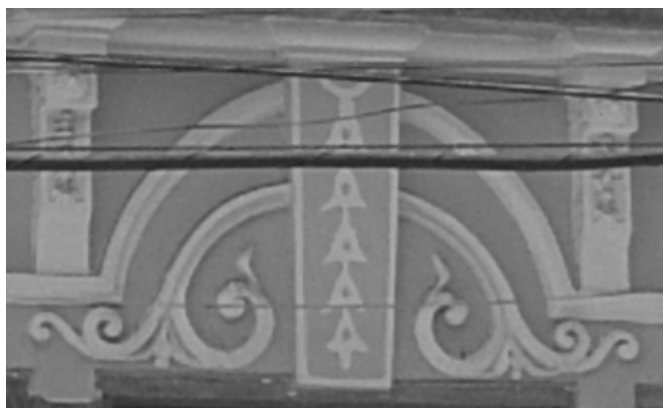
Figura 160 – Elemento recuperado da fachada – Ornato (autora, 2005).
