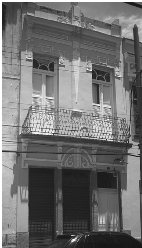
Figura 157 – Fachada da rua do Livramento 145 –depois da restauração (autora 2005).
