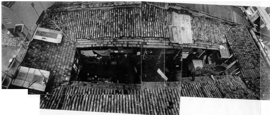
Figura 139 – Cobertura antes da restauração. Observar que único pátio existente é o central (CEBRIÁN, 1995, p. 52).
