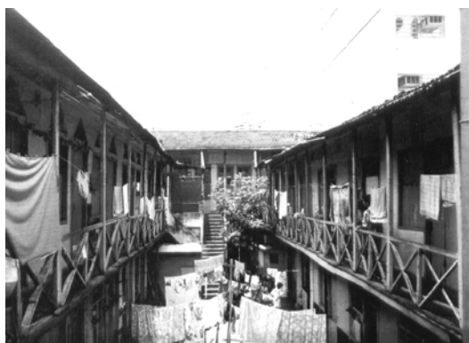
Figura 130 – Fachadas internas, antes da intervenção (CEBRIÁN, 1995, p. 15).
