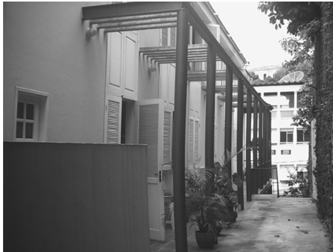
Figura 178 – Fachada lateral esquerda (autora, 2005).
