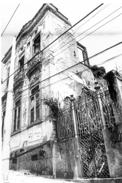
Figura 174 – Fachada lateral da edificação à rua Francisco Muratori, 38 – antes da restauração (SECRETARIA, s.d.)
