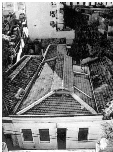
Figura 100 – Cortiço na Travessa do Mosqueira, 20 – Fachada (SECRETARIA, 2000, p. 41).
