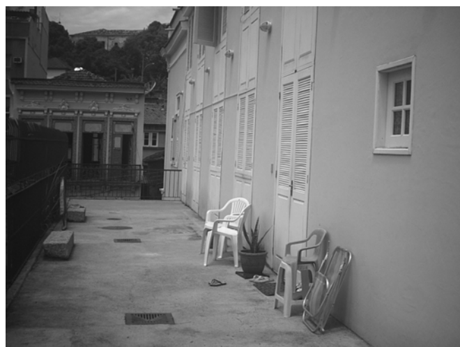
Figura 179 – Fachada lateral direita (autora, 2005).
