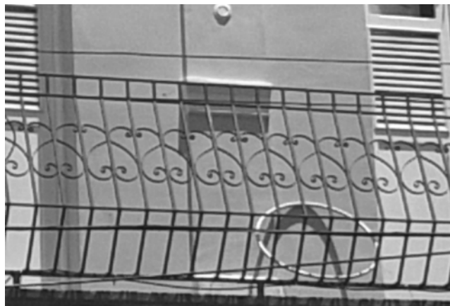
Figura 159 – Elemento recuperados da fachada – Gradil (autora, 2005).
