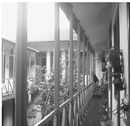
Figura 125 – Circulação do segundo pavimento – depois da intervenção (autora, 2003).
