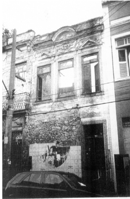
Figura 165 – Fachada da rua do Livramento 147 – antes da restauração (MONTARROYOS, 1999, p. 8).
