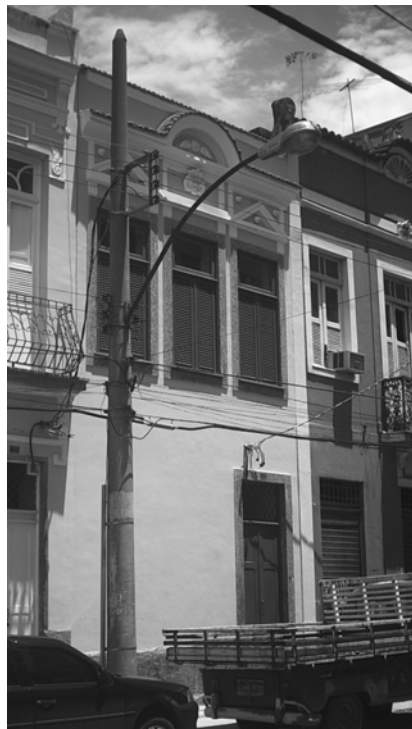
Figura 166 – Fachada da rua do Livramento 147 – depois da restauração (autora 2005).
