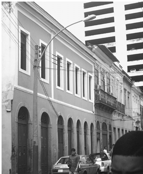
Figura 129 – Fachada Senador Pompeu, após da intervenção (autora, 2003).
