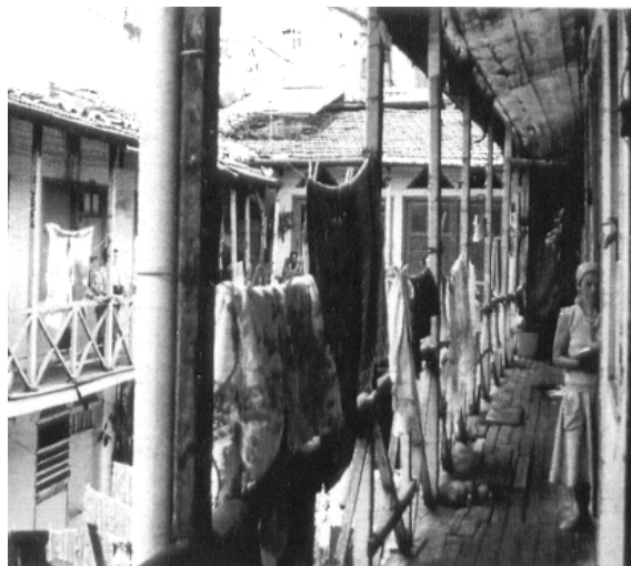
Figura 124 – Circulação do segundo pavimento – antes da intervenção (CEBRIÁN, 1995, p. 22).
