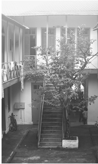
Figura 138 – Escada depois da alteração (autora, 2003).
