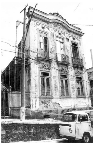
Figura 173 – Fachada principal da edificação à rua Francisco Muratori, 38 – antes da restauração (SECRETARIA, s.d.)
