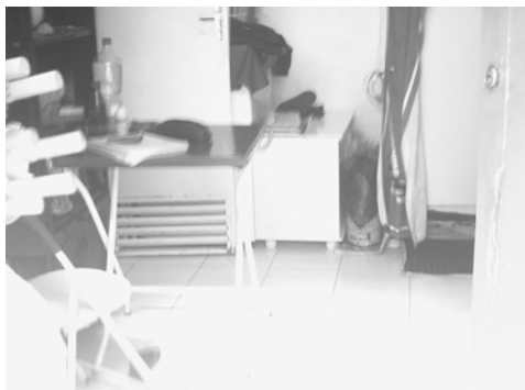
Figura 127 – Piso de um cômodo – após a intervenção, o morador aplicou um piso cerâmico, recobrando o cimentado (autora, 2003).
