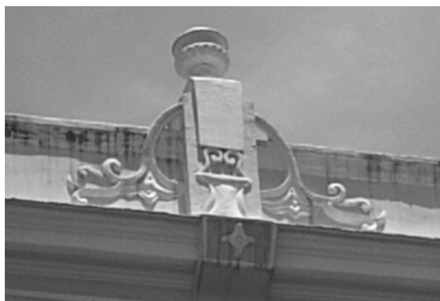
Figura 158 – Elemento recuperado da fachada – Ornato da platibanda (autora, 2005).
