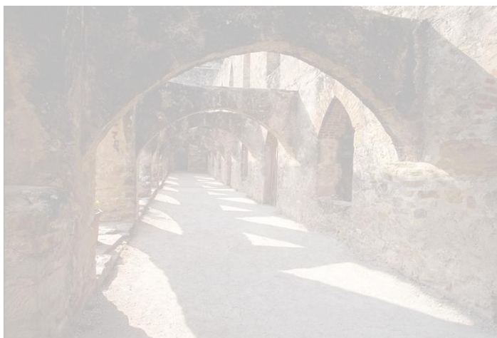
Detalhe de edificação. (*)
