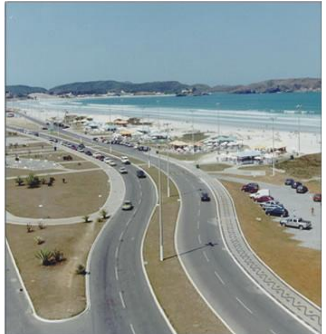
Figura 33: Avenida Cristóvão Colombo - já construída
