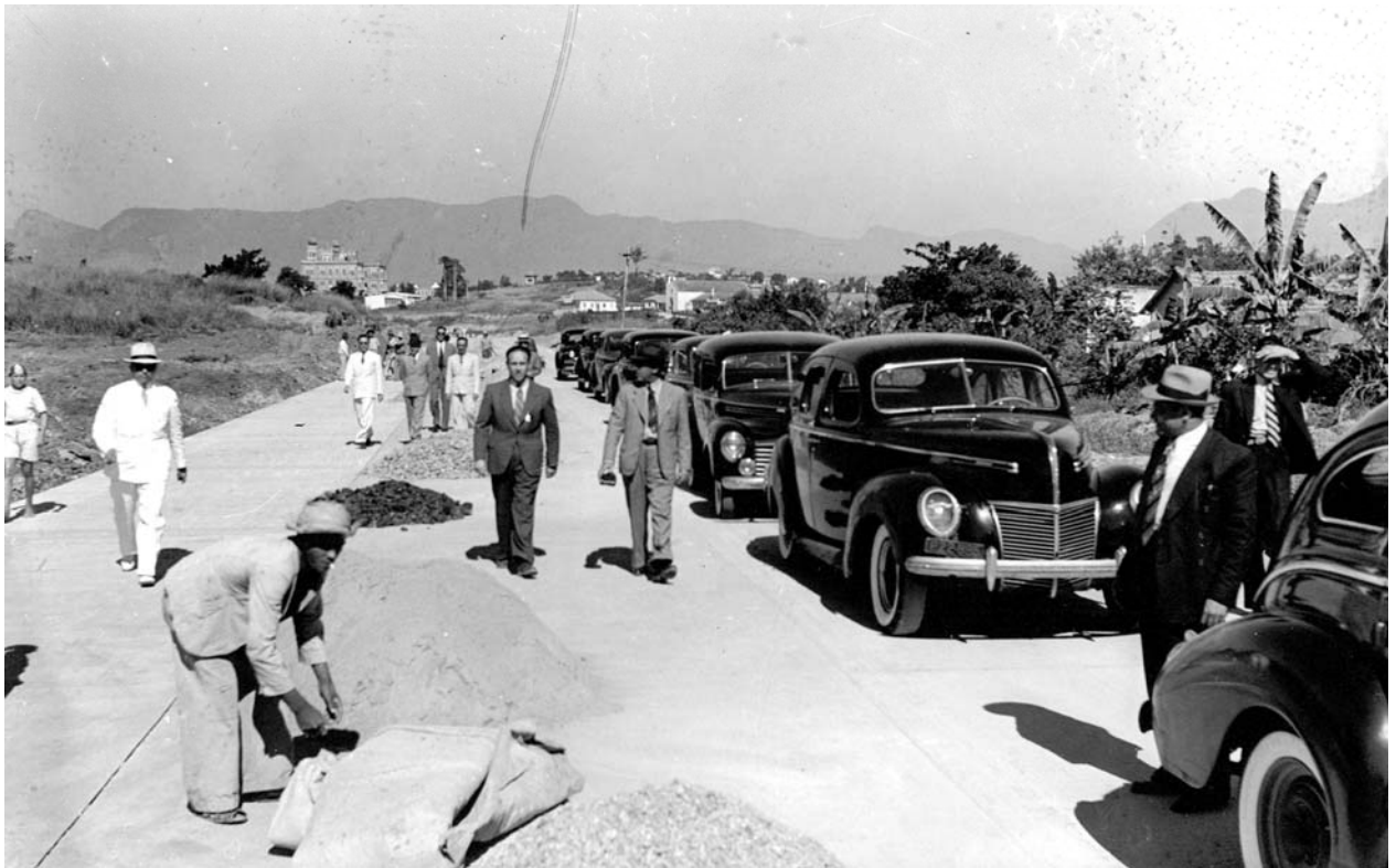
Getúlio Vargas em visita às obras da variante. 1941. Arquivo Geral da Cidade do Rio de Janeiro.
