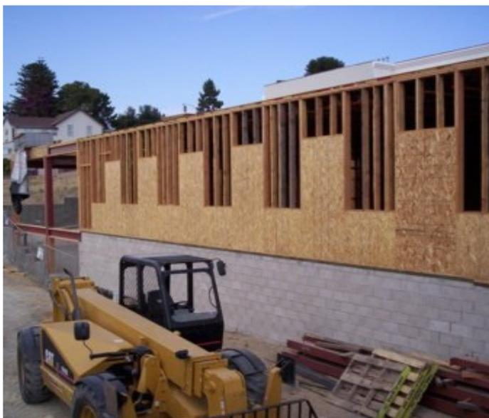
*Fig 35: Construção com dois tipos de materiais diferentes para fechamento externo e estrutura em aço. (Demetrius Vasques Cruz).*
