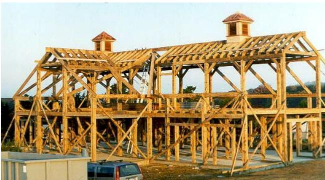
Fig. 19: Construção em montantes de madeira típica. (Fonte: [www.vermonttimberworks.com](http://www.vermonttimberworks.com)).
