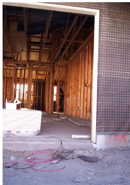
*Fig 36: Detalhe do aramado sobre a manta asfáltica. À esquerda, ao chão, painéis de gesso para fechamento interno.
