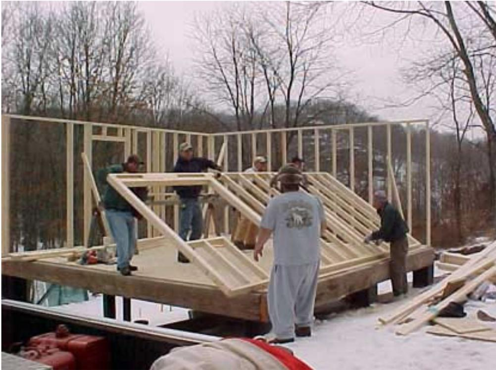
**Fig. 27: Esquema básico de construção de um wall-framing.**
