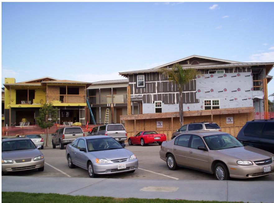
*Fig 38: Outros tipos de produtos para acabamento impermeabilizante do painel de OSB. (Demetrius Vasques Cruz).*
