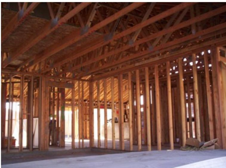
*Fig. 25: Aspecto do interior da construção sem os elementos de fechamento. Reparar junções metálicas de união dos caibros do telhado com as vigas. (Demetrius Vasques Cruz).*
