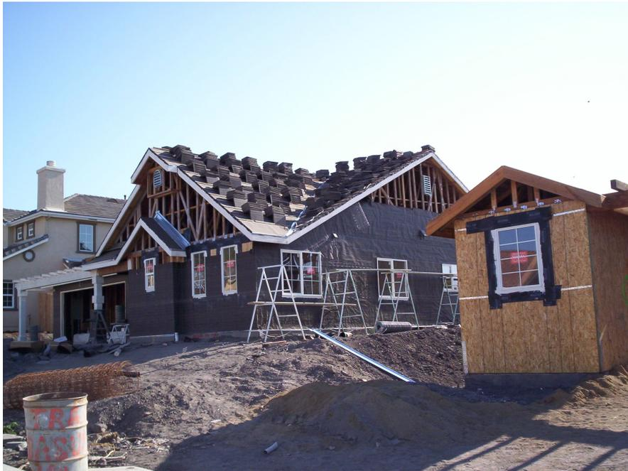
*Fig 37: Acima as três fases do acabamento, (direita para esquerda): OSB aparente; manta asfáltica com tela; e ao fundo a esquerda, aspecto final. (Demetrius Vasques Cruz).*
