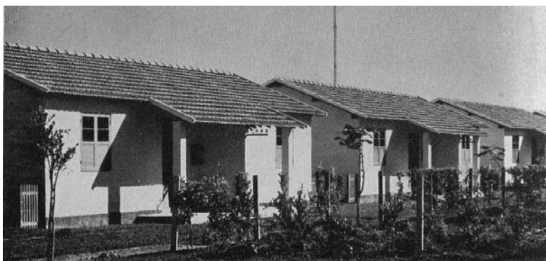
Casas do IAPI de Realengo, projetadas por Carlos Ferreira, em 1942. Os blocos de concreto desenhados pelo arquiteto, que possibilitaram a racionalização do empreendimento, foram deixados sem revestimento.
