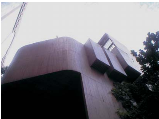
Vistas diversas da ampliação do Colégio São Bento, Mauro Guarany, 1968. O arquiteto explorou as marcas das fôrmas de madeira no concreto, elemento dominante de todo o conjunto. Projeto premiado pelo IAB-GB em 1968.
