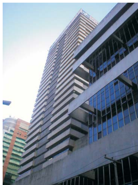
Sede dos Correios, na avenida Presidente Vargas (Antônio Antunes Soares Filho, 1974). Na torre, os pilares são recuados e as vigas são plasticamente trabalhadas. O bloco anexo apresenta forte expressionismo estrutural.
