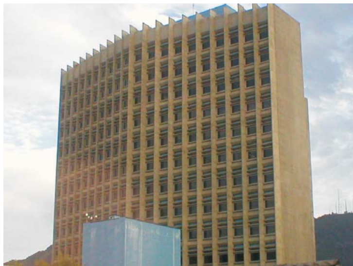
Centro de Operações do Banco do Brasil, no Andaraí (Maurício e Márcio Roberto, 1969). Composição de volumes ortogonais e concreto plasticamente trabalhado. Abaixo duas obras realizadas pelos mesmos arquitetos, para o mesmo cliente e com o programa semelhante, nas capitais paulista e gaúcha (1971 e 1973, respectivamente).
