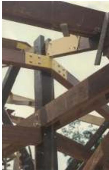
Figura 62: União com chapas parafusadas
