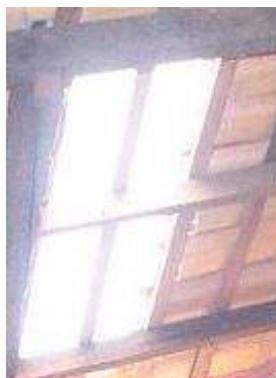
Figura 83: Telha de acrílico
