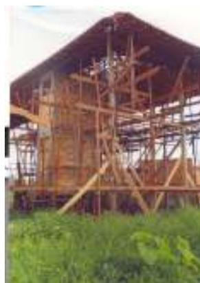
Figura 105: Estrutura com cobertura independente
