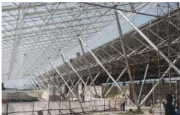
Figura 66: Armadura espacial do Aeroporto de Belém
