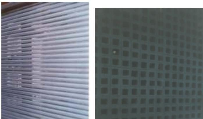
Figura 99: Materiais industrializados poderão ser dispostos nas divisões internas tais como tubos e combogós
