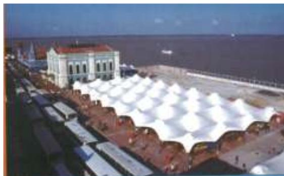
Figura 73: Membrana pré-tensionada
