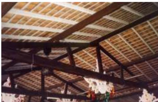
Figura 52: Cobertura em duas águas
