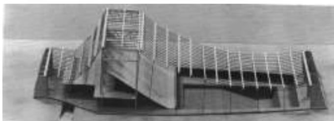
Figura 64: Sistema protendido com cabos de estabilização transversais.
