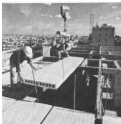
Figura 61: Laje pré-fabricada
