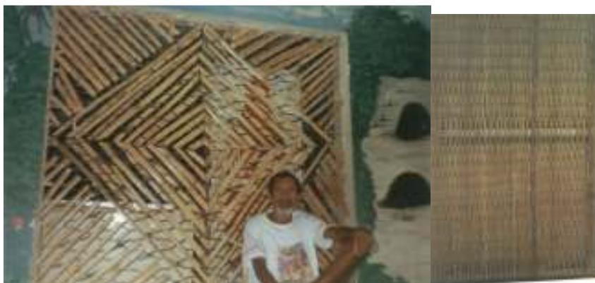
Figura 97: O painel em seções longitudinais de bambu, bem como o uso do vime
