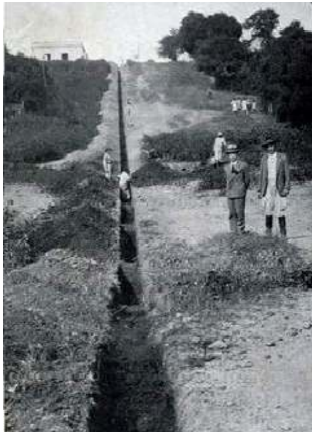
Fig.13 - Aterramento para construção de estradas e Obras de saneamento Fonte: www.portaluruguaiana.com.br
