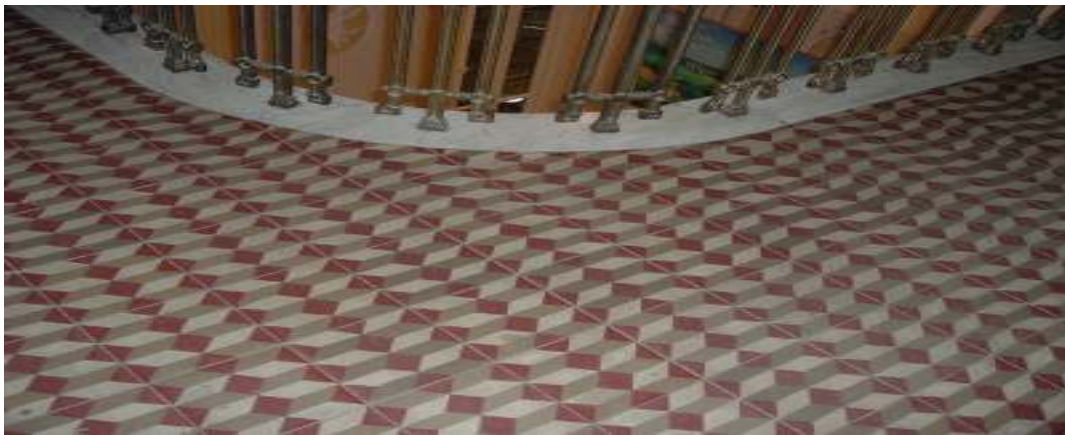
Fig. 77 - Detalhe do piso, ladrilho hidráulico importado da Itália — Centro Cultural Fonte: foto da autora – Ago/2004
