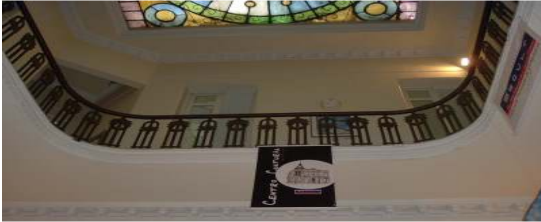
Fig. 76 – Mezanino com grade em bronze – Centro Cultural Fonte: foto da autora – Ago/2004
