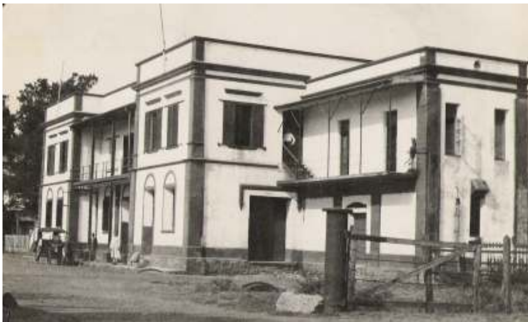
Fig. 35 - Primeira Estação Ferroviária de Uruguaiiana – sem data Fonte: Acervo da sala Raul Pont – Centro Cultural
