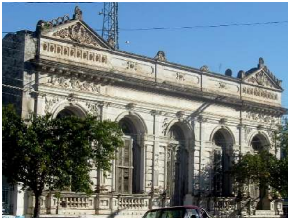
Fig. 41 - Prédio Rua Santana, nº 2588 esquina com a Rua XV de Novembro (Casarão) Fonte: Foto da autora – Ago/2005
