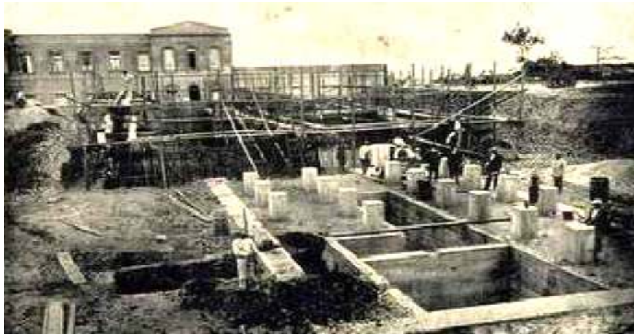
Fig. 18 - Fábrica de cimento em construção. Fonte: www.portaluruguaiana.com.br
