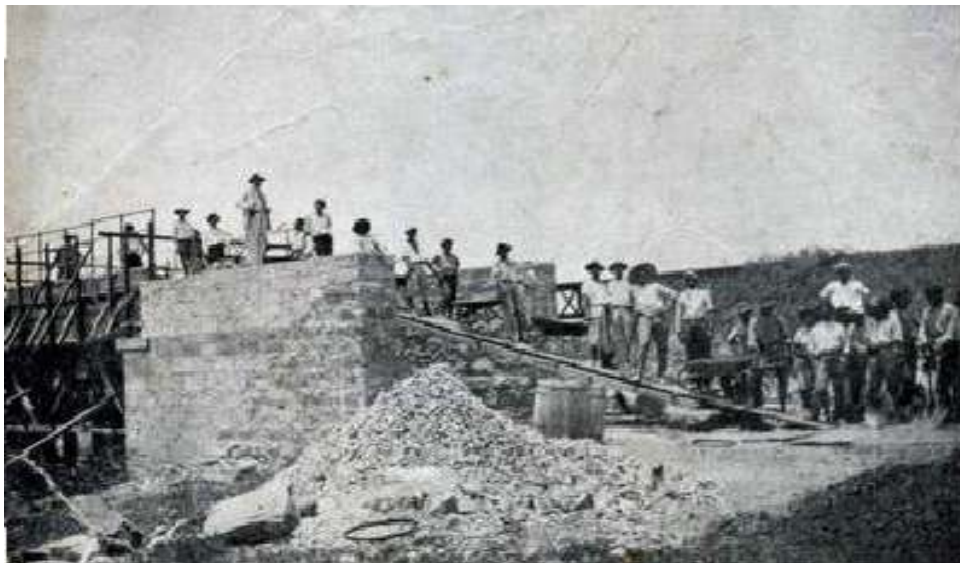
Fig. 16 - Construção da Ponte Salso. Fonte: www.portaluruguaiana.com.br
