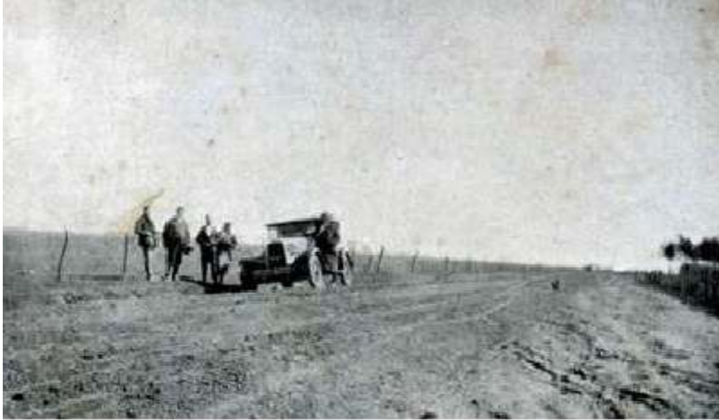
Fig.12 - Aterramento para construção de estradas e Obras de saneamento Fonte: www.portaluruguaiana.com.br
