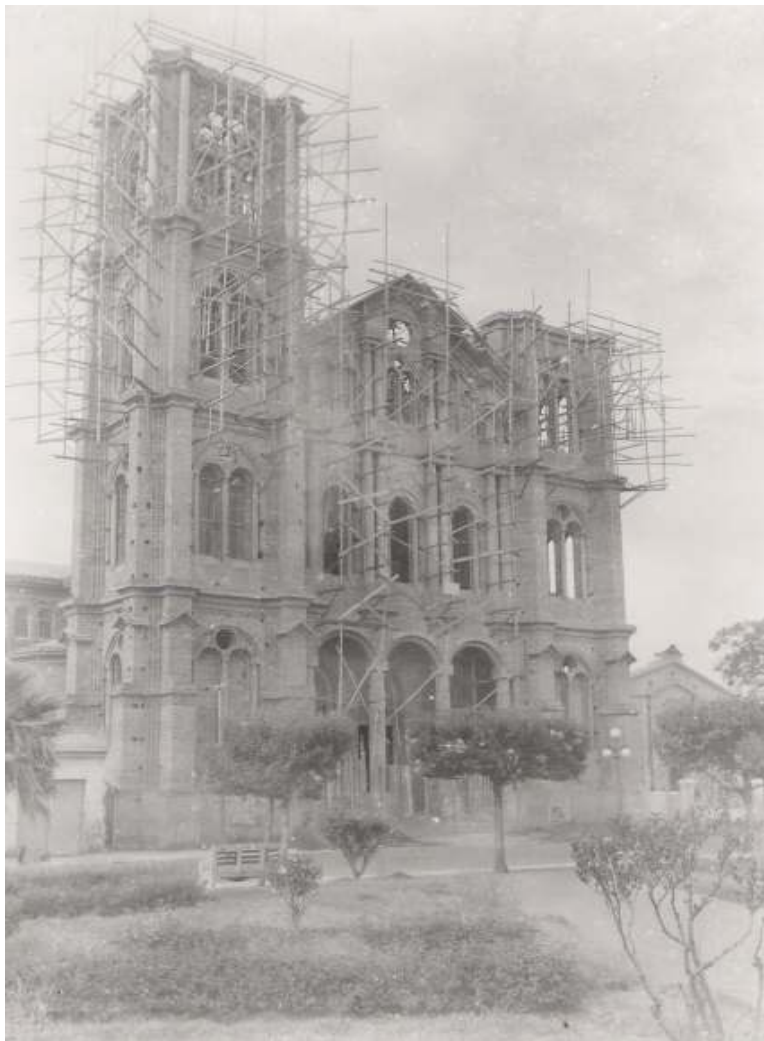
Fig. 57 - Término da construção da Catedral de Santana – sem data Fonte: Arquivo Histórico de Uruguaiana – Centro Cultural
