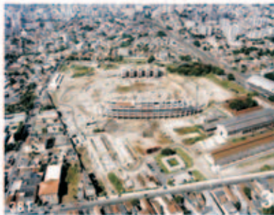
Evolução das obras do Estádio Olímpico
