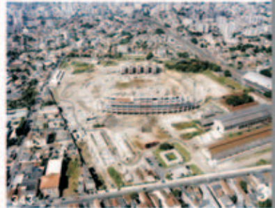
Evolução das obras do Estádio Olímpico
