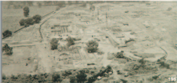
Vila Olímpica (canteiro de obras)
