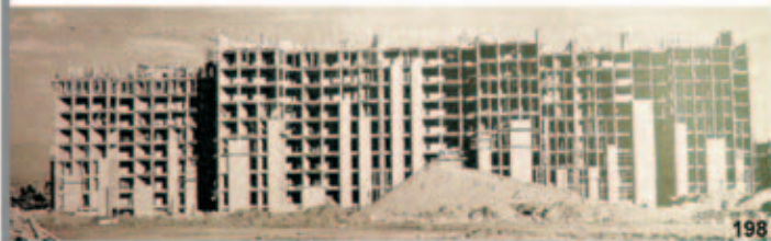
Vila Olímpica (construção)
