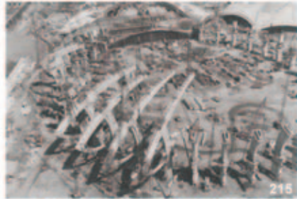
Estádio Olímpico (construção)
