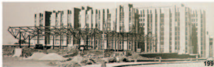
Vila Olímpica (construção)
