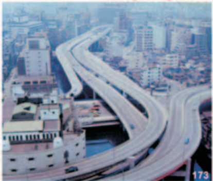
Estrutura viária (Edobashi) 173
