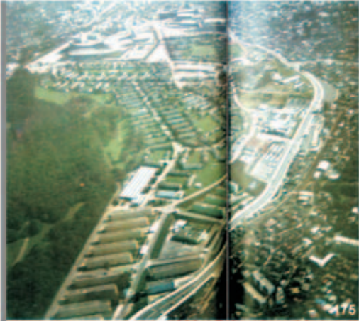
Vila Olímpica (Yoyogi)
