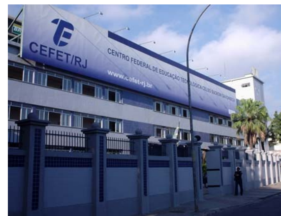
Fig.VIII.2: Foto da fachada principal do prédio do CEFET. Avenida Maracanã. (Fonte: foto do AUTOR,2006)
