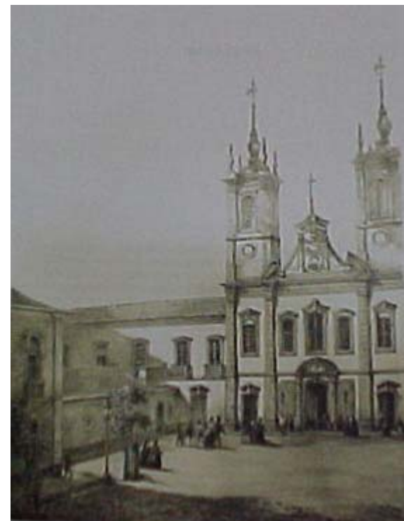
Fig.VI.1: Igreja de São Joaquim (1758) posteriormente demolida para o prolongamento da atual av. Marechal Floriano, ao lado da qual existiu o Seminário de São Joaquim, transformado em Colégio Pedro II (edifício representado ao lado esquerdo na ilustração). (Fonte: DORIA, 1937, p.viii)
