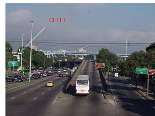
Fig.VIII.21: Aspecto visual e relação de escala na Rua Camerino, esquina da Avenida Marechal Floriano (Foto do autor,2006).
