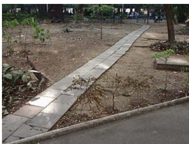
Fig.VIII.85: O traçado aleatório e sem planejamento dos canteiros gerou “conflitos” entre o fluxo dos usuários e a vegetação. Esta foto ilustra a necessidade da colocação de placas de concreto nos canteiros para que os usuários pudessem locomover-se sem danificar os vegetais (Fotos do autor,2004).
