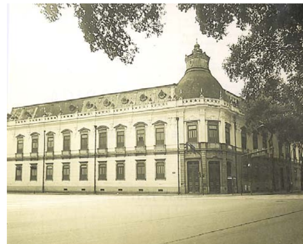
Fig.VI.2: Colégio Pedro II. Vista atual do Externato, na av. Marechal Floriano (antiga rua Larga de São Joaquim, esquina com a rua Camerino (antiga rua do Valongo, depois rua da Imperatriz). (Fonte: DORIA,1937, p.10)
