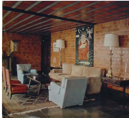
1.2.4 - Residência do Arquiteto - Na sala da residência do arquiteto na Av. Niemeyer, assim como em toda a casa, a laje é aparente. Por não esconder o material, nesse e em outros projetos, Bernardes contribuiu para difundir a indústria de pré-moldados no Brasil. Uma laje que simplificou bastante o processo da laje de concreto armado moldada in loco .
