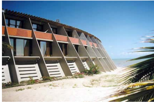
1.4.15 – 1.4.16 – 1.4.17 – 1.4.18 - Hotel Tambaú - Detalhes das estruturas, abaixo dos quartos, que criam o efeito do “bochecho”, principalmente, quando o mar está agitado. Pelo outro lado, o talude gramado esconde a construção por trás de uma grande duna.
