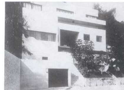
1.1.1 – 1.1.2 - Gregori Warchavchik – Casa na rua Itápolis, Pacaembu, São Paulo, 1928 e Casa na rua Thomé de Souza, São Paulo, 1929.
