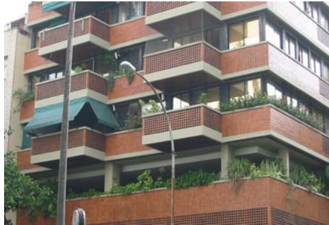
1.2.7 - Um exemplo posterior de uso dado por outros arquitetos ao Tijolo-cubo foi o edifício projetado por Luis Paulo Conde, em Ipanema, no Rio de Janeiro. Nele, Conde utilizou o Tijolo-cubo como fechamento de toda a fachada, sendo que nas varandas, foi colocado como cobogó formando as muretas de guarda-corpo.
