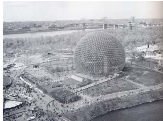
2.3.1.13 – 2.3.1.14 – 2.3.1.15 - Exposição Universal de Montreal - A estrutura de 76 m de diâmetro por 61 m de altura, fechada por 1.900 painéis de acrílico, ficou em exposição permanente até ser destruída em um incêndio em 1976.
