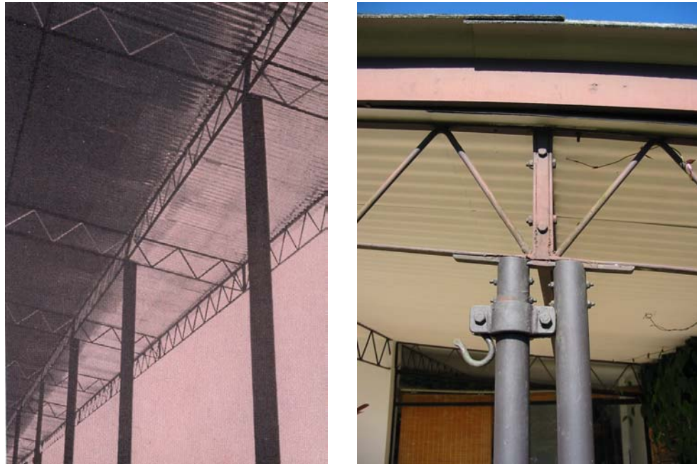
1.1.17 – 1.1.18 - Residência Lota Macedo Soares - Nas treliças, os vergalhões de \frac{1}{2} " foram pintados de branco e as barras de \frac{1}{4} " por 1", de preto. O telhado de alumínio não dispunha de acabamento (esquerda). Hoje, as treliças estão pintadas de preto, o alumínio original de branco e por cima deste foram colocadas telhas de amianto, formando um colchão de ar.
