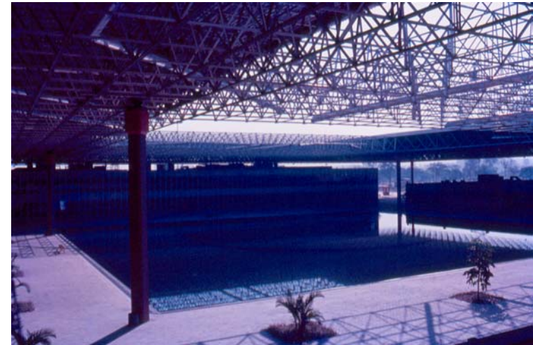
1.3.21 – 1.3.22 - Schering - Os tubos que recolhem a água que cai na cobertura são direcionados, entre a estrutura espacial, para o espelho d'água, e caem formando cascatas.
