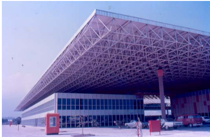
1.3.20 - Schering - A treliça espacial de três metros de altura encontra-se a nove metros do chão. Os pilares foram dispostos com vãos livres de 40 metros e balanço de 10 metros nas extremidades.
