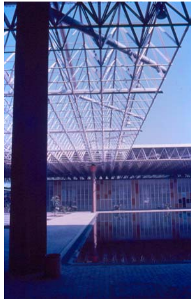
1.3.21 – 1.3.22 - Schering - Os tubos que recolhem a água que cai na cobertura são direcionados, entre a estrutura espacial, para o espelho d'água, e caem formando cascatas.
