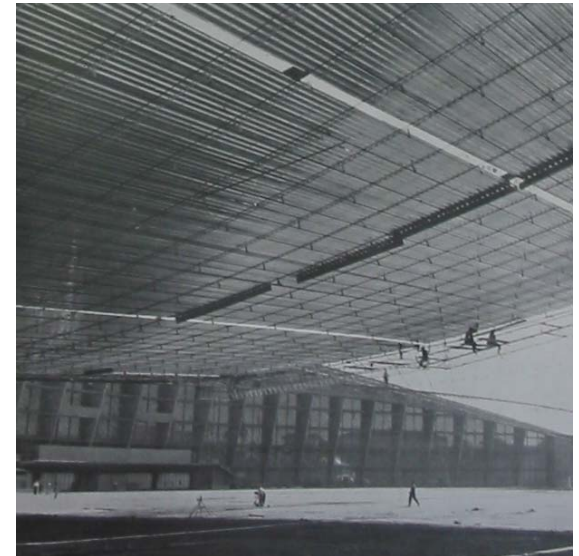
Planta da cobertura do pavilhão e vista da montagem da cobertura com telhas de alumínio. (imagens: revista Acrópole nº 265, p.19-20)
