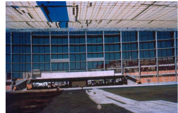
1.2.9 - No Pavilhão de São Cristóvão, o tijolo cerâmico vazado foi utilizado como fechamento, sem obstruir a ventilação.
