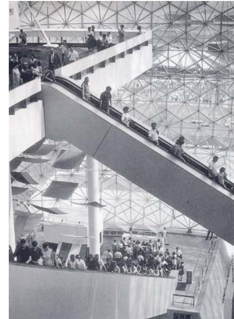
2.3.1.13 – 2.3.1.14 – 2.3.1.15 - Exposição Universal de Montreal - A estrutura de 76 m de diâmetro por 61 m de altura, fechada por 1.900 painéis de acrílico, ficou em exposição permanente até ser destruída em um incêndio em 1976.
