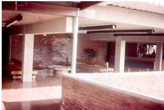
1.2.8 - No Hotel Tambaú, os materiais foram escolhidos pela sua simplicidade e durabilidade. Contrariamente a um hotel cinco estrelas convencional, sua estrutura em concreto armado foi mantida aparente, assim como as alvenarias cerâmicas.
