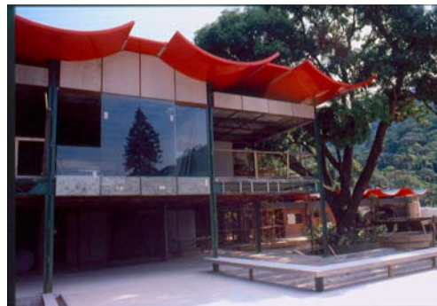
1.4.27 – 1.4.28 - Residência Willian Koury - Vista da fachada de perfis metálicos ainda em construção.
