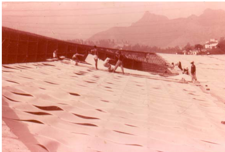
ImageM da colocação das placas da cobertura.
