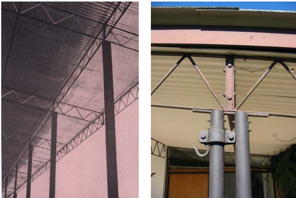
1.1.17 – 1.1.18 - Residência Lota Macedo Soares - Nas treliças, os vergalhões de ½” foram pintados de branco e as barras de ¼” por 1”, de preto. O telhado de alumínio não dispunha de acabamento (esquerda). Hoje, as treliças estão pintadas de preto, o alumínio original de branco e por cima deste foram colocadas telhas de amianto, formando um colchão de ar.
