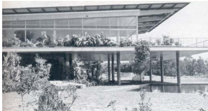
1.2.3 - Muitos arquitetos faziam uso de longos beirais. Rino Levi e Roberto Cerqueira César projetaram em 1954 a Residência de Olívio Gomes utilizando-se de tal recurso. Entretanto, para viabilizar o longo beiral foram necessárias vigas de concreto armado em balanço em conjunto com travessas de madeira pouco espaçadas.
