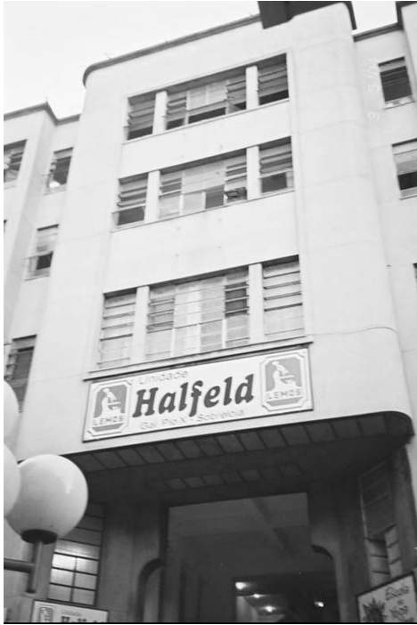
Fig. 30– Galeria Pio X, fachada rua Halfeld
