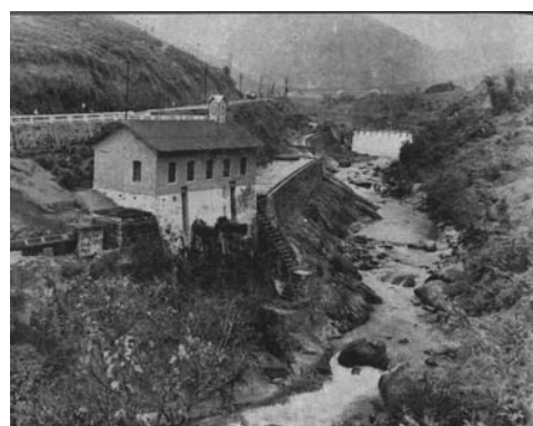
Fig.21 – Usina Hidrelétrica de Marmelos.
