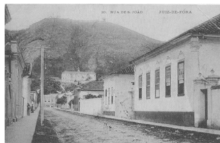
Fig. 18 – Rua São João
