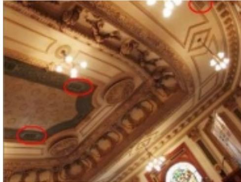
Fig. 4.07 – C.C.J.F. – Sala de Sessões – Detalhe da saída de ar condicionado.
