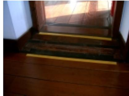
*Fig. 3.20 – Paço - Rampa com faixas antiderrapantes para circulação entre as salas, 2006.*
