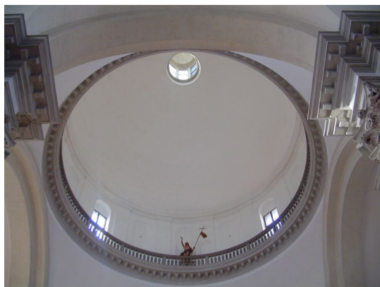
Figura 127 (acima): Cúpula vista internamente
