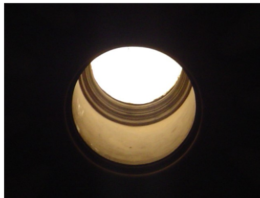
Figura 42: Vista interna da lanterna da Sagrestia Vecchia, em San Lorenzo
