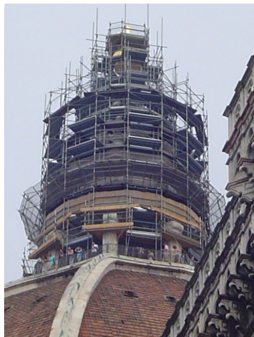
Figura 32: Detalhe da lanterna
