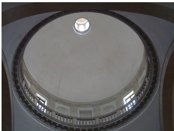
Figura 113 (acima): Cúpula vista internamente
