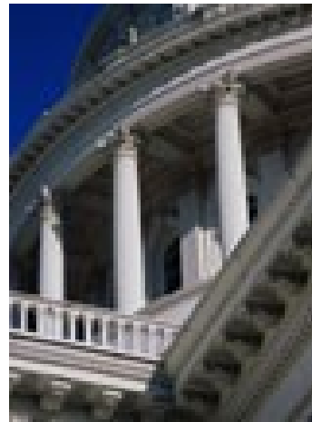
Figura 72: Estrutura da cúpula do American Capitol
