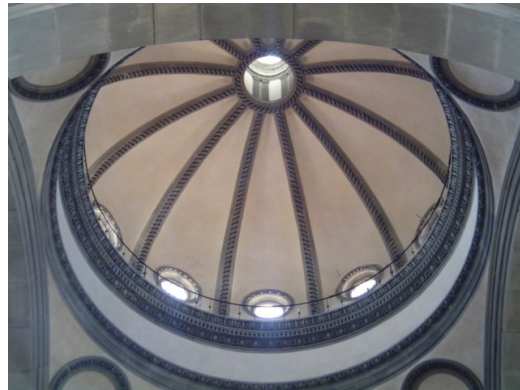
Figura 46: Vista interna da cúpula da Igreja de Santo Spirito
