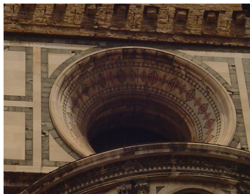
Figura 33: Detalhe de uma das oito aberturas circulares do domo
