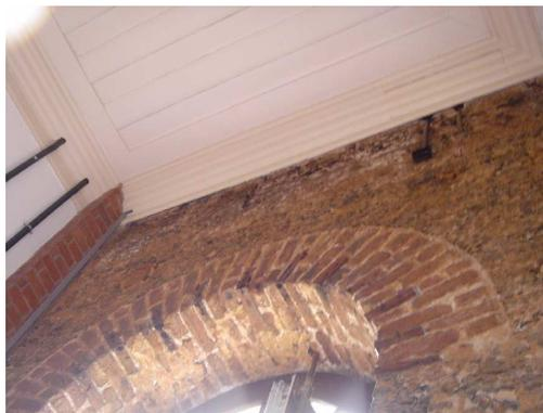
Fig. 65: Parede em alvenaria de pedra, com arco em tijolos.
