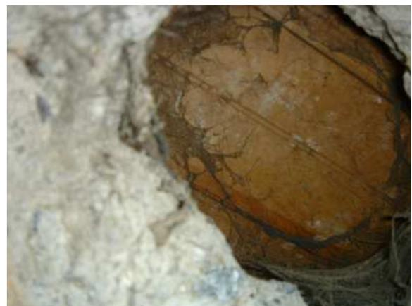
Fig. 61: Laje em concreto; orifício mostra as tábuas se assentando direto sobre ela.
