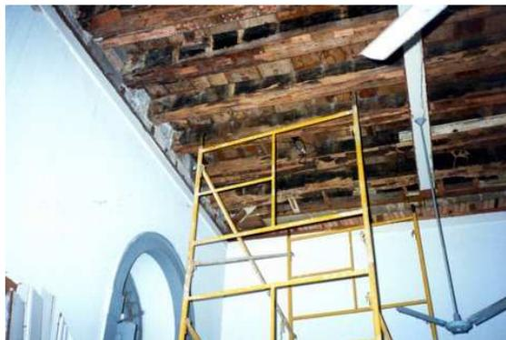
Fig. 56: Vigas do piso superior e forro da FE.
