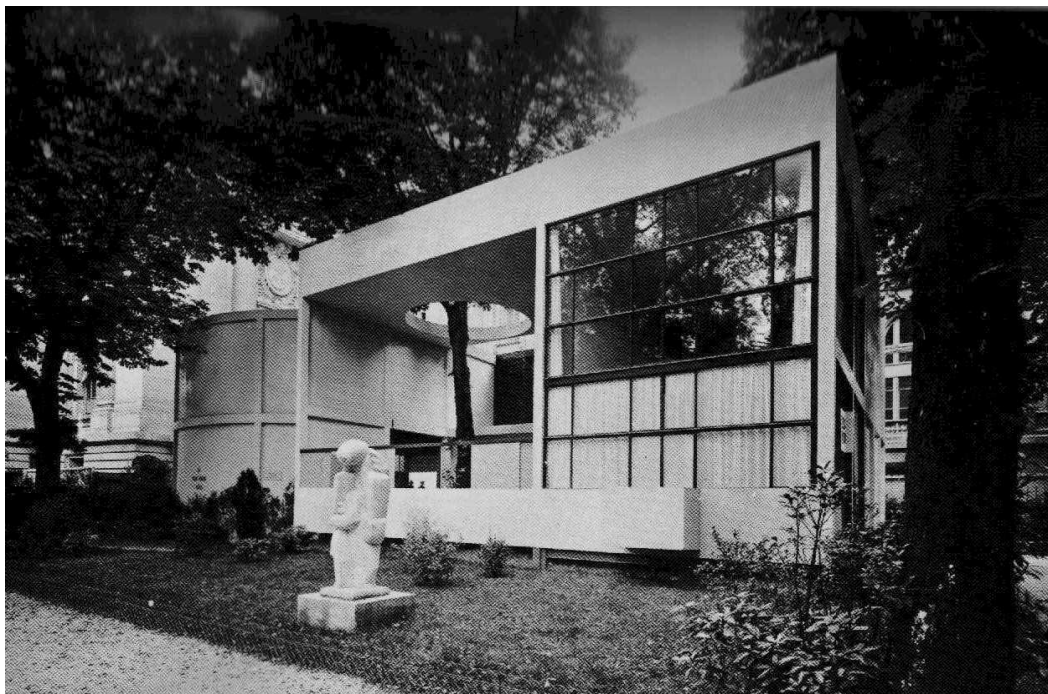
figura 44 - LE CORBUSIER, Pavillon de L'Esprit Nouveau, Paris, 1925.
