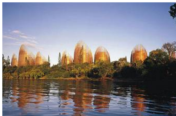
Figura 61: Centro Cultural Jean-Marie-Tijbaou (1991-1998) - Nova Caledônia Arqt. Renzo Piano Fonte: Gössel & Leuthäuser (2001:400)
