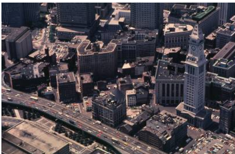
Figura 96: Vista da cidade de Boston, destaque para a Central Artery e “espaços perdidos”
