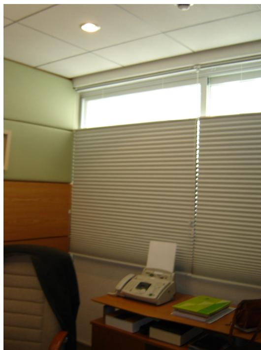
Figura 45 – Sala de Reunião e Superintendência - Elemento interno, com movimento horizontal que bloqueia totalmente a iluminação natural, em parte da janela.
