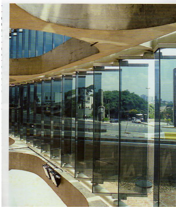
Figura 19 – Utilização de dispositivos de proteção solar em vidro laminado
