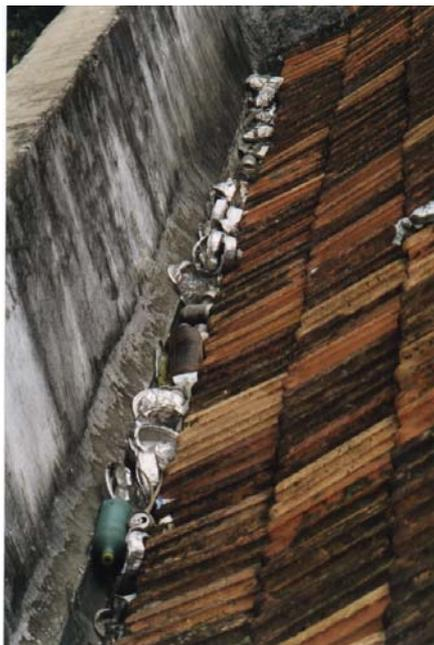
**Figura 90 – Calha entupida por lixo jogado de prédio vizinho. Fonte: Projeto de Restauro RB762/UFRJ, 2003.**
