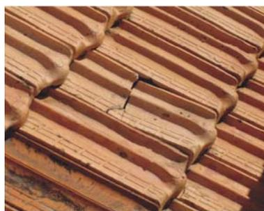
**Figura 87 – Telha quebrada.**
