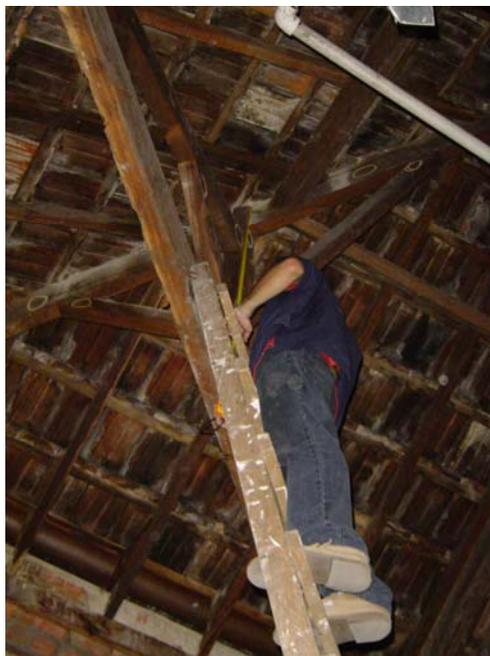
**Figura 138 – Estagiário medindo altura da tesoura por baixo da mesma. Fonte: Projeto de Restauro RB762/UFRJ, 2004.**
