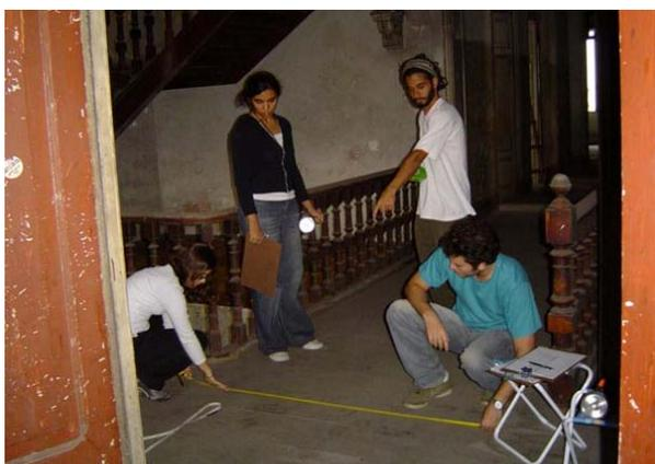
Figura 5 – Equipe fazendo levantamento métrico de um piso. Fonte: Projeto de Restauo RB762 - UFRJ, 2004.
