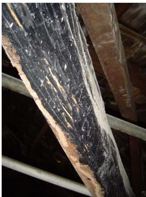
**Figura 96 – Peça das estruturas de um telhado danificada pelo fogo: perda das propriedades físicas e diminuição da resistência. Fonte: projeto de Restauo RB762/UFRJ, 2003.**
