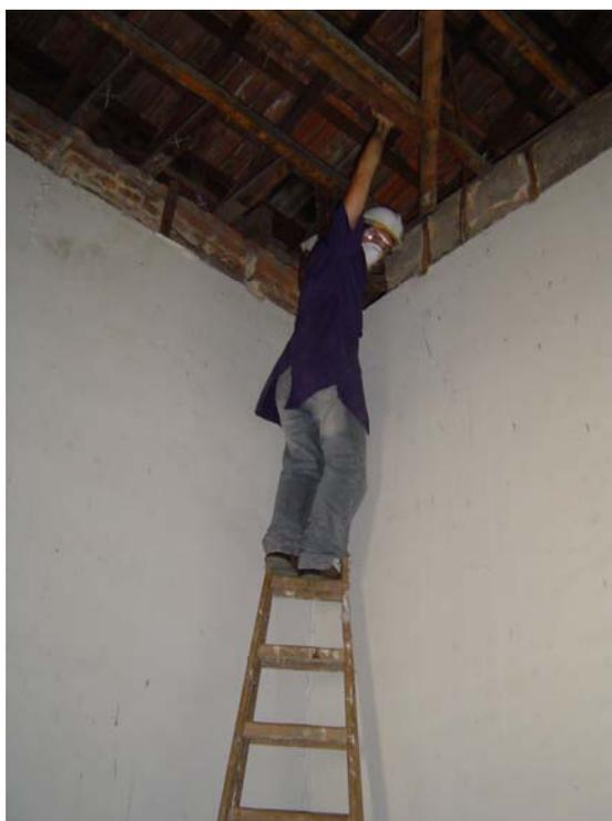
**Figura 137 – Dificuldade de acesso às estruturas do telhado. A partir deste ponto, se o técnico quisesse subir, deveria escalar a parede, pendurado à linha baixa. Fonte: Projeto de Restauro RB762/UFRJ, 2004.**
