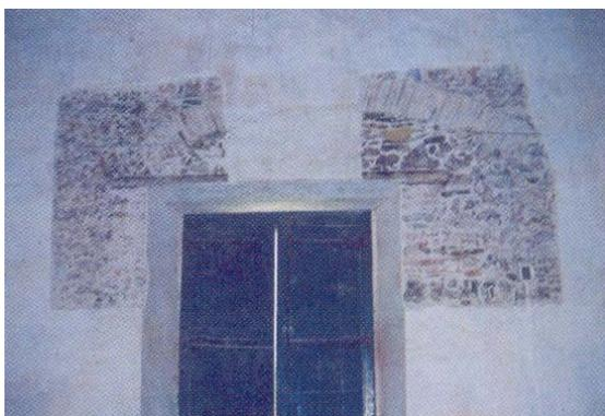
**Figura 12 – Prospecção de alvenaria, identificando uma alteração no vão original de uma esquadria, que fora diminuído e modificado. Fonte: IPHAN. 2005, p. 47.**
