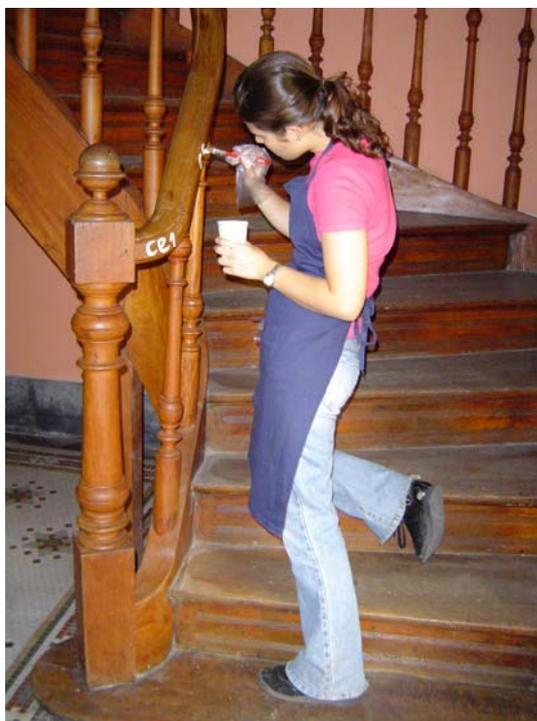
**Figura 108 – Mapeamento *in loco* das peças de uma escada de madeira com tinta a base de água. Fonte: Projeto de Restauro RB762/UFRJ, 2003.**
