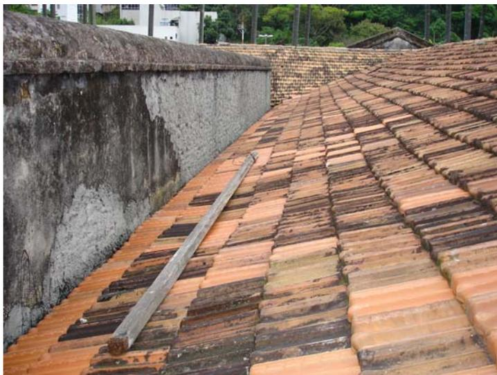
**Figura 89 – Trecho de telhado embarrigado. O dano pode ser visto com a ajuda da peça de madeira posicionada sobre o manto. FONTE: Projeto de Restauração do Antigo Educandário Santa Teresa - Velatura Restaurações, 2006.**
