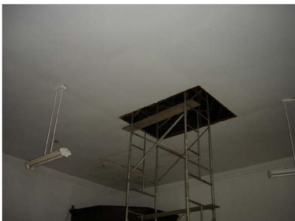
**Figura 64 – Infra-estrutura de acesso ao entreferro com alçapão aberto no forro para a passagem das passarelas e da equipe de levantamento. Fonte: Projeto de Restauração do Antigo Educandário Santa Teresa – Velatura Restaurações, 2005.**
