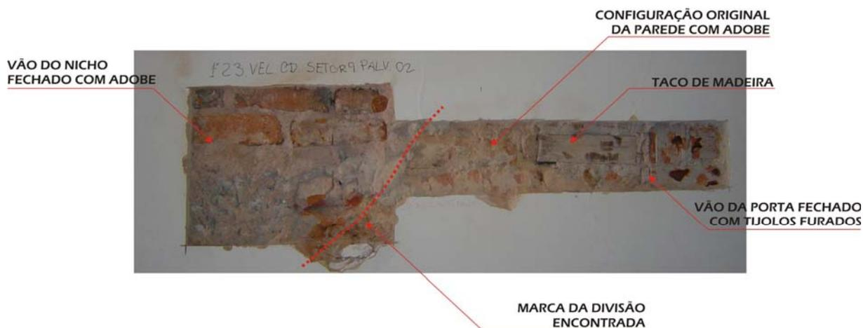
**Figura 112 – Prospecção de alvenaria feita entre uma porta e um nicho de imagem, com a indicação dos elementos e a confirmação da hipótese criada. Fonte: Projeto de Restauração do Antigo Educandário Santa Teresa – Velatura Restaurações, 2006.**
