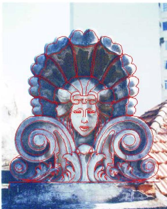
**Figura 116 – Fotografia servindo de base para o registro métrico do ornato. Fonte: Projeto RB762/UFRJ, 2003.**
