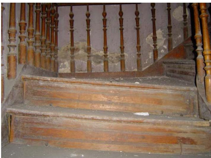
**Figura 107 – Escada com problemas estruturais apresentando desnivelamento dos pisos. Fonte: Projeto de Restauro RB762/UFRJ , 2003.**
