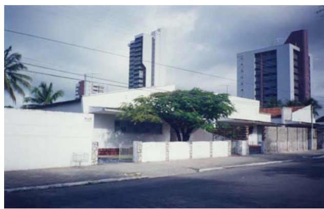
FIGURA 75: Registro da elevação dos muros. Fonte: Acervo pessoal.
