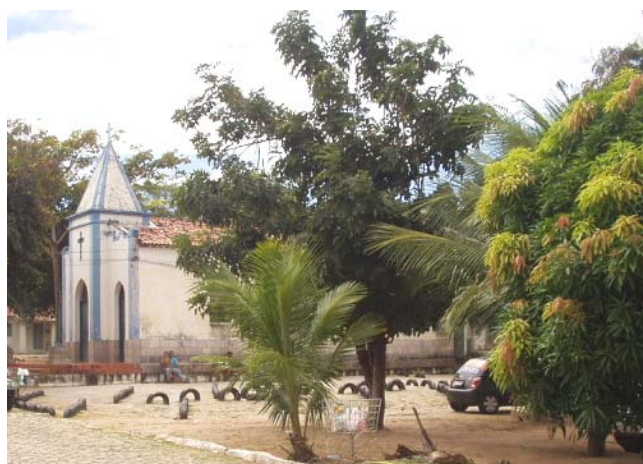
FIGURA 90: Vista da igreja. Foto atualizada. Fonte: Acervo pessoal.
