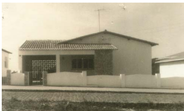
FIGURA 98: Residência na Av. Alexandrino de Alencar.
