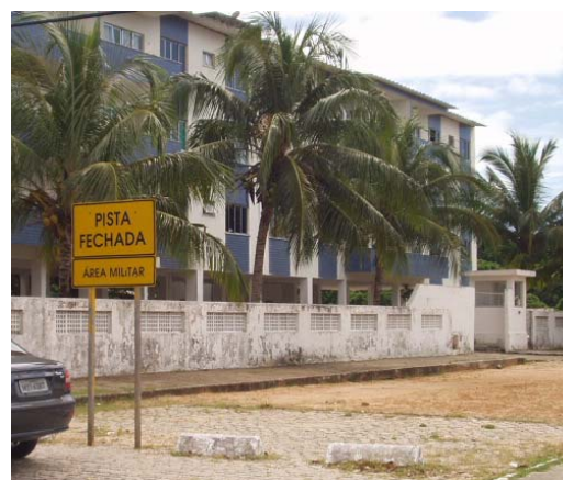
FIGURA 101: Vista da Rua Severiano da Fonseca, fechada por tijolos baixos.
