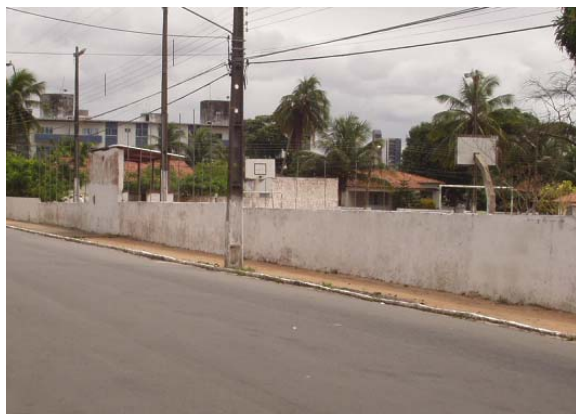
FIGURA 102: A área de lazer a margem da Av. Alexandrino de Alencar encontra-se murada. Foto atualizada.
