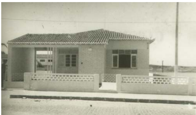
FIGURA 96: Residência na Rua Sargento Wolff, na década de 1940.
