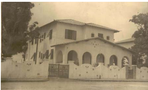
FIGURA 30: Residência com dois pavimentos, década de 1940. Fonte: Acervo iconográfico do Serviço de Documentação da Marinha – RJ.
