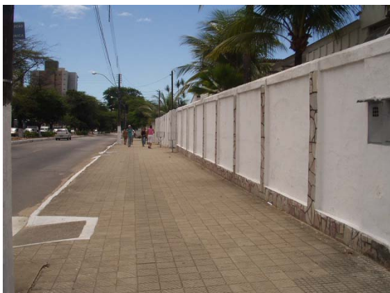
FIGURA 76: Atualmente, todas as residências voltadas para a Avenida Hermes da Fonseca e algumas da Avenida Alexandrino de Alencar tiveram seus muros elevados, de forma que, o transeunte não tem a visão das fachadas. Foto atualizada. Fonte: Acervo pessoal.
