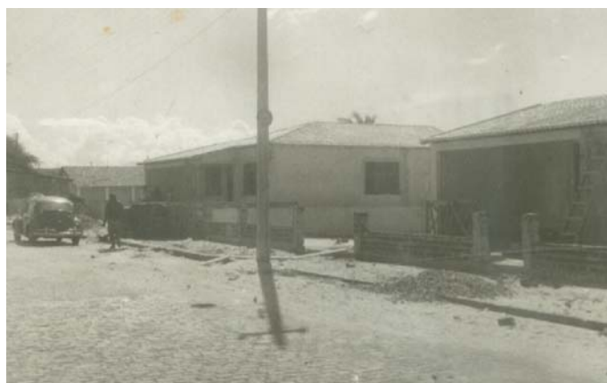
FIGURA 93: Foto das residências em construção. Fonte: Acervo do Arquivo Histórico do Exército - RJ.
