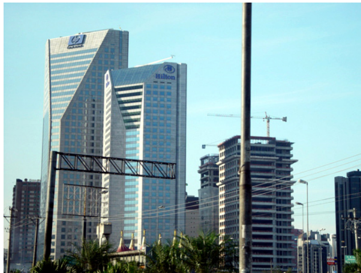
Foto 21: Edifício da HP e Hotel Hilton na Av. das Nações Unidas
