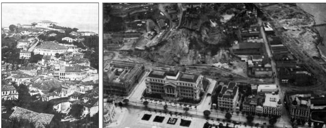
FIG. 076. Morro do Castelo: primeiros cortes no núcleo inicial da cidade (1904). O morro do Castelo era predominantemente ocupado por população de mais baixa renda. Ele sofreu o primeiro corte, em 1904, para a abertura da Av. Rio Branco. A nova ocupação foi eminentemente institucional. Fonte: AGCRJ, Viana (2001).
