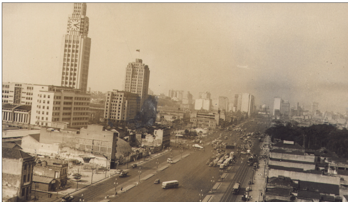
FIG. 009. A Av. Presidente Vargas parcialmente concluída. A convivência de diversos momentos da história urbana carioca identifica este grande eixo viário desde o início das obras na década de 1940. Fonte: A.N.
