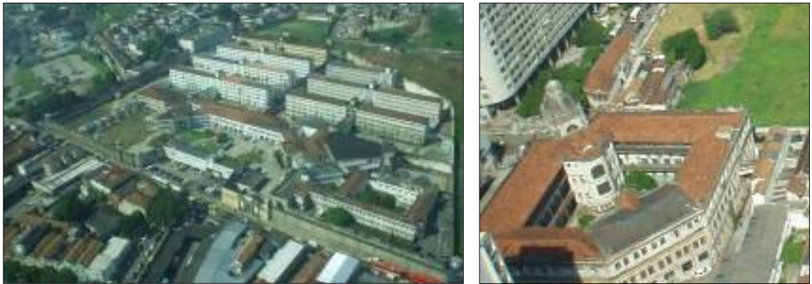
FIG. 061. Vazios com forte significação simbólica. Desativação do sistema penitencial da rua Frei Caneca e da antiga sede da Polícia Civil, na Rua Henrique Valaderes projetada por Heitor de Mello, 1910. Fotos: JPJ, 2005.
