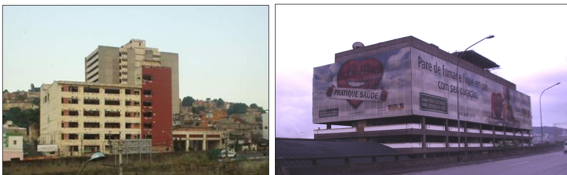
FIG. 045. Grandes vazios conjunturais: Sede do IBGE em São Cristóvão, próxima à Mangueira e sede do Jornal do Brasil, no Caju. Imóveis desafetados em consequência de problemas internos às empresas. Fonte: IPP; AB, 2005.
