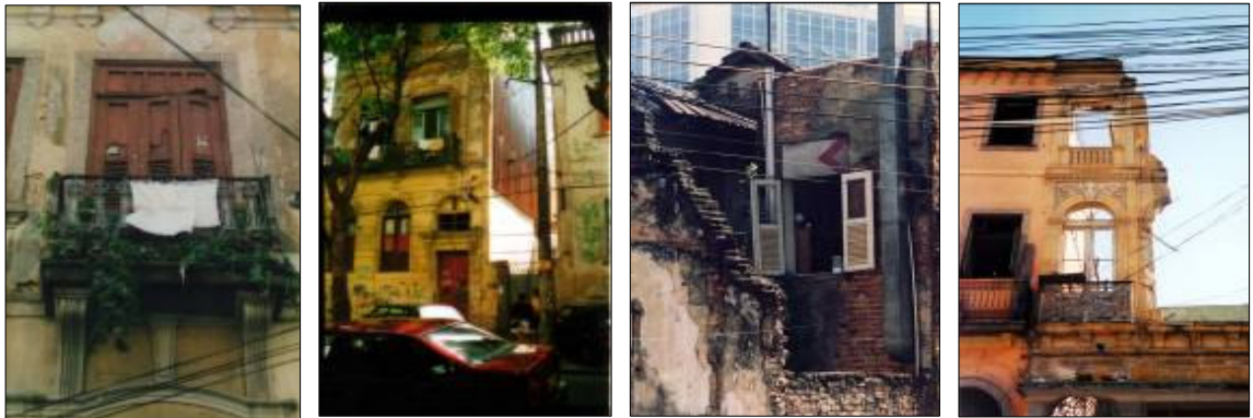
FIG. 054. As ruínas urbanas. Área Central/Lapa. "...em muitas ruínas urbanas, que seguem habitadas, sentimos que são os homens que permitiram a destruição. (...) Nas ruínas habitadas falta o equilíbrio entre o elemento material e o elemento espiritual presente nas ruínas abandonadas. E, assim, as ruínas habitadas tomam esse aspecto problemático, inquieto e amiúde insuportável, de lugares de onde se retiraram a vida e que, sem dúvida, aparecem todavia como recintos e marcos de uma vida".(Simmel, 1998). Fotos: AB (1998, 2004).
