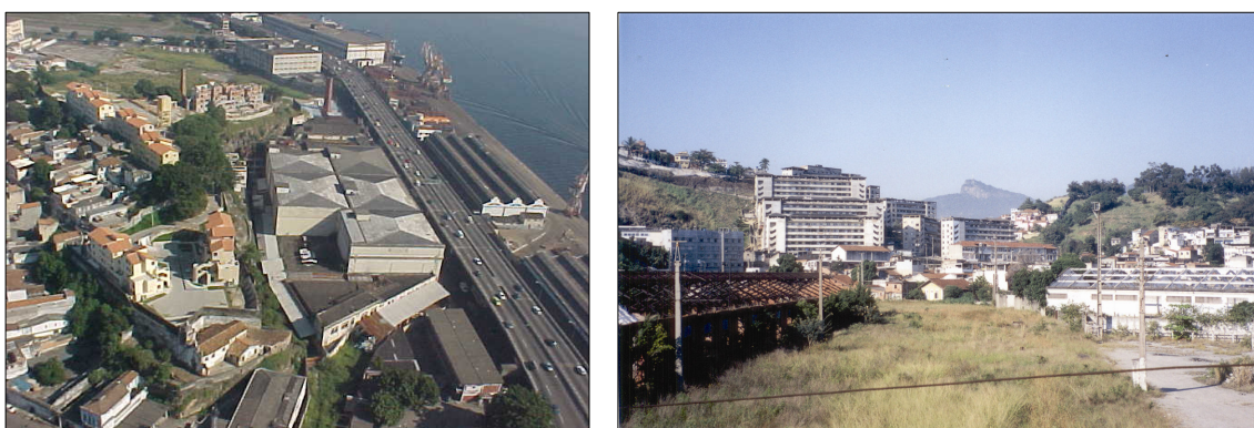
FIG. 044. Vazio estrutural da antiga área portuária. Esta área se constitui em um grande vazio estrutural na área urbana central que agrega além dos vazios da atividade portuária, vazios de atividades correlatas como os armazéns da Cibrazem, na foto 1 e vazios ferroviários, como o pátio da marítima, da foto 2) recentemente reconvertido em Cidade do Samba. Fotos: JPJ, 2005; AB, 2003.
