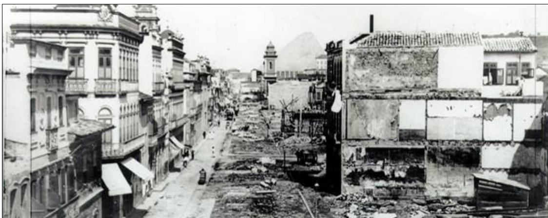
FIG. 071. Reforma Urbana 1903-1906. Alargamento da Rua Uruguaiana. Cenário que iria se repetir, de maneira diferente, nas intervenções urbanas que cortaram a área ao longo do século XX. Fonte: AGCRJ.
