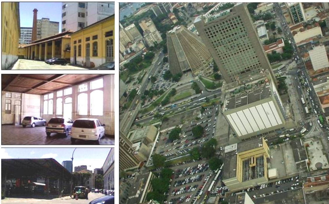
FIG. 093. Vazios urbanos e o automóvel. Seja ocupando o interior da fábrica desativa a Kanitz, na Cruz Vermelha (as duas fotos acima à esquerda), seja em estacionamentos na Esplanada do Castelo, ou em torno da Catedral, na Esplanada de Santo Antonio, o grande protagonista dos vazios urbanos nas áreas dos desmontes dos morros do Senado, Castelo e Santo Antonio, é o automóvel. Fonte: AB, 2006 e JPJ, 2005.
