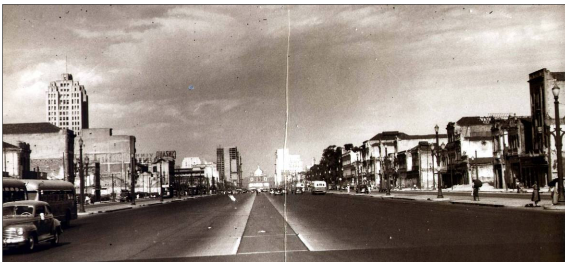
FIG. 143. A Av. Presidente Vargas recém-aberta (1944). Várias categorias de vazios urbanos se somam neste grande vazio espacialmente definido pela largura da avenida com a demolição dos sobrados da margem sul (à direita) ainda hoje subtilizados para estacionamento e a implantação do metrô. A eles se somam vazios conjunturais e desestabilizações em torno desses vazios. Foto: AN.
