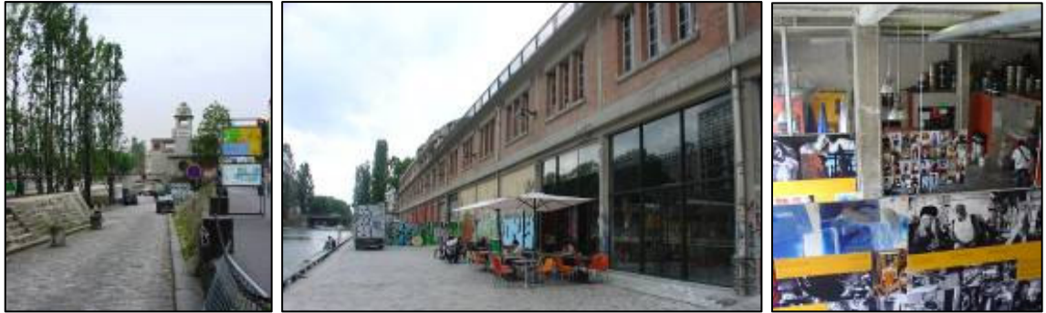
FIG.032. Point Éphémère, Paris. Apropriação cultural às margens do Canal Saint Martin. Fotos: AB, 2005.
