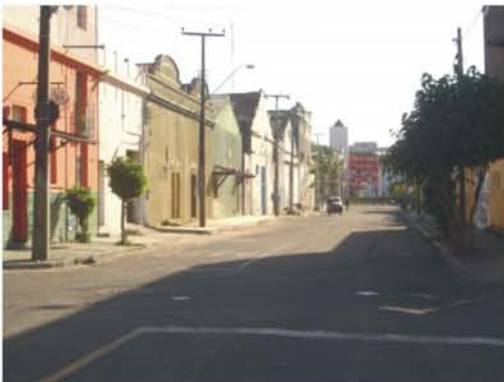
Fig. 04 - galpões do entorno do Centro Dragão do Mar
