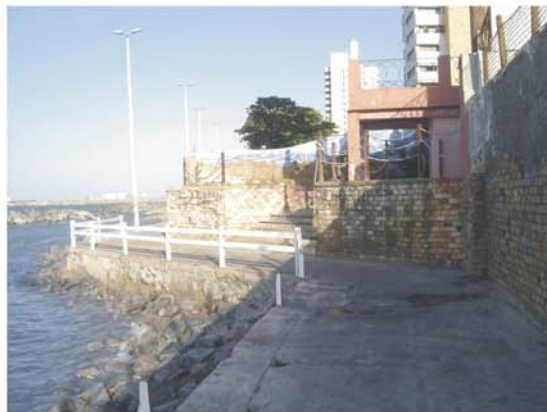
Fig. 110: edificações degradadas e abandonadas no calçadão
