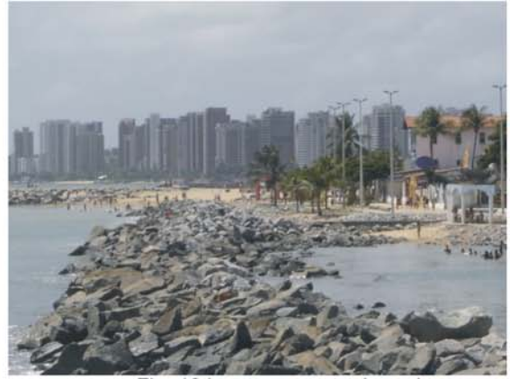
Fig. 134: enrocamento de pedras que acompanha parte da costa da Praia de Iracema para conter a maré
