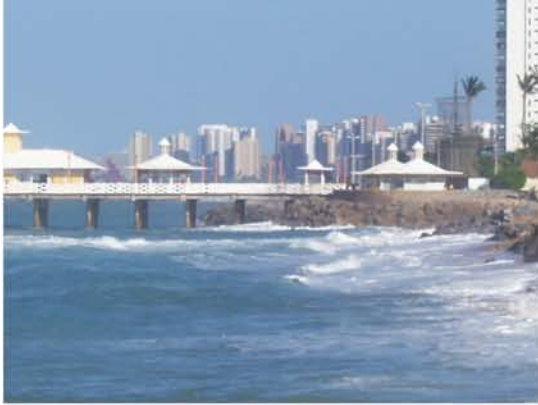
Fig. 139: Praia do Poço
