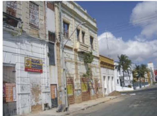
Fig. 05 - galpões do entorno do Centro Dragão do Mar
