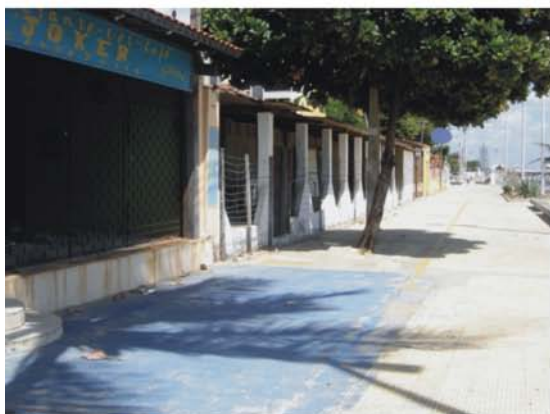
Fig. 111: edificações degradadas e abandonadas no calçadão
