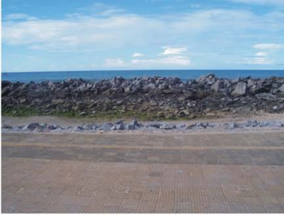
Fig. 133: enrocamento de pedras que acompanha parte da costa da Praia de Iracema para conter a maré
