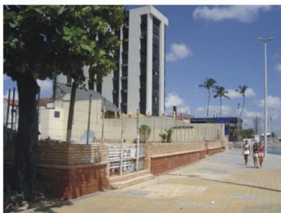
Fig. 112: edificações degradadas e abandonadas no calçadão
