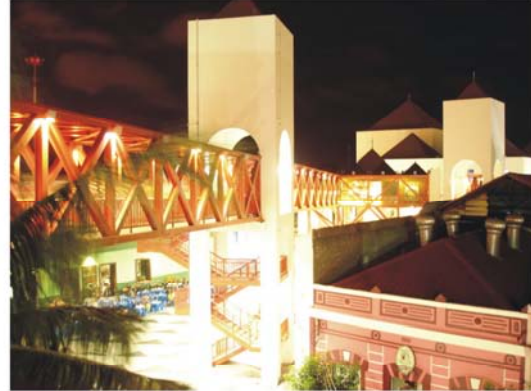
Fig. 100: passarela do CDMAC
