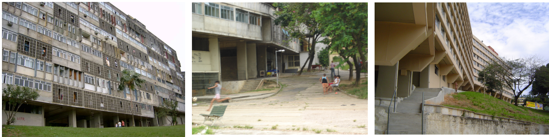
Fotos 11, 12 e 13: Volume sobre pilotis Fonte: AUTOR, 2005/ MORADOR, [1998]/ LABHAB, 2005
