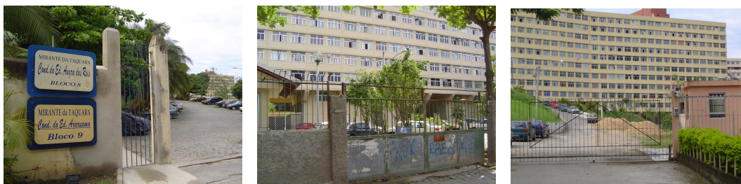
Fotos 2, 3 e 4: Portarias dos blocos de apartamentos Fonte: AUTOR, 2006
