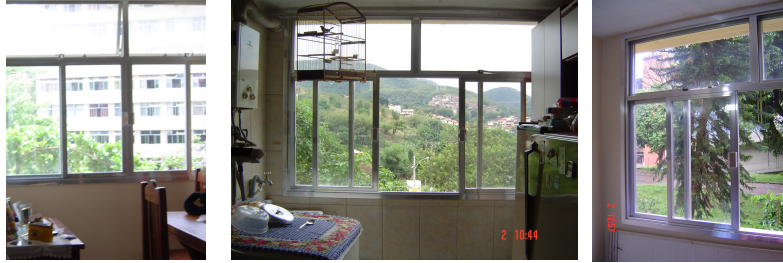
Foto 45, 46 e 47: Esquadrias atuais de alumínio Fonte: AUTOR, 2005
