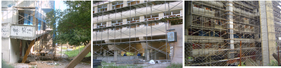
Foto 40, 41 e 42: Obra de reforma estrutural no conjunto doCafundá Fonte: CHAGAS, [2002].
