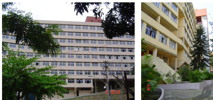
Fotos 50 e 51: Fachada reformada Fonte: AUTOR, 2005
