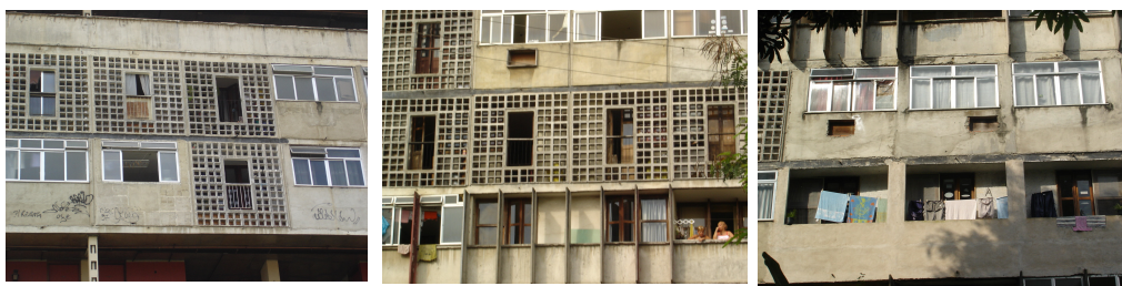
Fotos 64, 65 e 66: Alteração das fachadas devido modificações dos moradores Fonte: LABHAB, 2005
