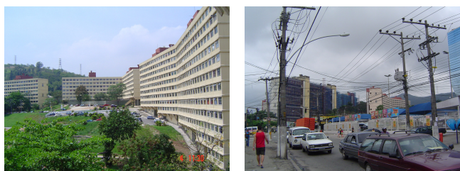
Fotos 105 e 106: Bloco 8, 9, 10 – Área verde / Blocos 1 - Área externa Autor: AUTOR, 2006
