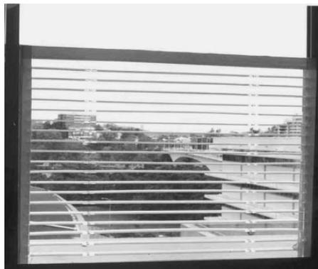
Figura 24 - Painéis Laser-cut com espessura de 20mm , formando uma espécie de veneziana, instalada em sanduíches de vidro, com a função de rejeição de grande parte da de luz solar incidente.
