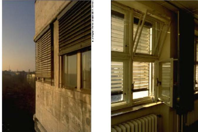
Figura 15 - Persiana externa. Edifício Shell – Berlim, Alemanha. Fonte: RUCK et al (2000).
