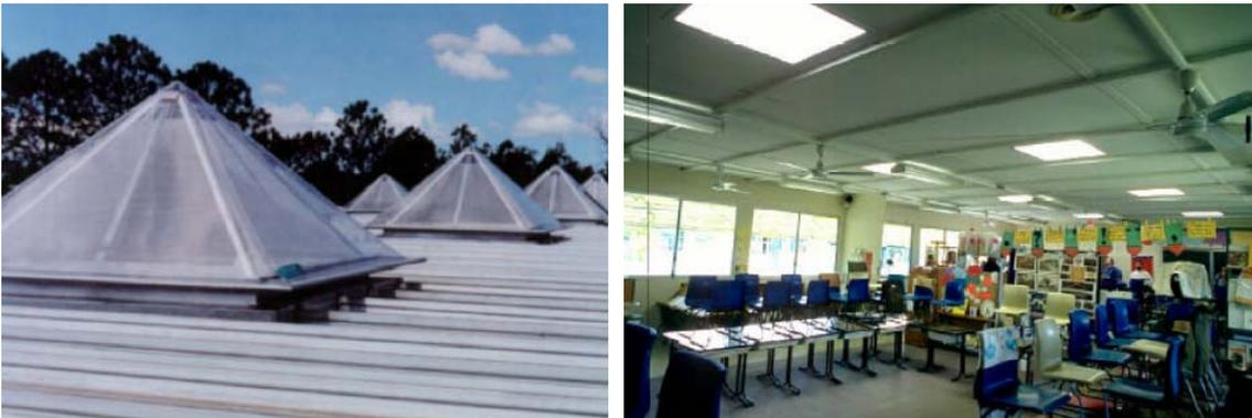
Figura 26 - Escola Waterford, Austrália. Exemplo de aplicação do painel laser-cut na iluminação zenital seletiva. Fonte: RUCK et al, 2000.
