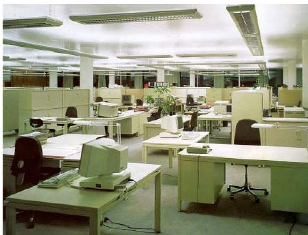
Figura 42 - Exemplo de utilização de sistema de iluminação direto-indireto conjugado à iluminação de tarefa. Fonte: Cd Osram
