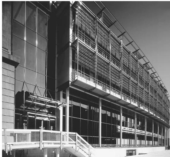
Figura 19 - Edifício SBV, Suíça. E estrutura em frente ao pano de vidro sustenta painéis prismáticos móveis. Fonte: Ruck et al, 2000.
