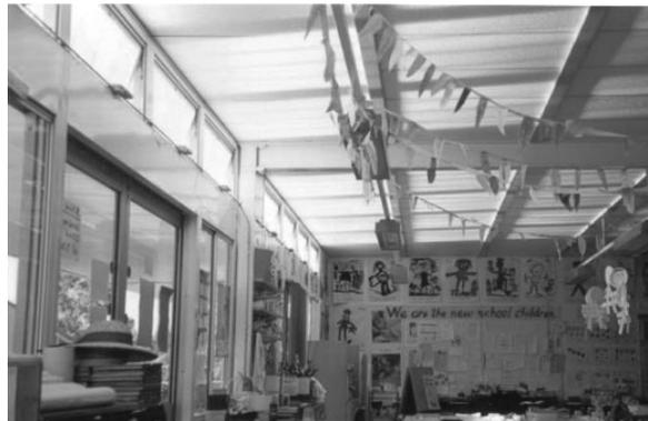
Figura 23 - Escola Kenmore South State, Austrália. Exemplo de aplicação de laser-cut panel na parte superior da janela para defletir a luz solar para o teto sa sala de aula.
