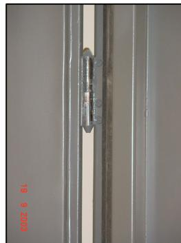
**Figura 31:** exemplo de vedação de portas com encaixe tipo “macho-fêmea”.
