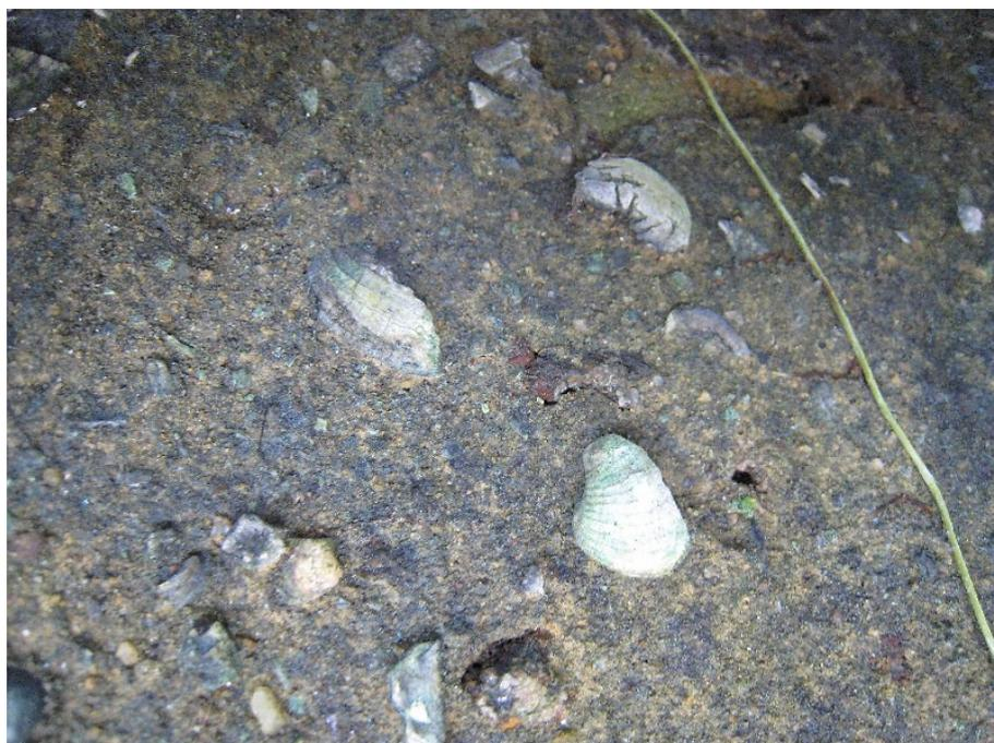
**Figura 71** – Parede construída utilizando-se o sernambi misturado
