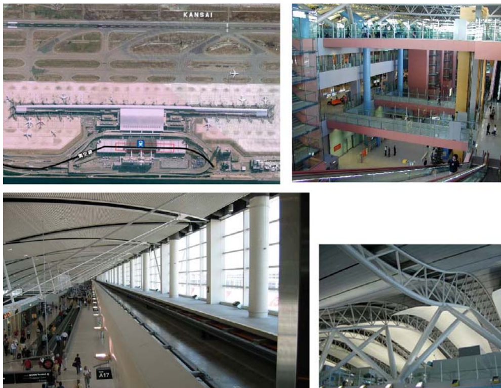
Figura 2.25: Imagem aérea e fotos internas do Aeroporto de Kansai, em Osaka, Japão
