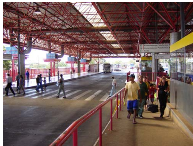
Figura 4.11: Goiânia - exemplo de circulação no nível do solo em terminal de integração
