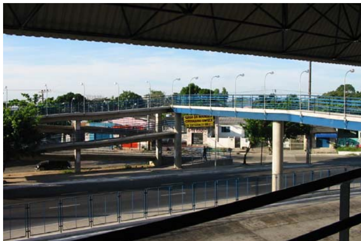
Figura 4.18: Manaus - foto de passarela de acesso do Terminal T4
