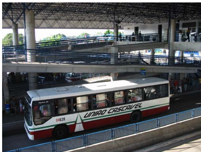
Figura 4.12: Manaus - exemplo de circulação em nível diferenciado do solo através de rampas em terminal de integração
