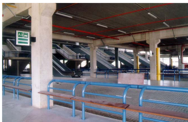
Figura 4.6: Belo Horizonte - Estação Barreiro – plataformas e escadas rolantes de acesso ao segundo piso
