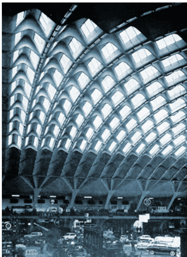
Figura 2.22: Hall do Centro de Exposições de Turin Fonte: Canadianarchitect (2006).
