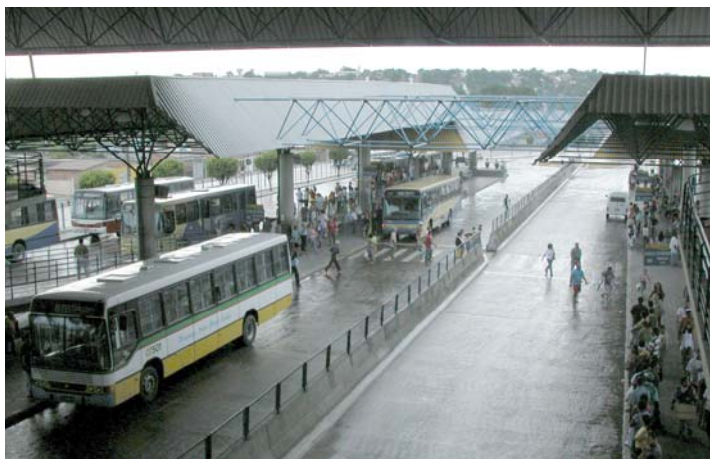
Figura 4.15: Manaus - Terminal T4 (2006) - nova travessia de pedestre no nível do solo Fonte: Antônio Carlos Vandanezi Alvim.
