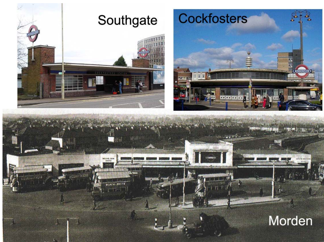
Figura 2.17: Estações de integração ônibus metrô em Londres, Charles Holden. Fonte: Estações Southgate e Cockfosters, Metrobits (2006); Estação Morden, Sort (2006, p.35)
