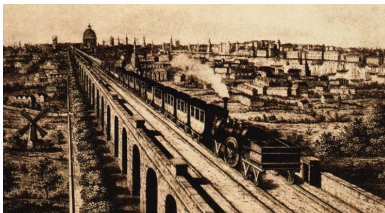
Figura 2.2: London & Greenwich Railway, ferrovia construída sobre viaduto, 1836
