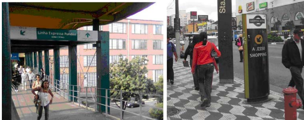
Figura 2.34: Passarela de conexão entre o Shopping Nova América e a estação Del Castilho, Rio de Janeiro; acesso ao Shopping e à Estação Santa Cruz, São Paulo
