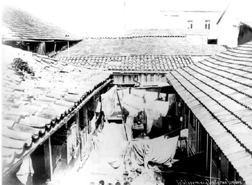
Imagem 7- Cortiço da Rua do Senado nº12 a 44. Malta, 27/03/1906. Fonte: AGCRJ
