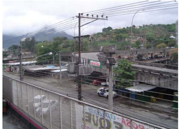
Imagem 33- (vista B) Esta fotografia mostra o Viaduto Angenor de Oliveira, em frente à quadra da Escola. Embaixo do viaduto podemos observar o posto policial e diversos trailers que funcionam como bares.
