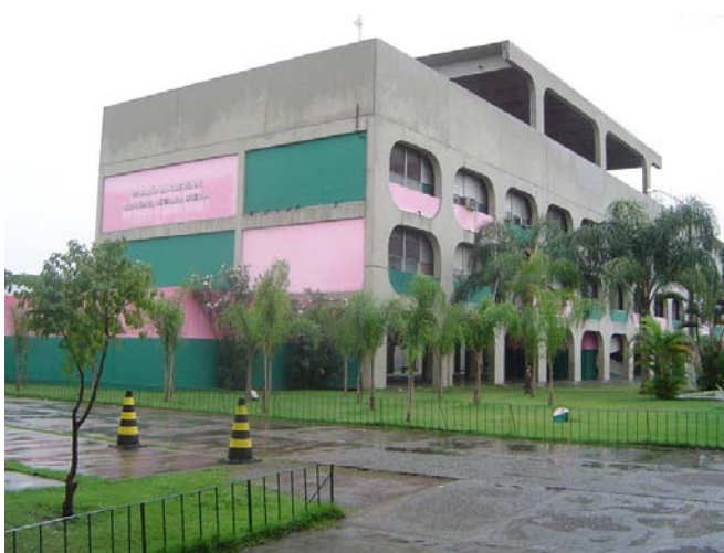
Imagem 49- CIEP – parte do Programa Social da Mangueira coordenado pela Escola. Podemos observar o perfeito estado de conservação da edificação e as cores verde e rosa, como encontramos nos diversos outros espaços do Programa
